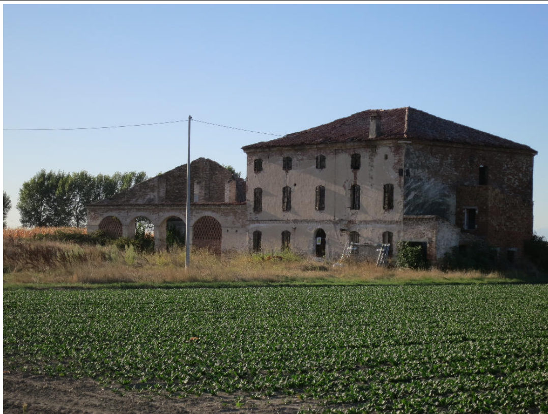
Fotografia 2 – Vista da sud-est di Corte Bosco. [fotografia dell'autore]
