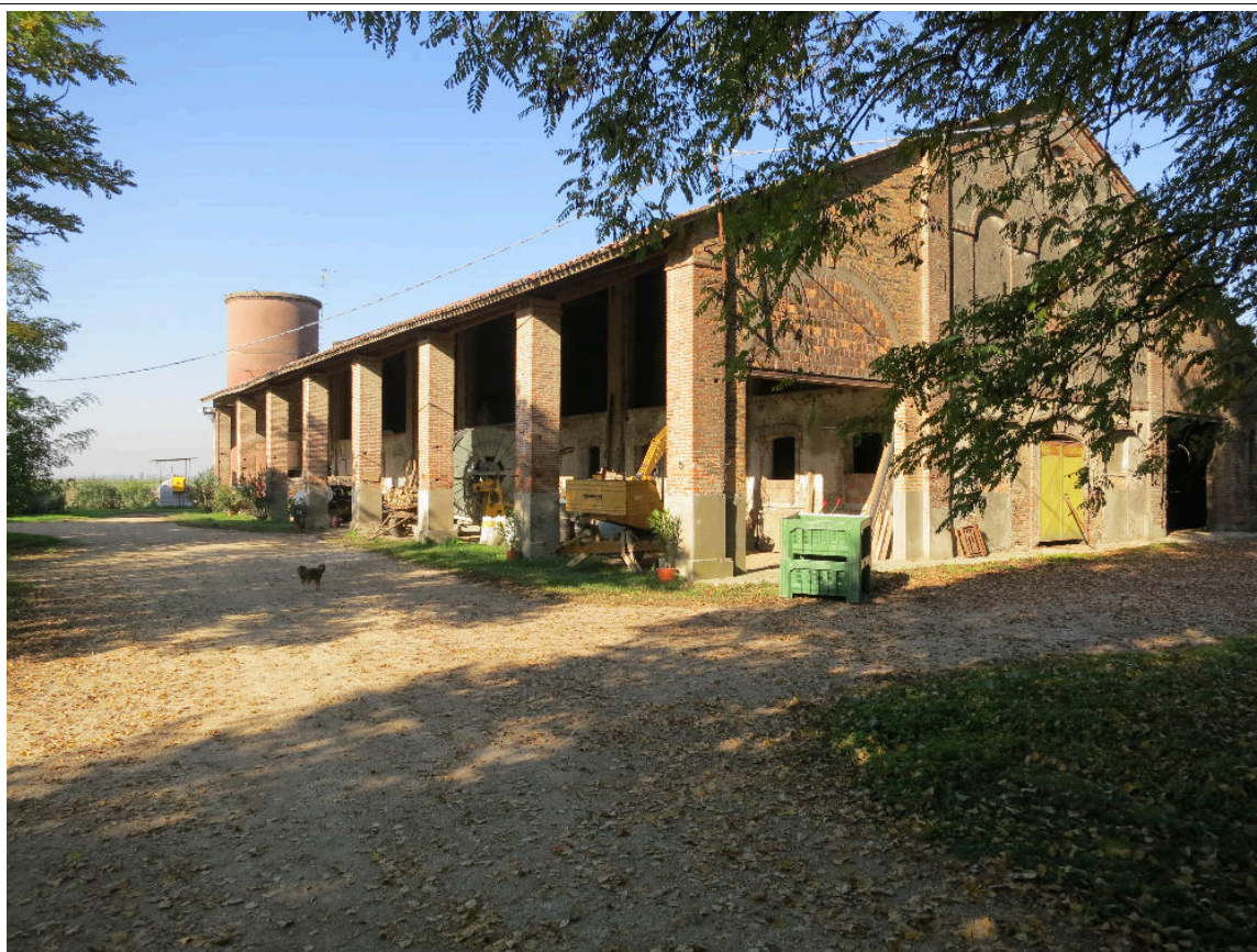
Fotografia 4 – Il complesso stalla-portico-fienile ripreso dall'ingresso della corte rurale. [fotografia dell'autore]
