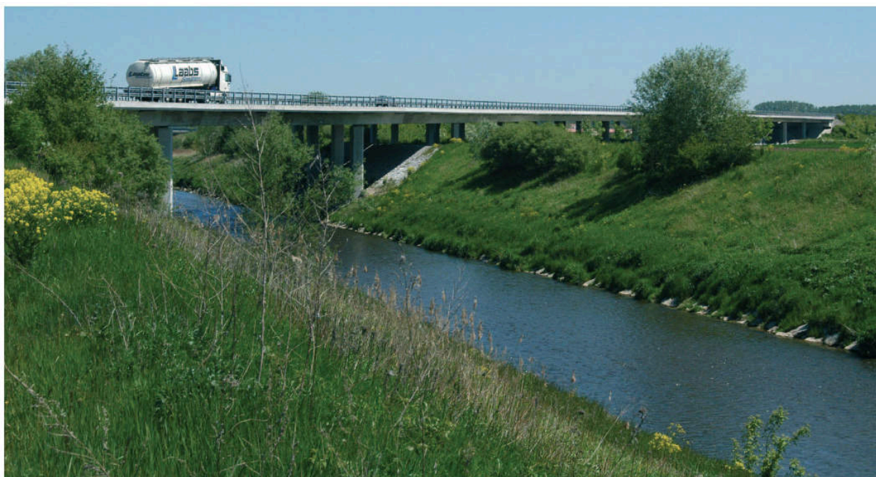
Fotografia 49: Il ponte sul Canale della Broye, sul tracciato dell'autostrada N1 svizzera. (Fonte: AA.VV., 2005. Fauna selvatica ed infrastrutture lineari..., op. cit.)
