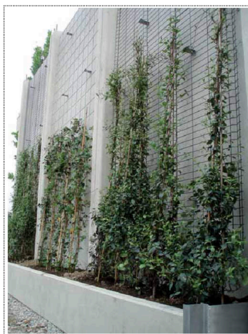
Fotografia 46: Barriere acustiche di tipo opaco con mitigazione a verde sulla parte esterna (Fonte: PaverVia S.p.A.)
