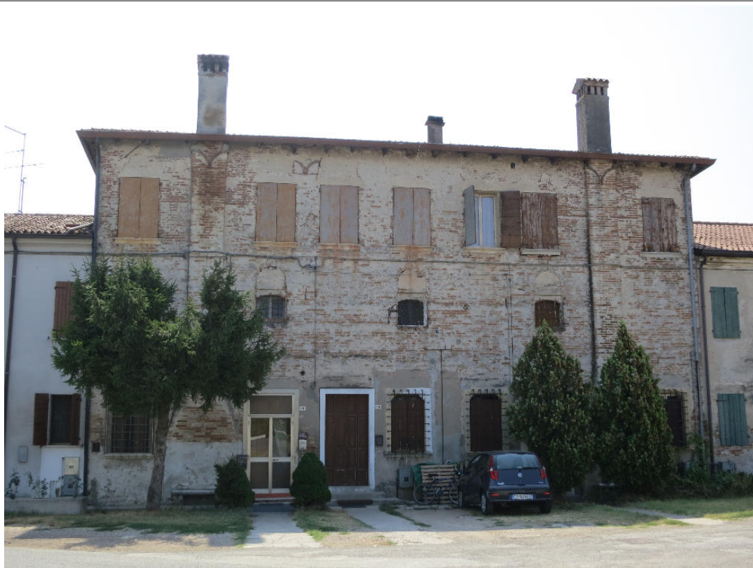
Fotografia 8 – La condizione odierna della facciata nord. (fotografia dell'autore)
