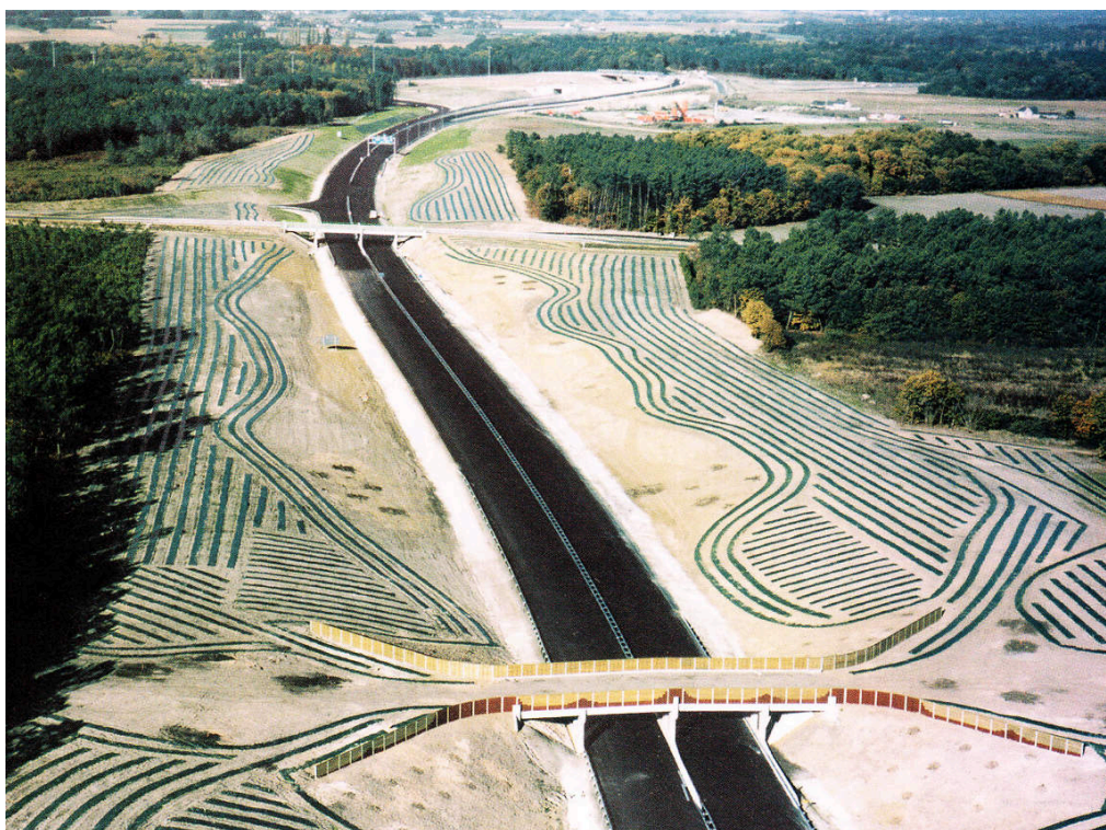
Fotografia 27: Movimenti di terra e piantumazioni sul tracciato dell'Autoroute A.85, in corso d'opera. (Fonte: Maffioletti S., Rocchetto S., op.cit.)
