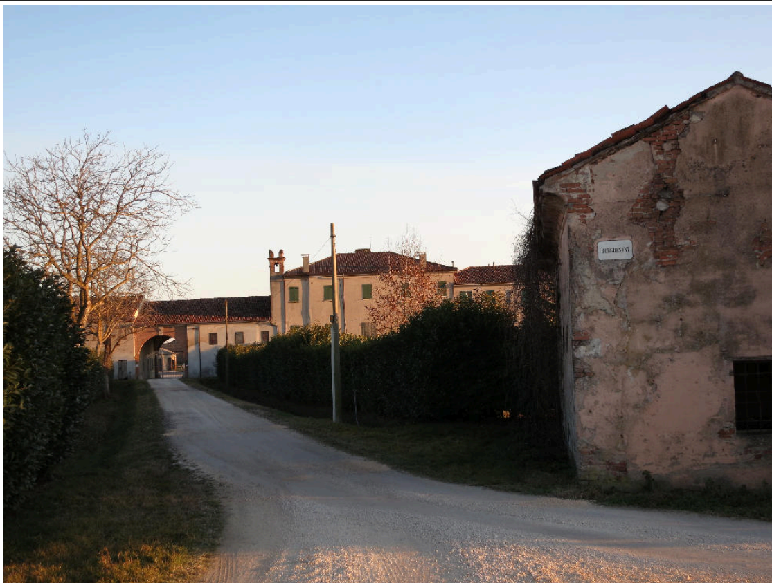
Fotografia 2 - Ingresso della Corte sulla S.P. 47A (fotografia dell'autore)
