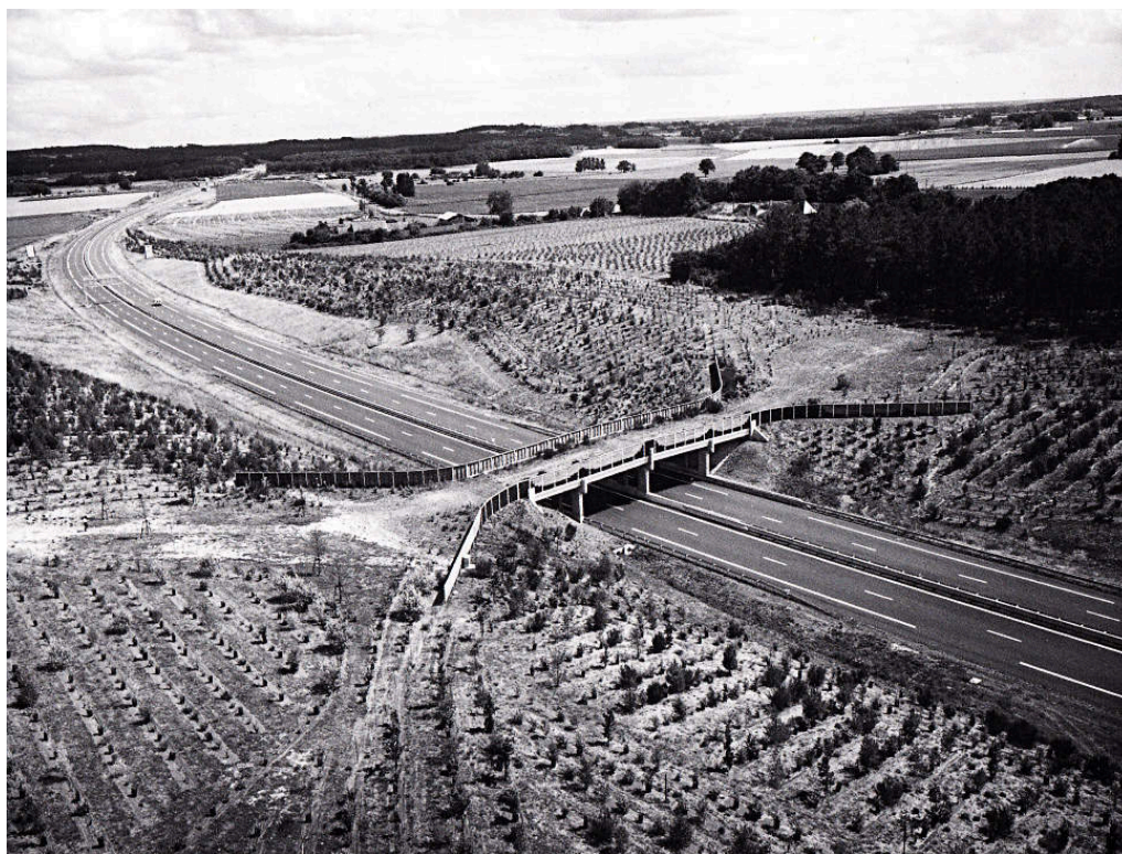
Fotografia 28: Movimenti di terra e piantumazioni sul tracciato dell'Autoroute A.85, lavori completati e filari di piante in accrescimento. (Fonte: Ponticelli L., Micheletti C., op.cit.)
