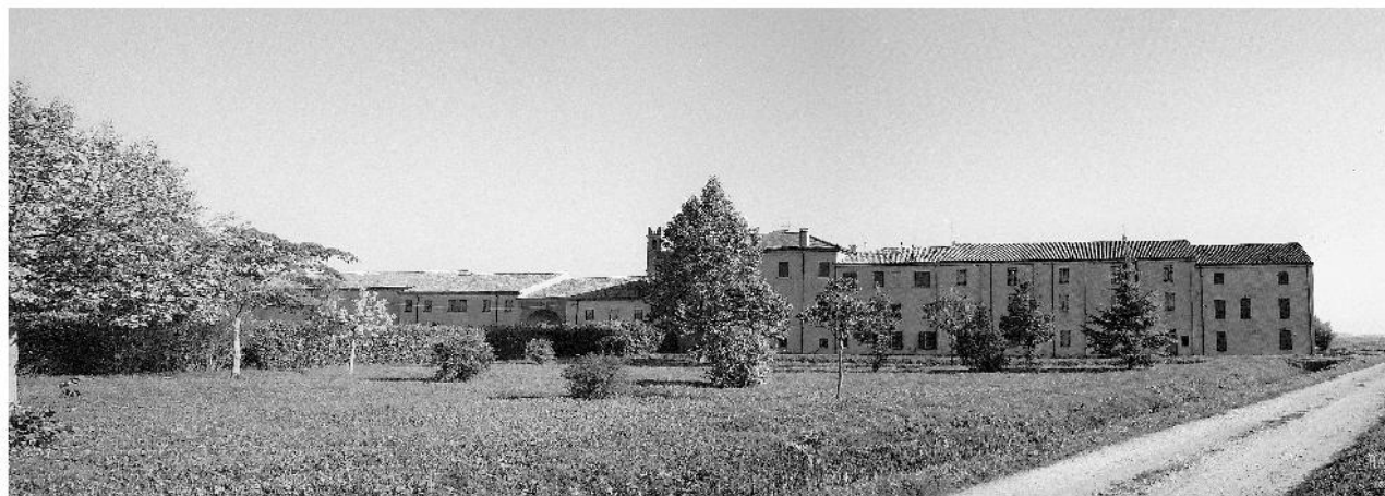
Fotografia 10 – Panoramica della facciata nord della Corte. [fotografia dell'autore]
