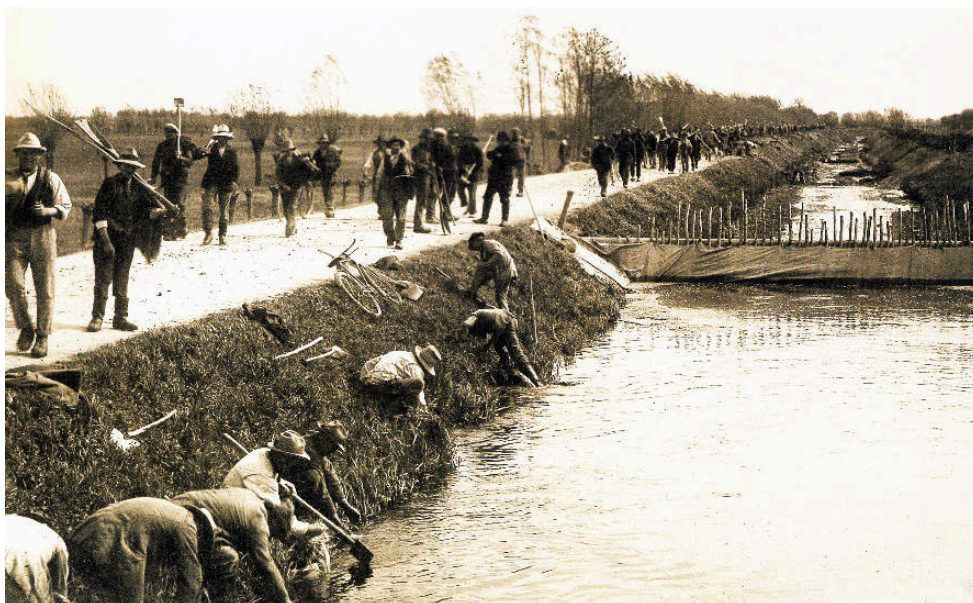
Fotografia 12: La costruzione di una rosta per prosciugare parte del fiume Menago negli anni '50. (Fonte: Morin G., Gagliardi R.S., op.cit.)
