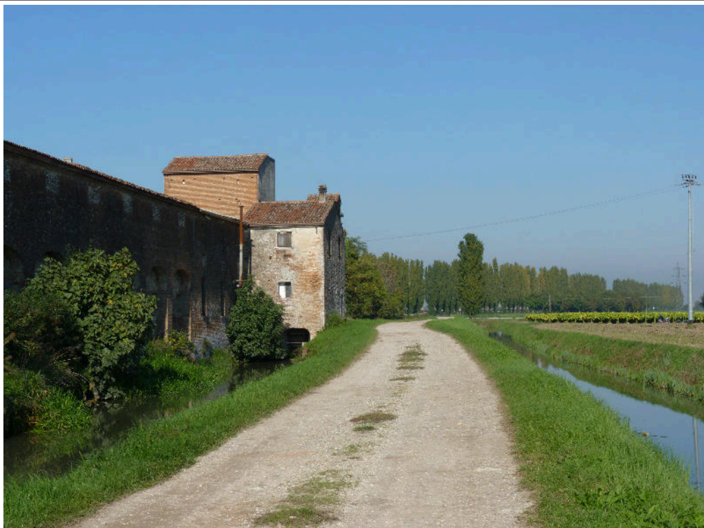
Fotografia 4 – L'edificio sullo Scolo Seriola ed il filare che costeggia lo stesso a nord del complesso della corte rurale. [fotografia dell'autore]
