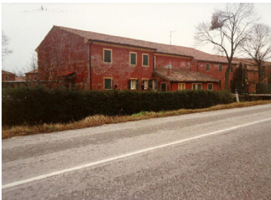
Fotografia 8 – Vista esterna da nord-est. [fonte: FERRARI S., op.cit, 2003.]
