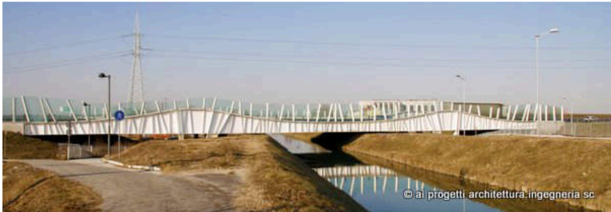
Fotografia 38: Un viadotto del Passante di Mestre a scavalco del Canale Taglio e della strada provinciale che collega Mira a Mirano. Le travi di spalla laterali e le barriere acustiche sono state progettate richiamando la silhouette di un canneto tipico dell'area veneziana. (Fonte: Studio A.I. Progetti)
