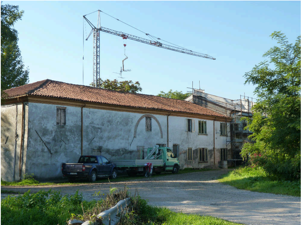
Fotografia 3 – Il lato nord di uno degli edifici che formano il complesso della corte rurale. [fotografia dell'autore]
