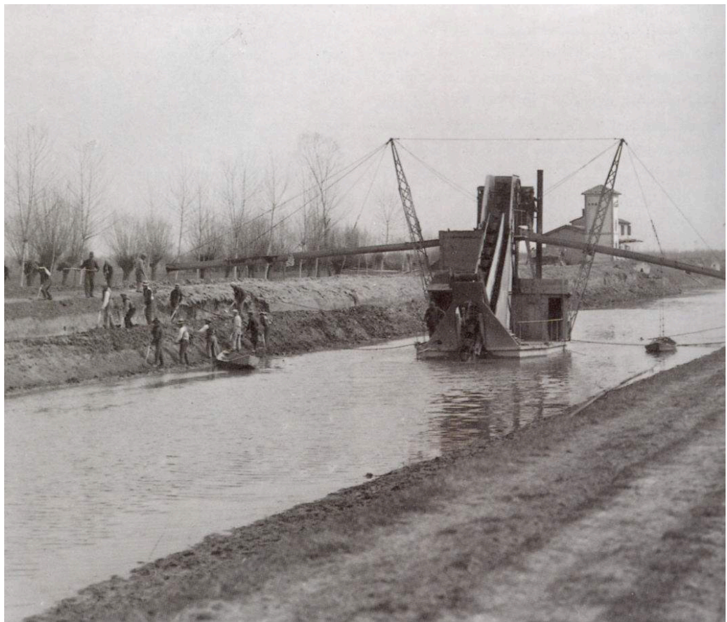
Fotografia 7: Scavo della Fossa Maestra con una draga negli anni '30 (Fonte: Consorzio di Bonifica Veronese)
