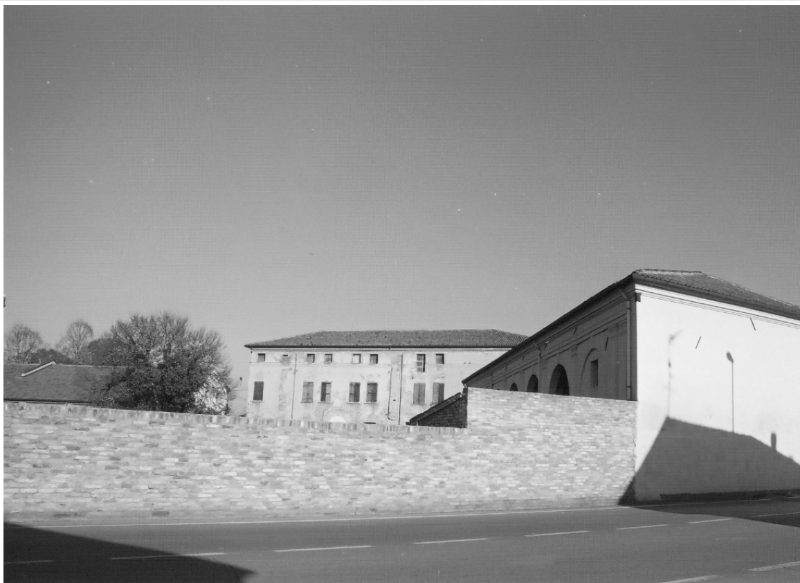
Fotografia 5 – Il muro di cinta del complesso. [Fotografia dell'autore]
