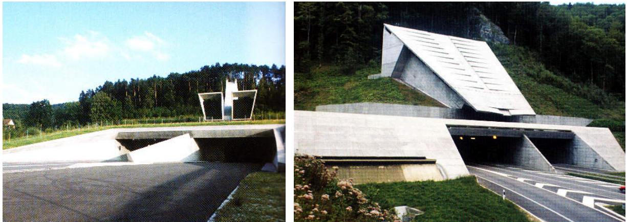
Fotografia 34: Due imbocchi di galleria dell'Autostrada A16 svizzera (Fonte: MAFFIOLETTI S., ROCCHETTO S., op. cit.)
