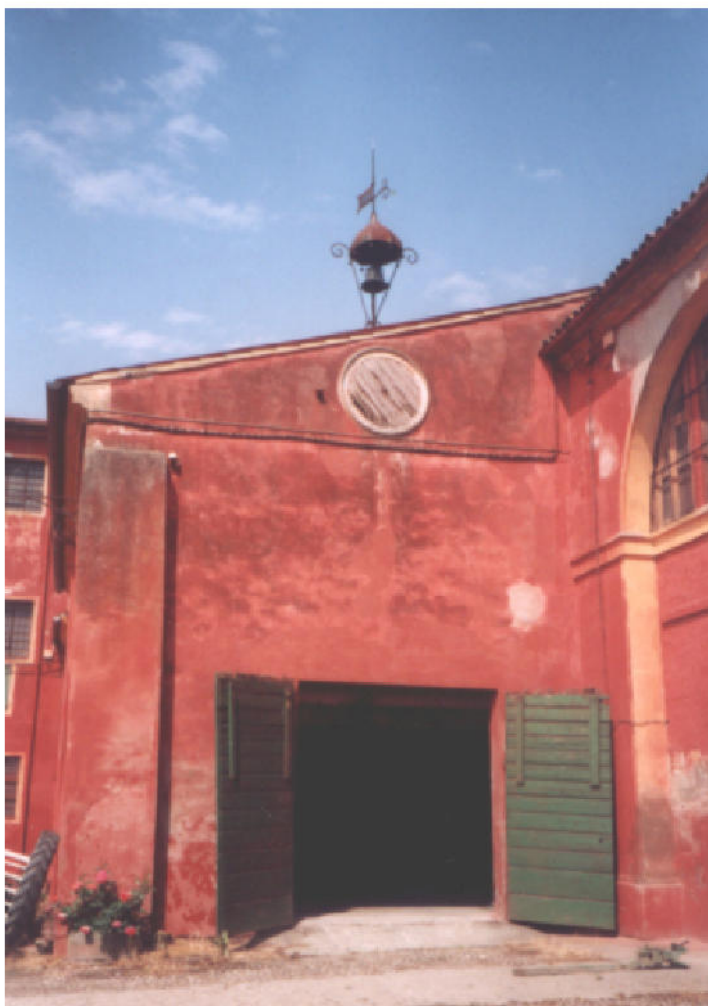
Fotografia 5 – Particolare di uno degli edifici del complesso. [fonte: FERRARI S., op.cit, 2003.]
