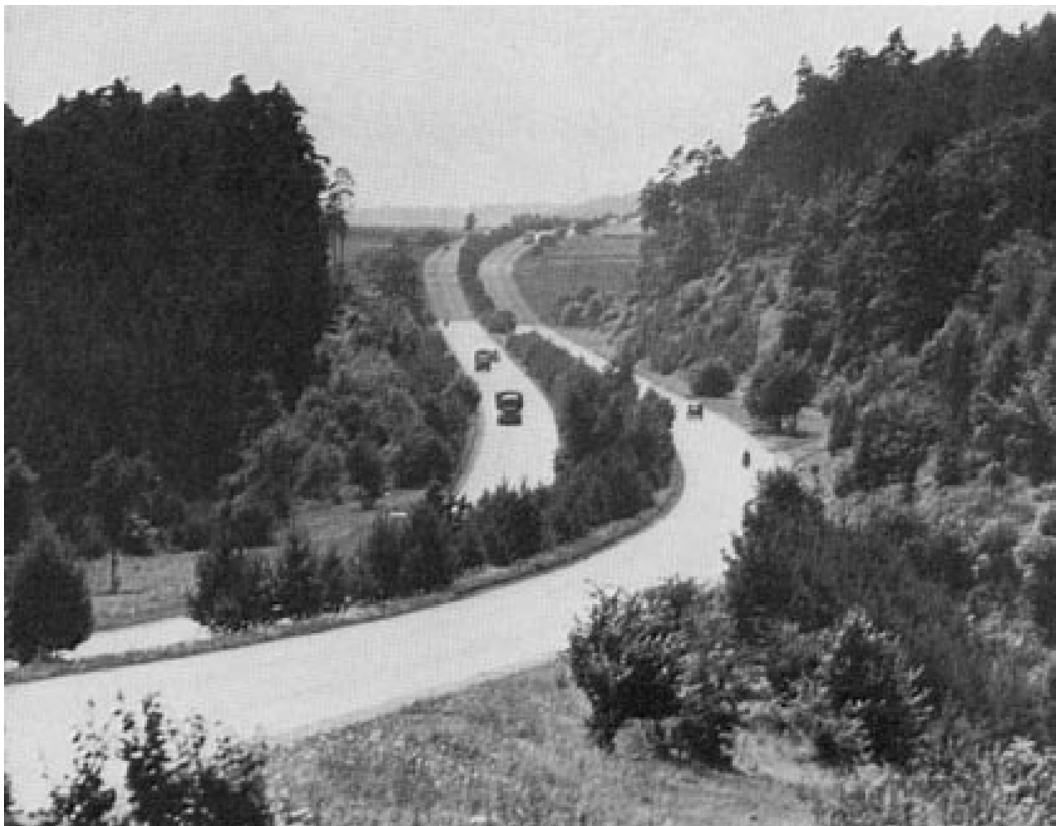
Fotografia 24: Autobahn Frankfurt-Kassel. La fascia spartitraffico centrale permette di stabilire una continuità con il paesaggio circostante, che a sua volta non viene schermato dalla vegetazione ai bordi dell'autostrada. (Fonte: Morelli E., op. cit.)
