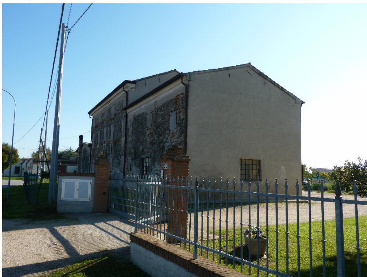
Fotografia 2 – Vista da ovest della Villa. [fotografia dell'autore]
