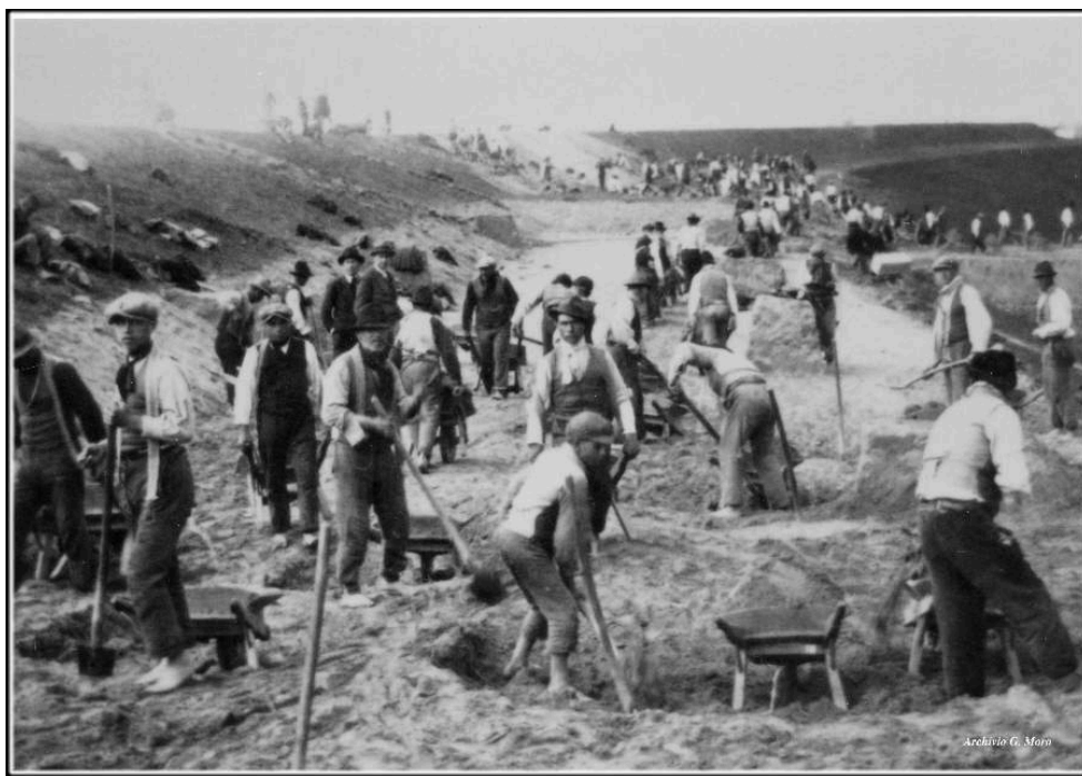
Fotografia 52: Scariolanti all'opera nello scavo di un canale di bonifica, primi anni del '900. (Fonte: portale web Consorzio di Bonifica Veronese)
