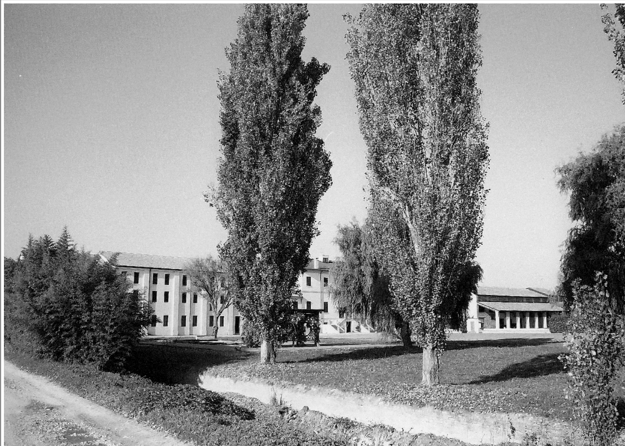
Fotografia 13 – Vista da sud-est del complesso principale della corte. [fotografia dell'autore]
