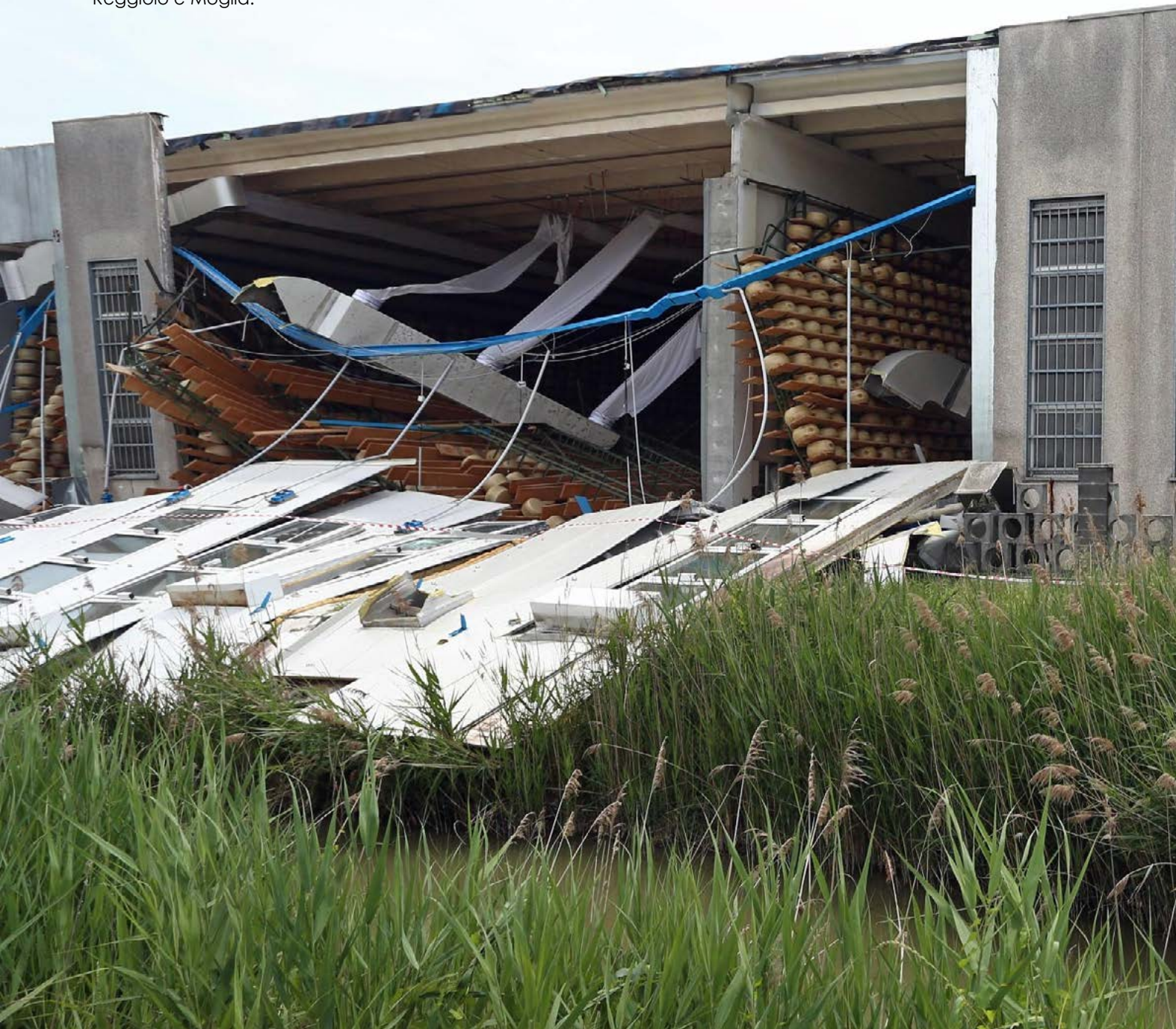
fig. 30 Ribaltamento della facciata alla latteria sociale "Tullie" tra i comuni di Reggiolo e Moglia.
