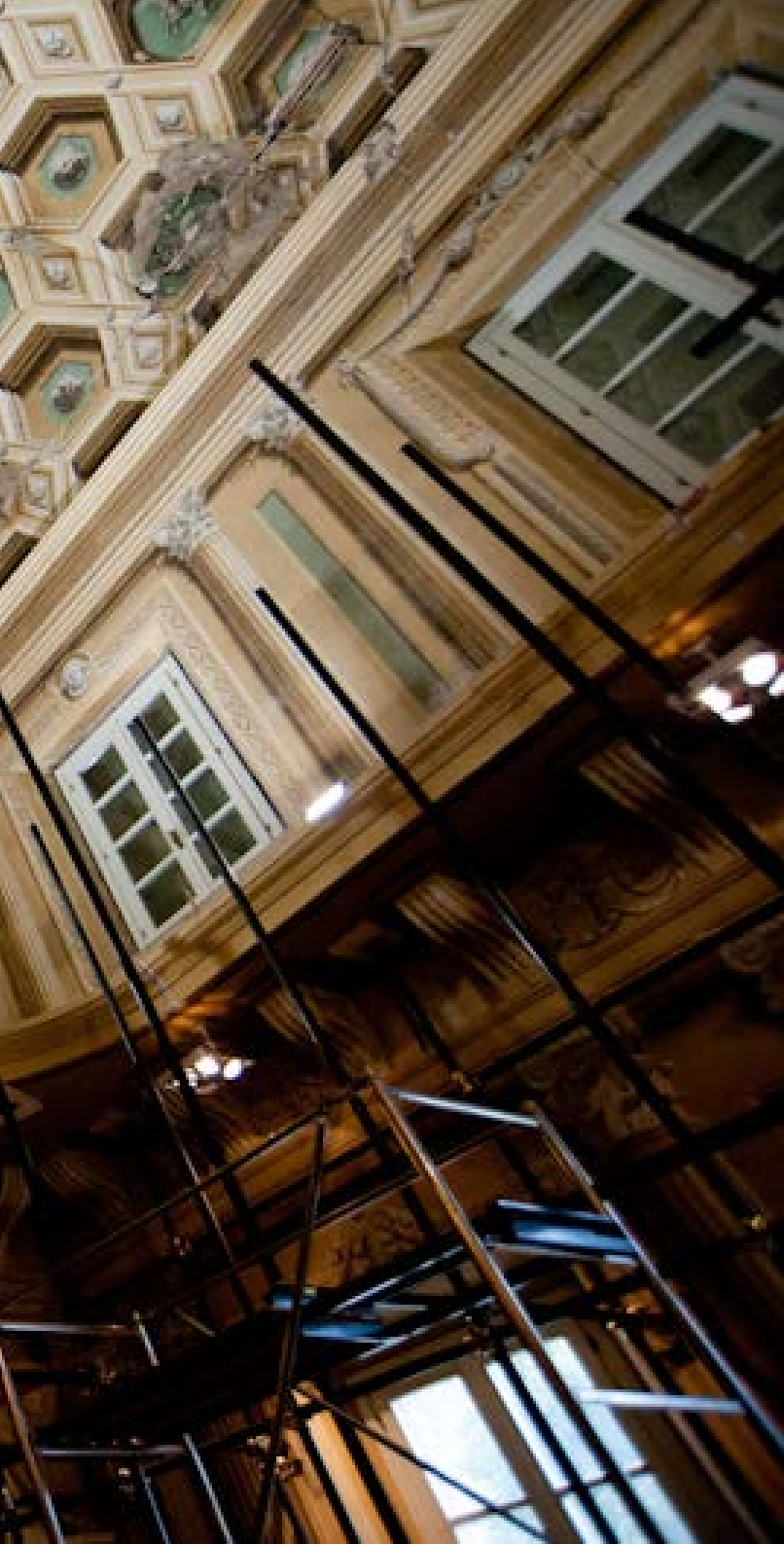
fig. 100 Il Palazzo Saraceni sede della biblioteca comunale
