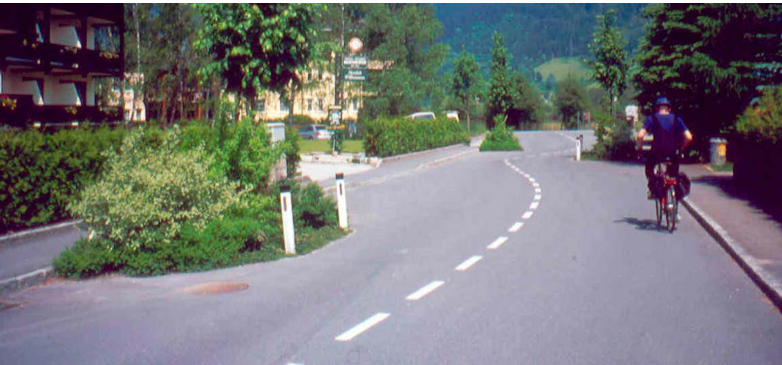
fig. 91 Esempio di chicane in Svizzera su strada locale
