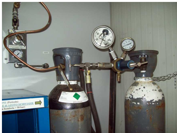
Figura 14 : Alimentazione Azoto e Ossigeno.
