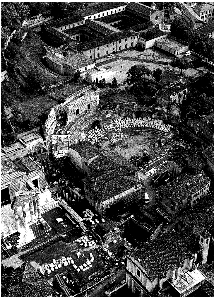
Fig. 14- Teatro romano di Brescia – vista a volo d’uccello dell’area.
