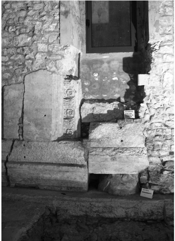
Fig. 23- Uno scorcio delle stratificazioni sotterranee di Palazzo Martinengo.
