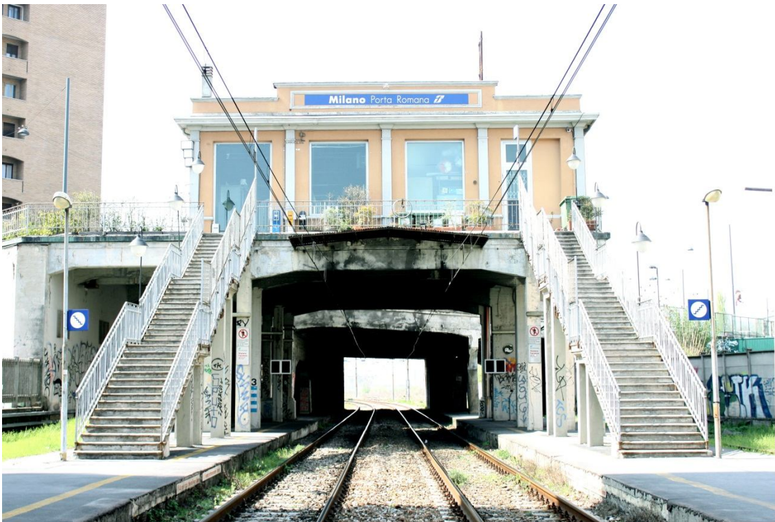
Figura 4: Palazzina liberty prima adibita a biglietteria, ora locale serale vista dalle banchine di attesa
