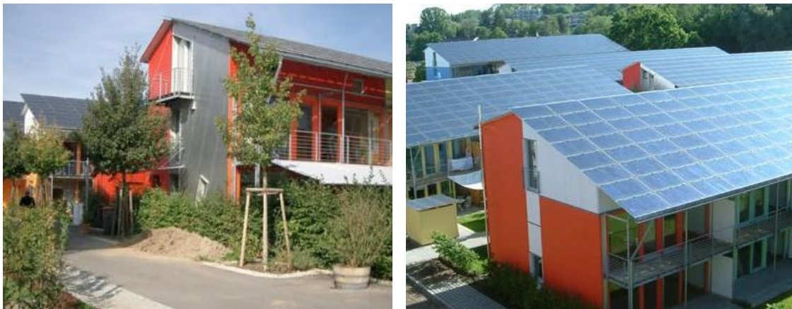
Figura 7: edifici residenziali a schiera del quartiere di Vauban. In copertura i pannelli fotovoltaici
