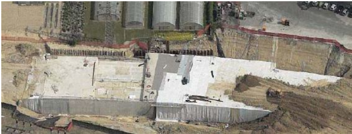
Figura 6: fase di costruzione della galleria artificiale sopra la “secante” di Cesena.
