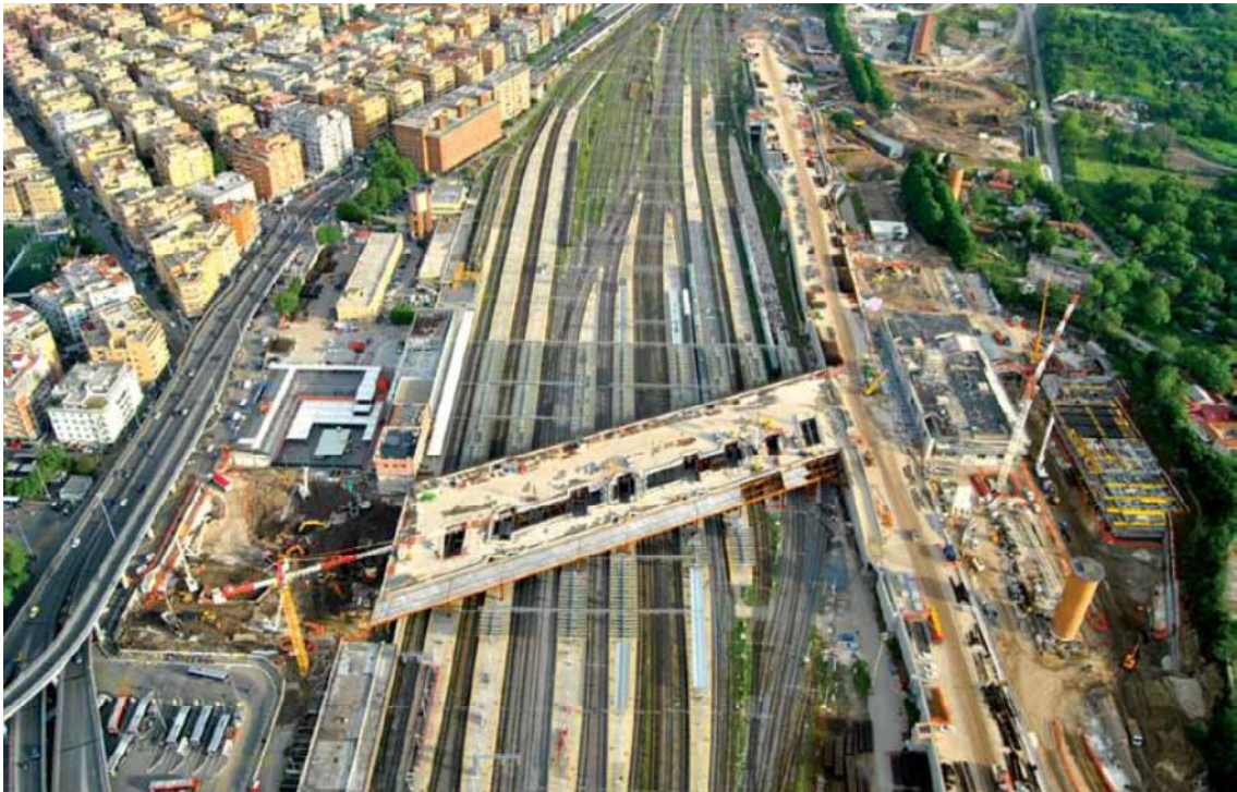
Figura 24: la costruzione della “piastra ponte”
