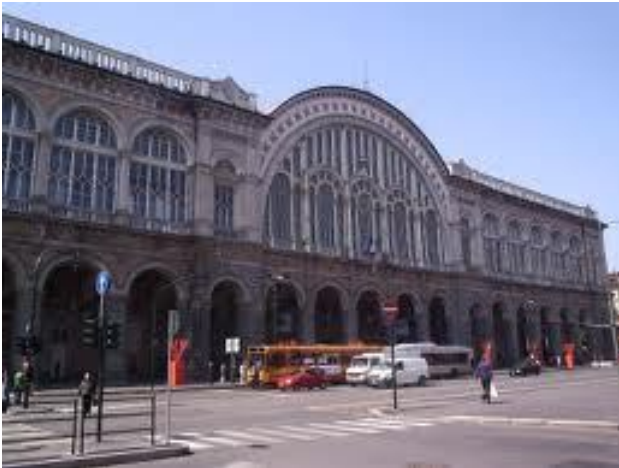
Fig. 7: la facciata della Stazione di Torino Porta Nuova
