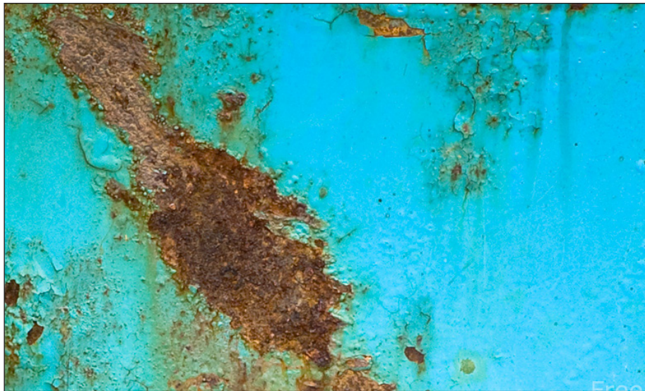
Immagine 13. Lastra in metallo rivestita da pittura. Nei punti in cui lo strato organico protettivo si è distaccato si nota un incremento di fenomeni corrosivi. Fonte: Free stock image.
