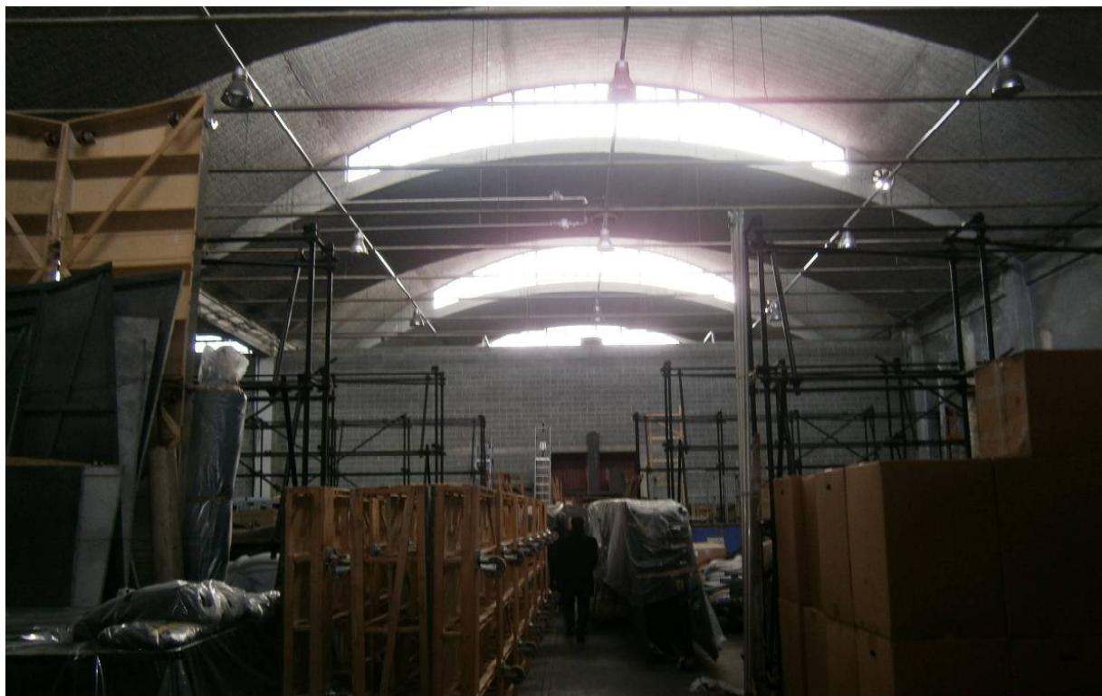
Figura 9.15. Vista frontale della parete di separazione in blocchi in cls vibrocompressato all'interno del corpo principale dell'edificio 3.
