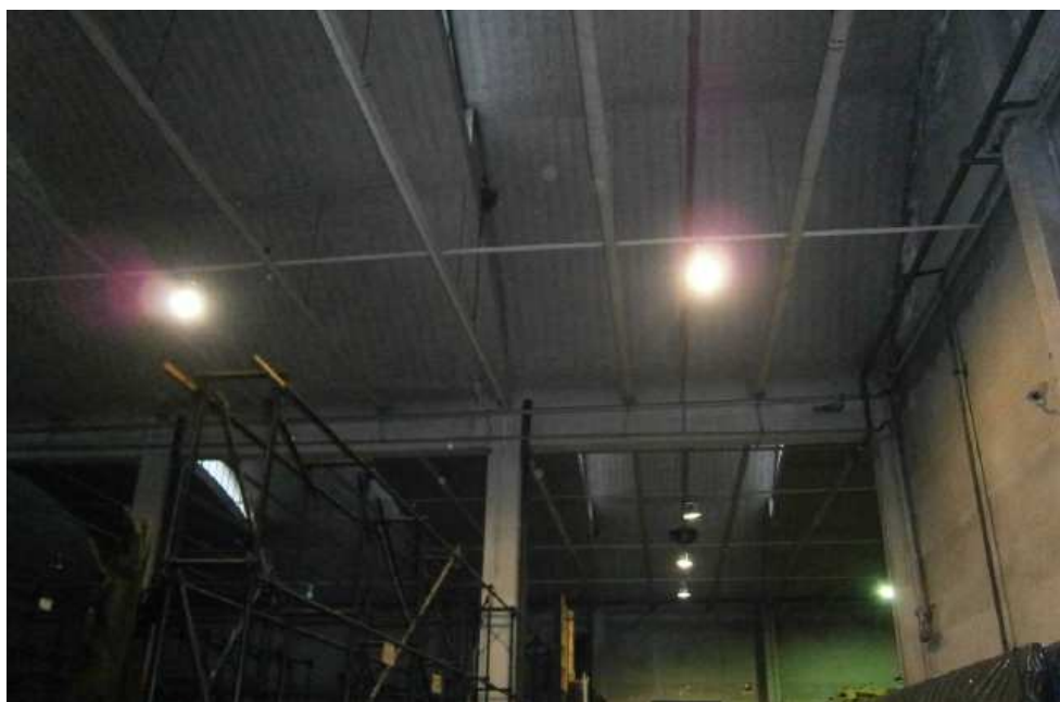
Figura 9.12. Vista interna edificio 3.
