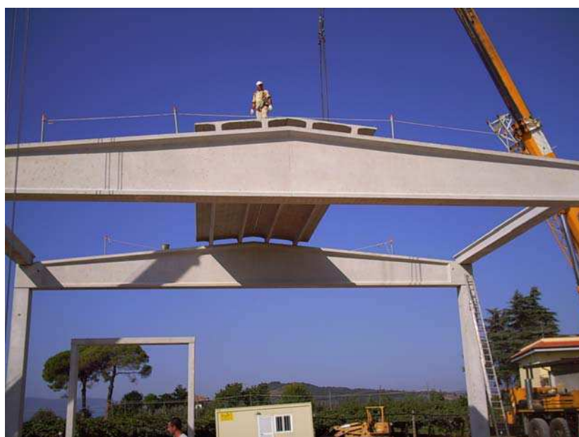
Figura 3.18. trave principale a doppia pendenza
