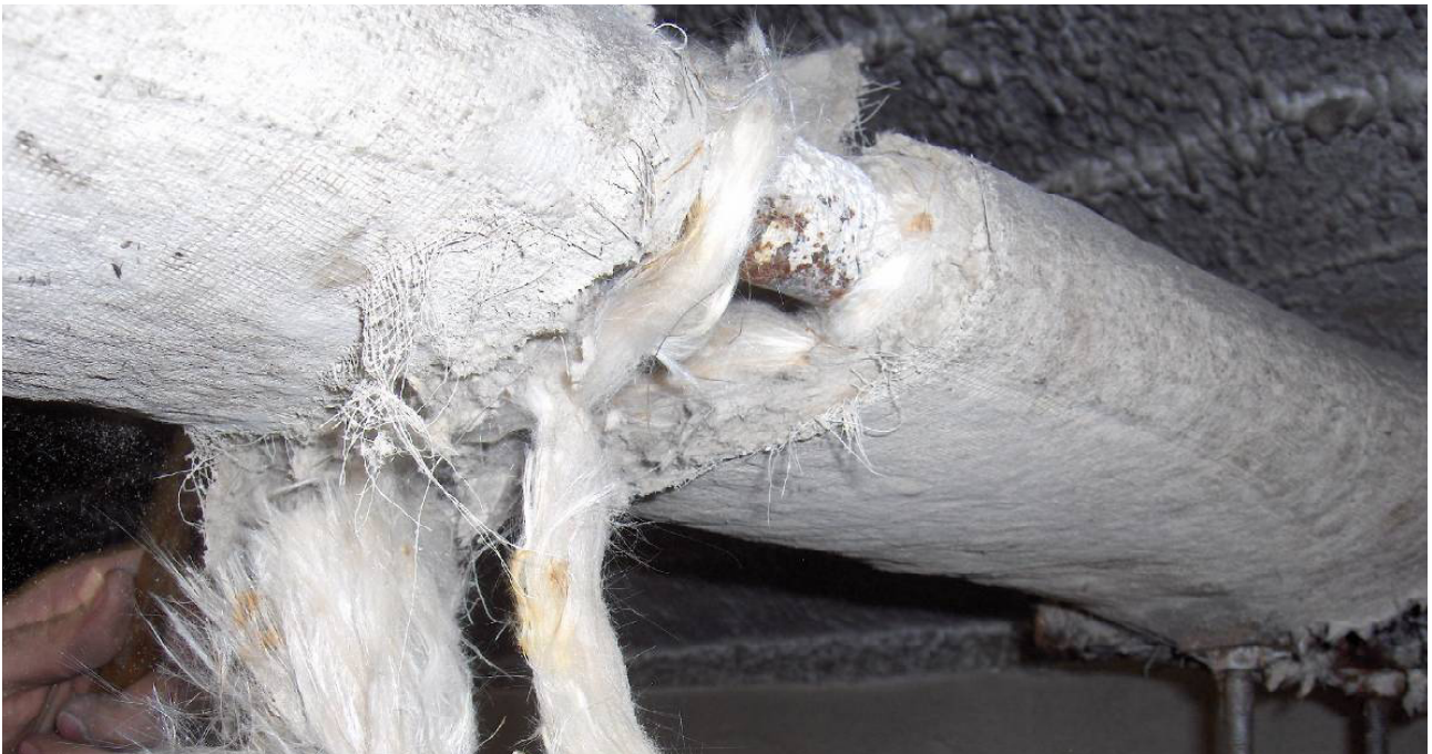
Figura 9.10. Tiranti rivestiti con lana minerale.
