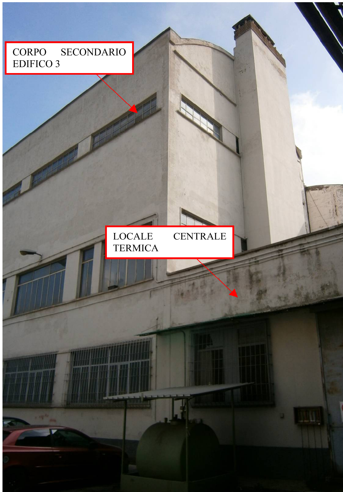
Figura 9.17. Corpo secondario edificio 3 con adiacente centrale termica.
