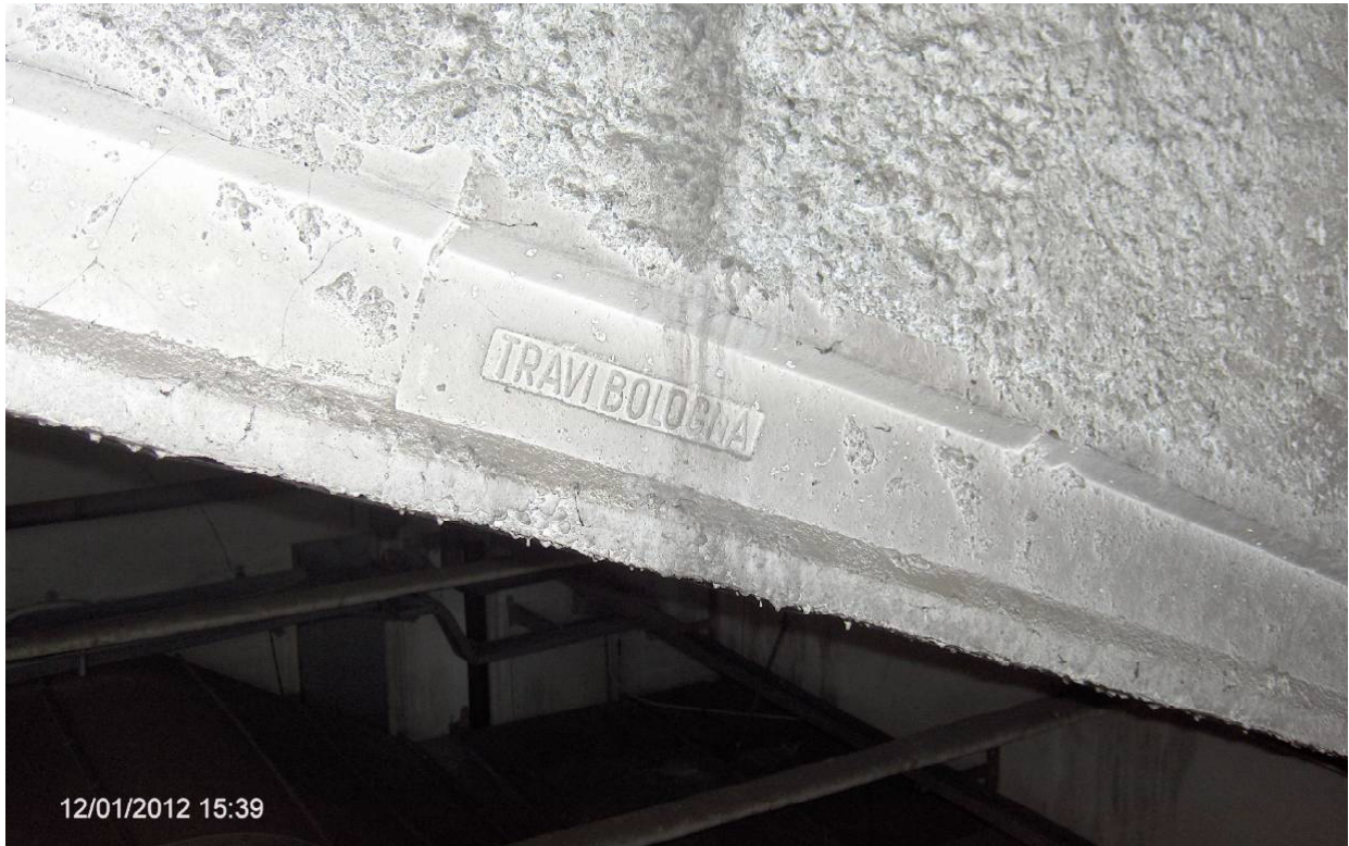
Figura 9.9. Travetti prefabbricati edificio 1
