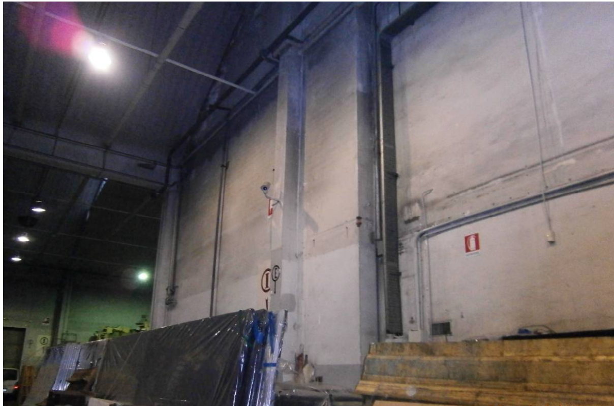
Figura 9.13. Edificio 3: Parete in muratura di separazione tra corpo principale e secondario.
