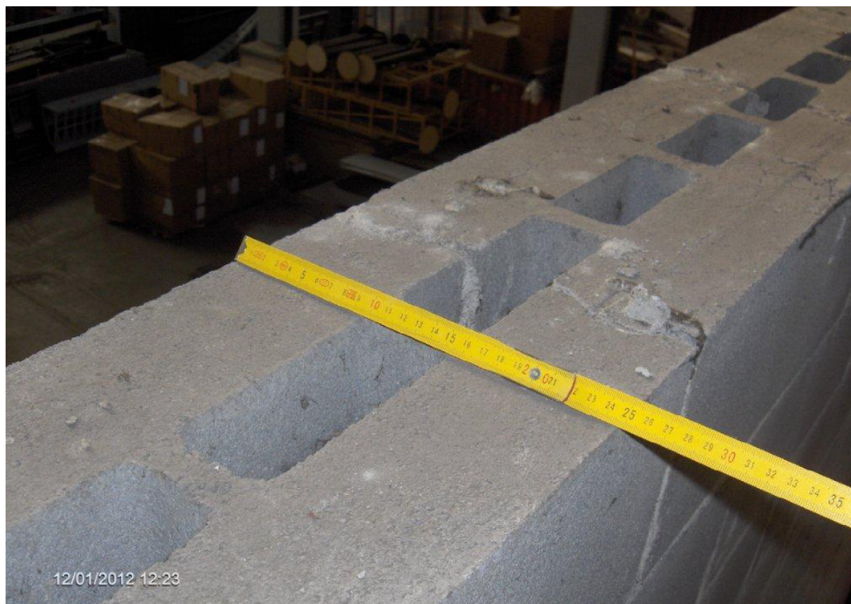
Figura 9.16. Particolare della parete in blocchi in calcestruzzo in corrispondenza della sommità.
