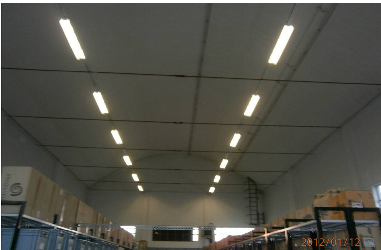
Figura 9.14. Edificio 3: Copertura a volta corpo secondario.
