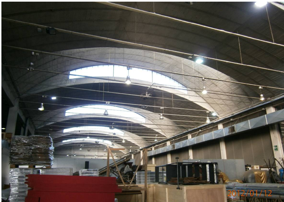
Figura 9.8. Vista interna edificio 1.
