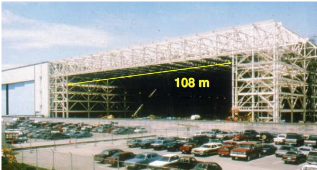
Figura 1.1. Capannone per copertura aerei con luce di 108 m
