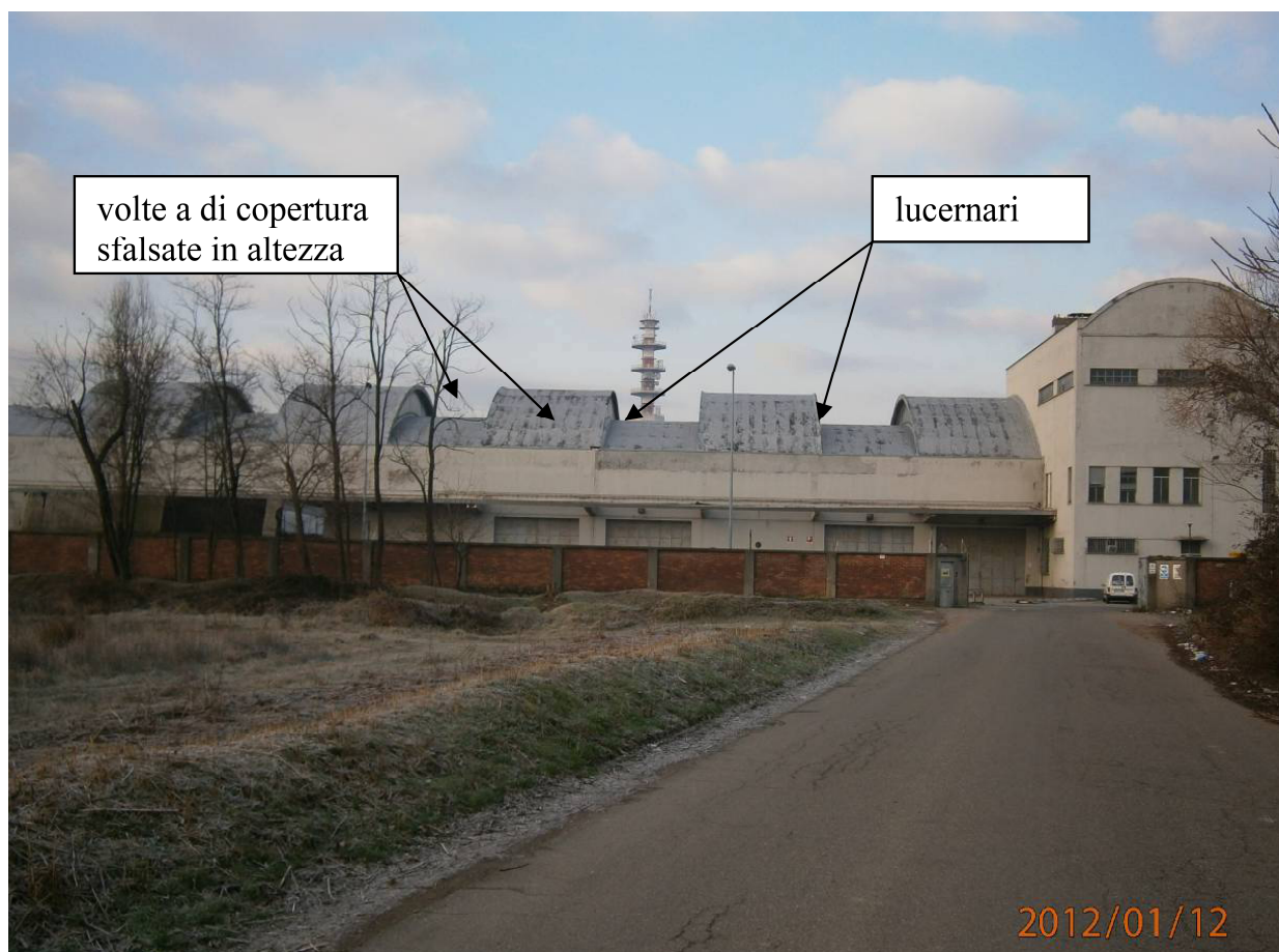
Figura 9.7. Vista dell'ingresso del complesso edilizio (fronte Edificio 3)
