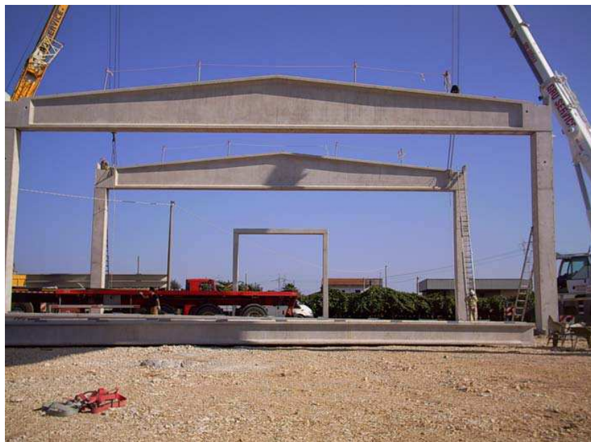
Figura 3.17. Vista capannone con pilastri incastrati alla base e capriate accoppiate a cerniera
