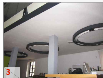
Vista del soffitto della sala
