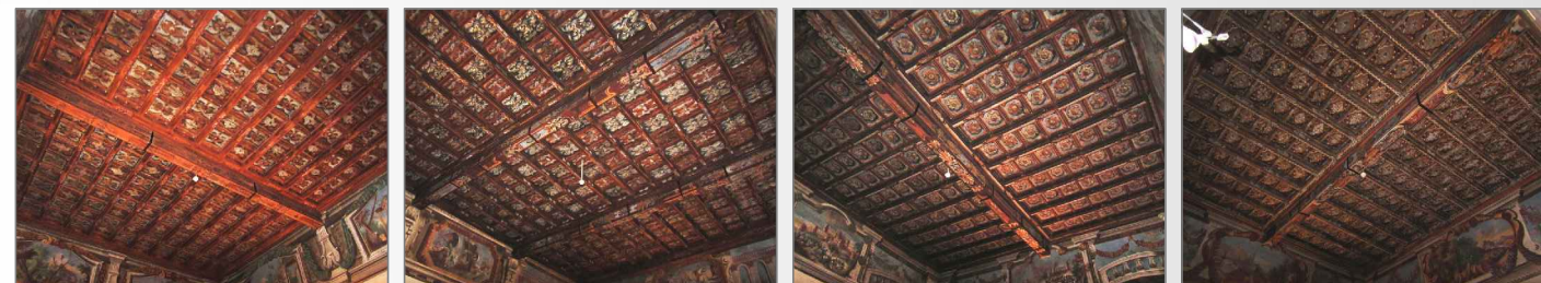
Soffitto ligneo sala A
