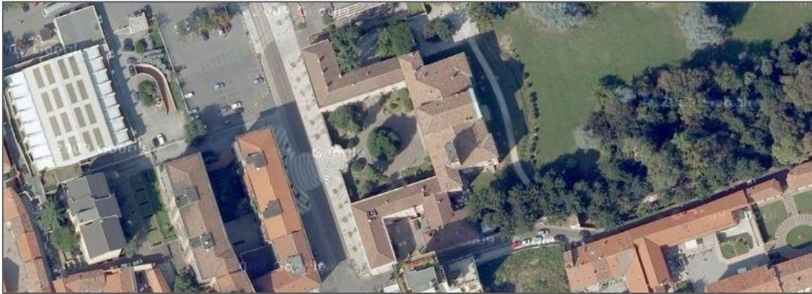
Figura 1: Vista del palazzo dall'alto
