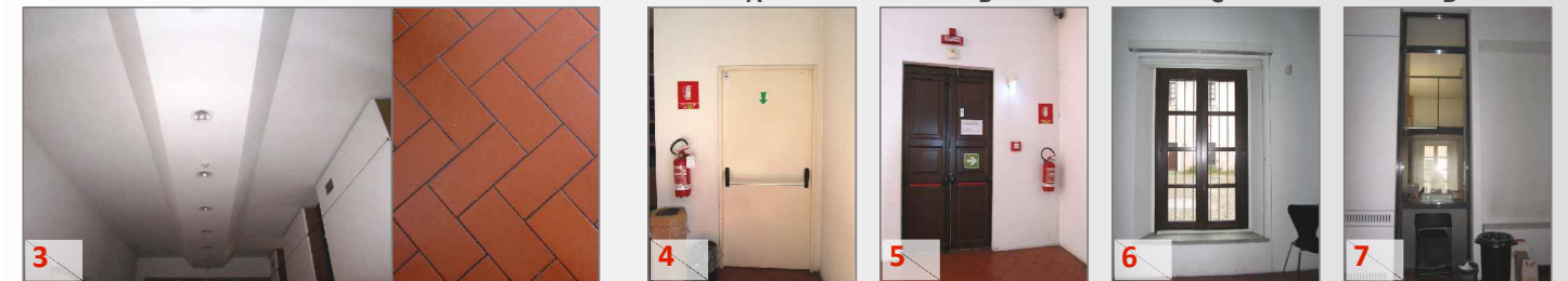
Particolare del soffitto e della pavimentazione
