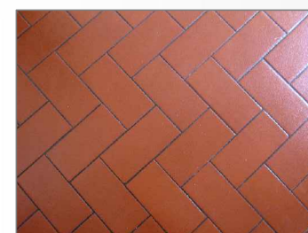
Particolare della pavimentazione della sala
