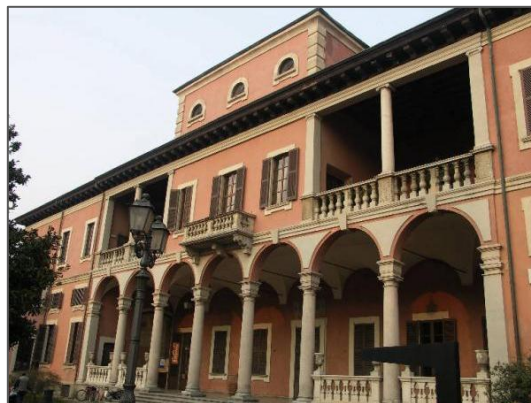
Figura 5: Prospetto ovest del corpo principale, verso la corte Grande
