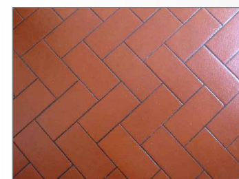
Particolare del pavimento della sala
