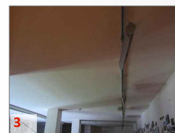
3 Vista del soffitto della sala
