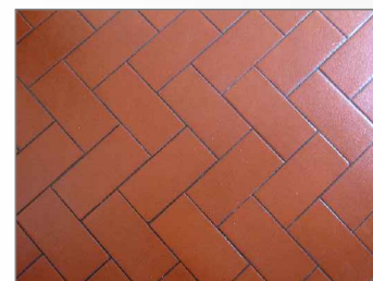
Particolare del pavimento della sala
