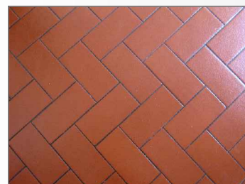
Particolare della pavimentazione della sala
