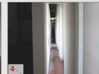
Particolare dell'intercapedine tecnica creata con il cartongesso
