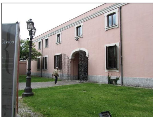
Figura 2: Prospetto sud del corpo settentrionale
