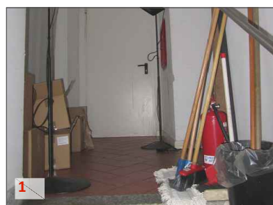
L'accumulo di materiale vario lungo le vie di fuga può rendere difficoltoso l'esodo forzoso dell'utenza, creando inciampo. Inoltre, lo spazio risulta ridotto per l'esodo di tutta l'utenza proveniente dalle sale espositive del piano primo e del piano ammezzato del Museo.
