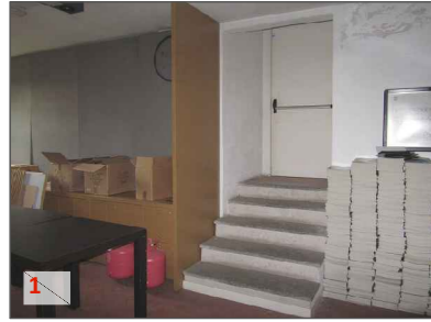
Il corpo storico centrale e l'ala meridionale sono collegate tra loro solo tramite questo passaggio, caratterizzato da 5 gradini e porta REI 120. Di conseguenza, non è presente un collegamento accessibile da disabile motorio tra le due ali.
