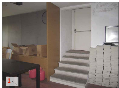
1 Rampa di cinque scalini di collegamento al piano terra tra corpo centrale e corpo meridionale
