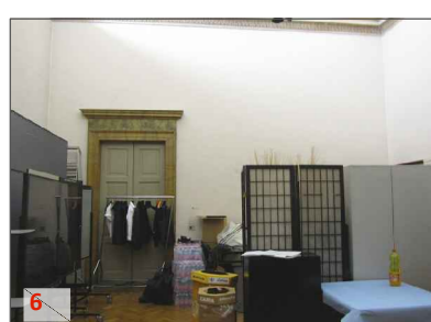
L'accumulo di materiale vario e indifferenziato all'interno del locale di deposito, locale riservato agli uscieri, potrebbe creare problemi di inciampo degli operatori che usufruiscono dello spazio, compromettendone l'esodo forzoso.
