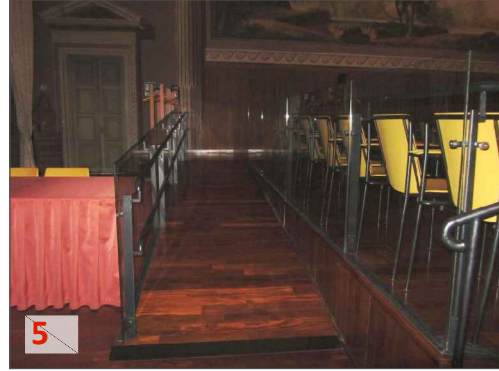
5 Rampa di accesso alla sala Grande
