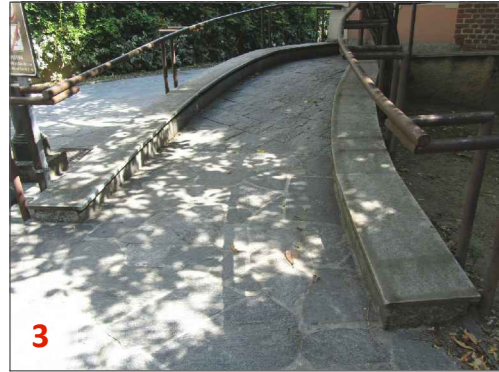
3 Rampa di accesso disabili
