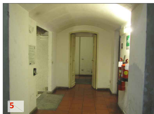
5 Vista dell'attuale corridoio di comunicazione. Sulla destra i bagni in disuso del piano terra
