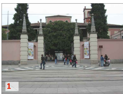
1 Ingresso pedonale-carrabile a Villa Ghirlanda da Via Frova
