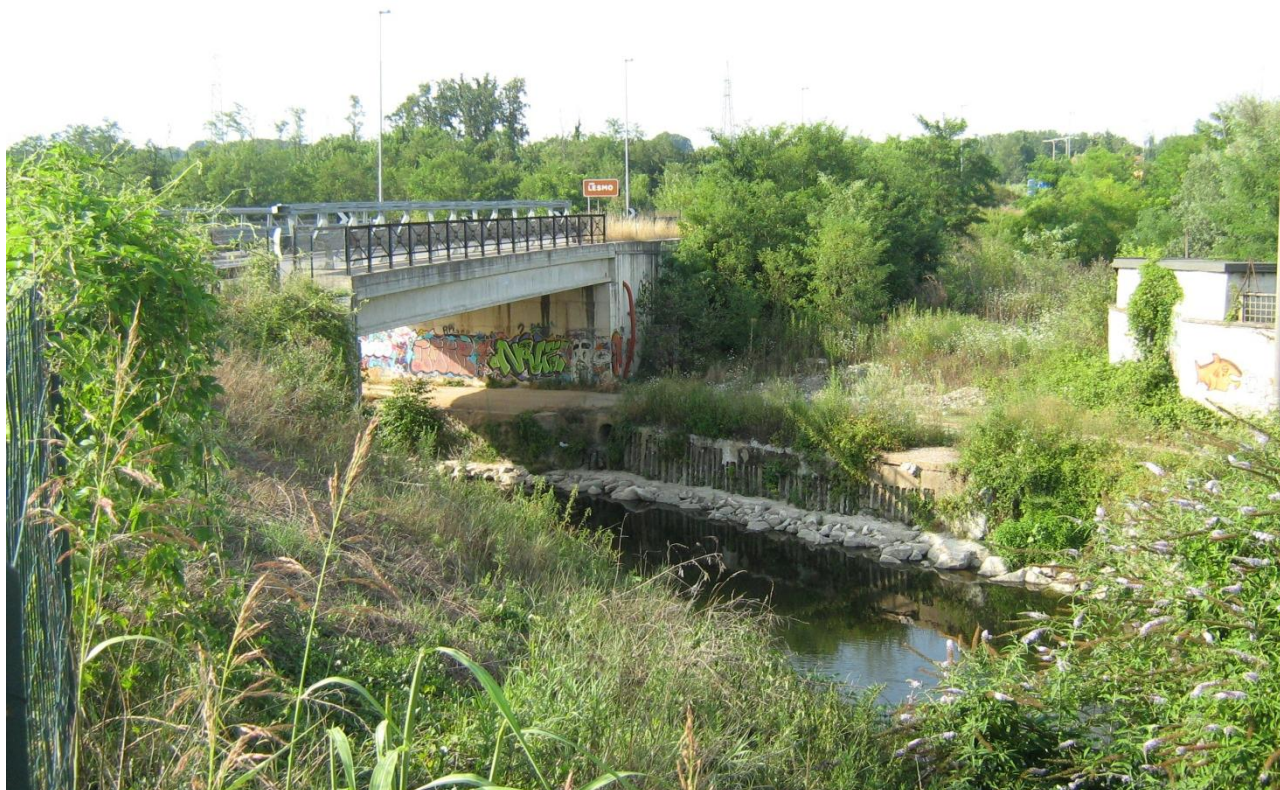
Fig. 5.15 – Ponte stradale via Galileo Galilei (Biassono)
