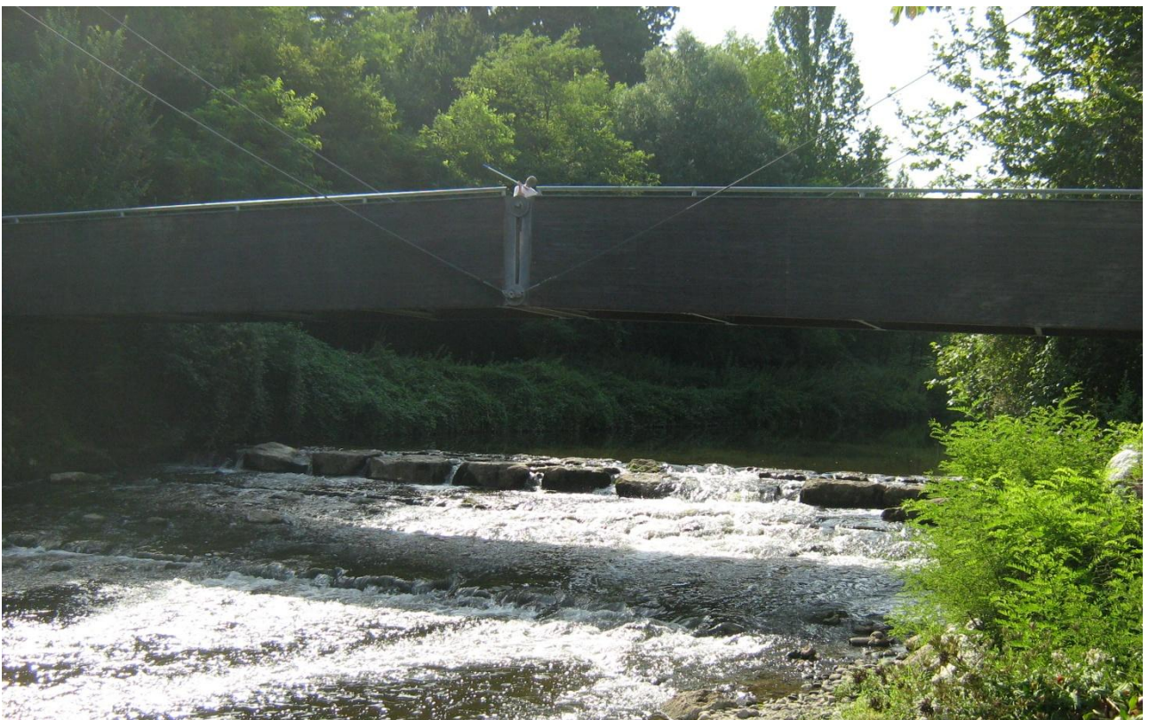
Fig. 5.14 - Ponte pedonale di Triuggio
