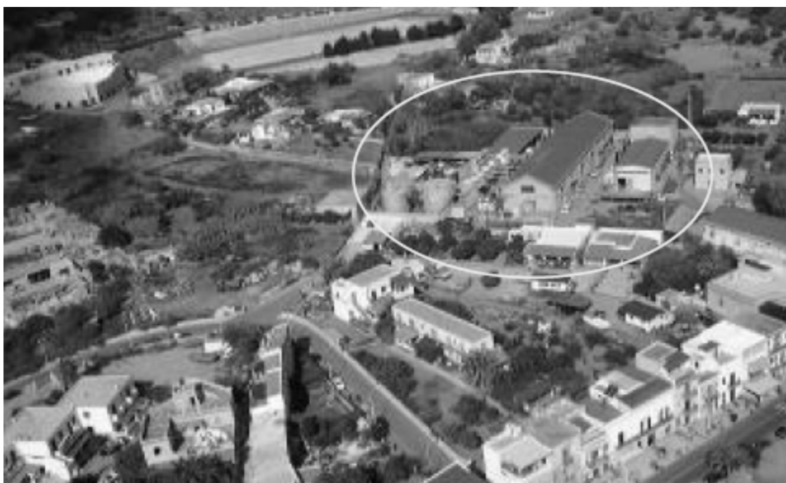
Fig. 2.11 - Centrale termoelettrica, Lipari
