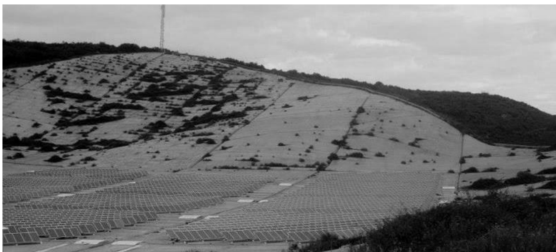
Fig. 2.10 - Impianto fotovoltaico sul monte Sant'Angelo - Lipari
