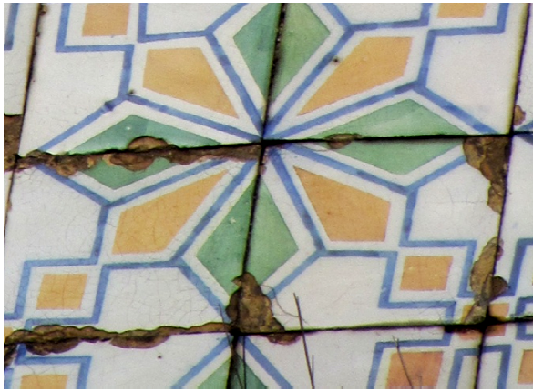
Edge crushing
