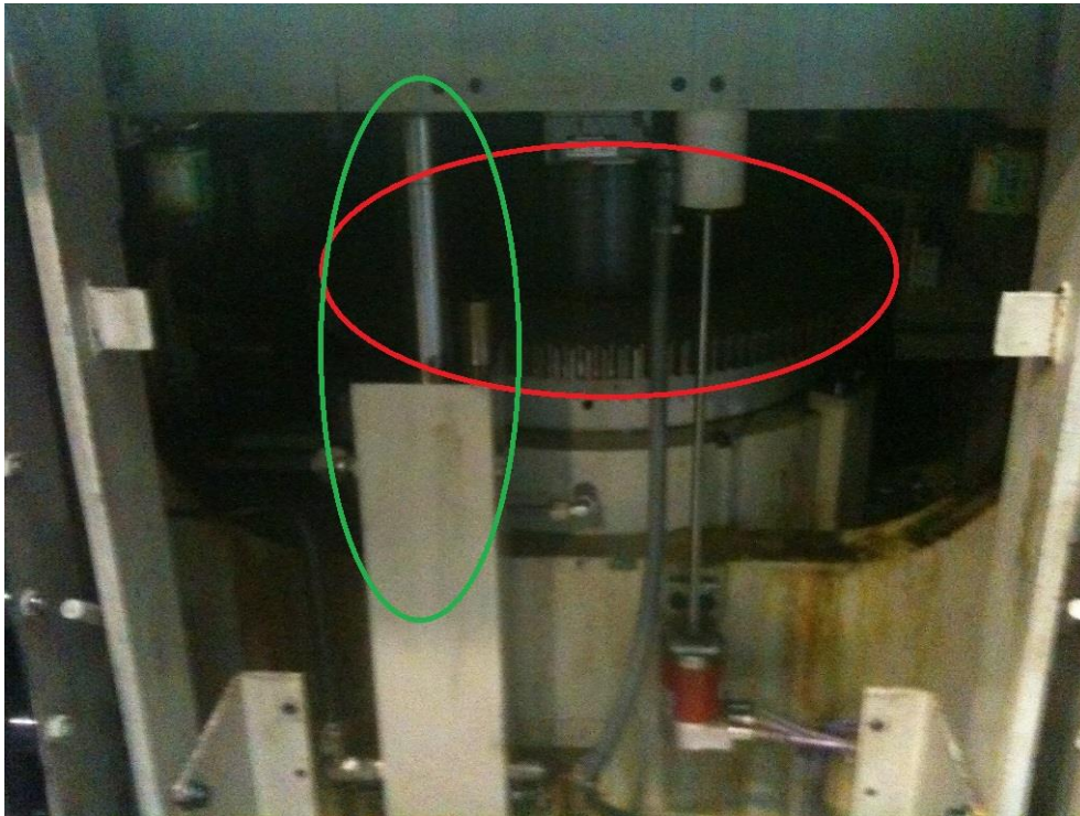
Figura 85 Dettaglio dell'immagine soprastante. Cerchiato in rosso il cilindro principale e in verde il cilindro di corsa rapida.
