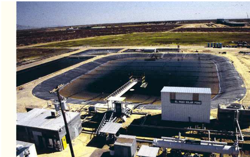
Figure 1-7: El Paso solar pond
