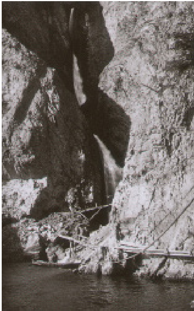
Imm. 13. Gennaio 1930: prime impalcature provvisorie e i primi lavori presso la cascata a lago del torrente Brasa: di lì a poco, la vista di questa bellissima cascata sarebbe stata fruibile a tutti con il passaggio della strada.
