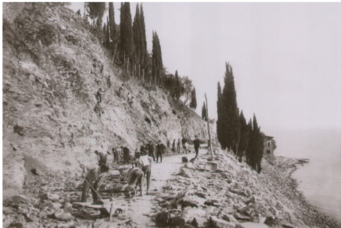
Imm. 4. 11 febbraio 1914, si scava la roccia e si lavora scaricando il materiale a lago. Da questa foto si vede la larghezza originaria della litoranea, realizzata nel 1873 su progetto dell’ingegner Polidoro Levi.
