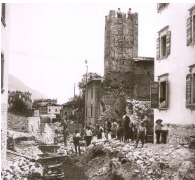
Imm. 5. 1914; a Bogliaco, per creare la nuova sede della strada provinciale, si lavora a demolizioni e sventramenti, che mutano radicalmente l'aspetto originale del paese.
