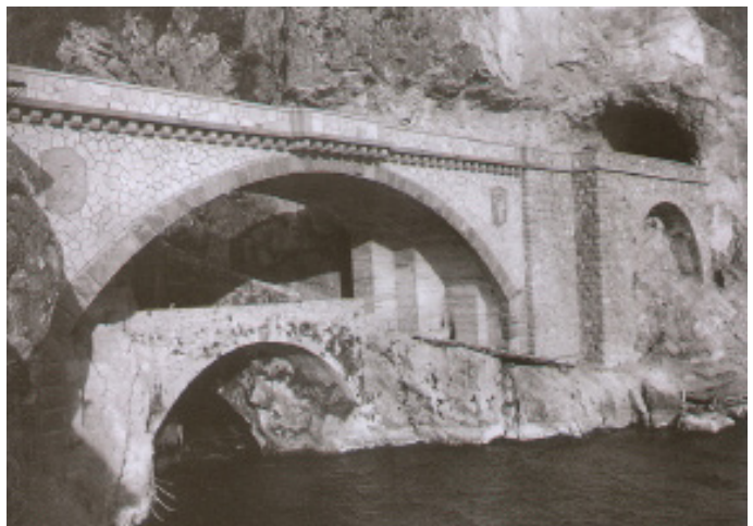
Imm. 16. 27 gennaio 1931: accavallati, l'antico e il nuovo ponte alla foce del torrente Ponale.
