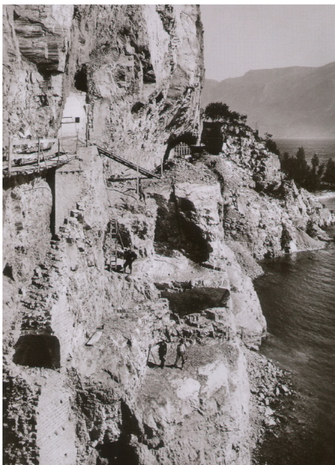
Imm. 9. Gli scavi per la strada nel luogo dove sorgeva l'eremo di San Giorgio in Varolo a sud del porto di Tignale.
