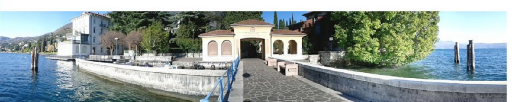
14 La passerella lignea termina all'attracco del traghetti di Fasano. Da qui sarà necessario installarne una nuova, che copra l'ultimo breve tratto, fino ad arrivare a Toscolano e collegarsi alla passerella, anche là già esistente.
