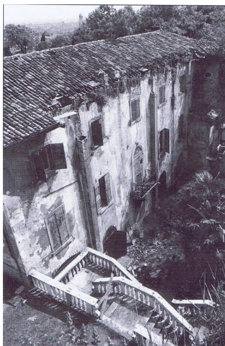
Figura 65: Il retro (lato Ovest) di Villa Francescatti prima dell'inizio dei lavori di restauro
