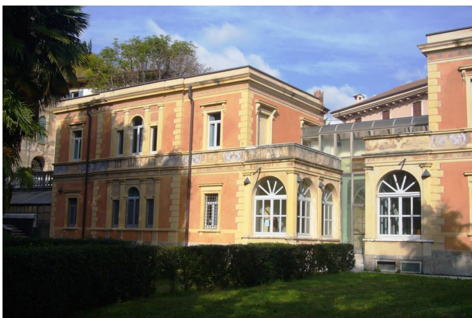
Figura 87: La Foresteria: ripresa dal parco interno.
