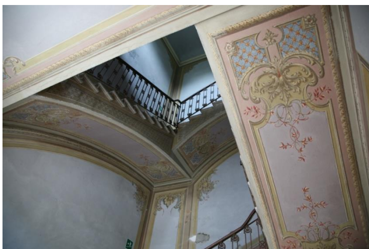
Figura 101: Villa _ rampe scalone principale (PT -P2).
