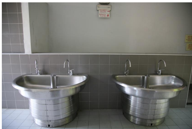
Figura 114: Villa _ servizi igienici _ antibagno (PT).
