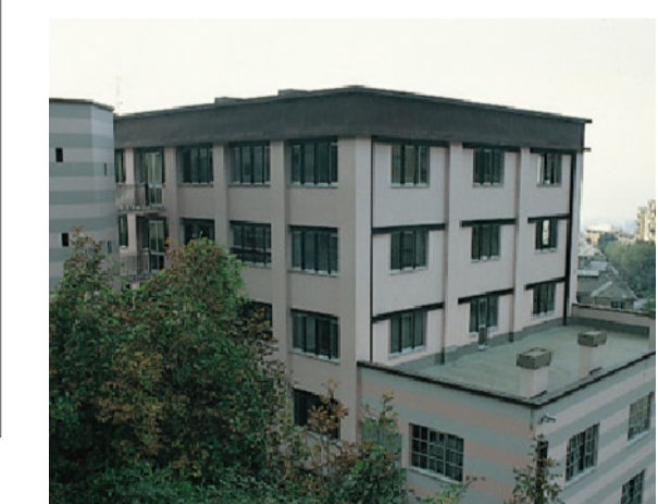
Ostello di Genova (esterno)
