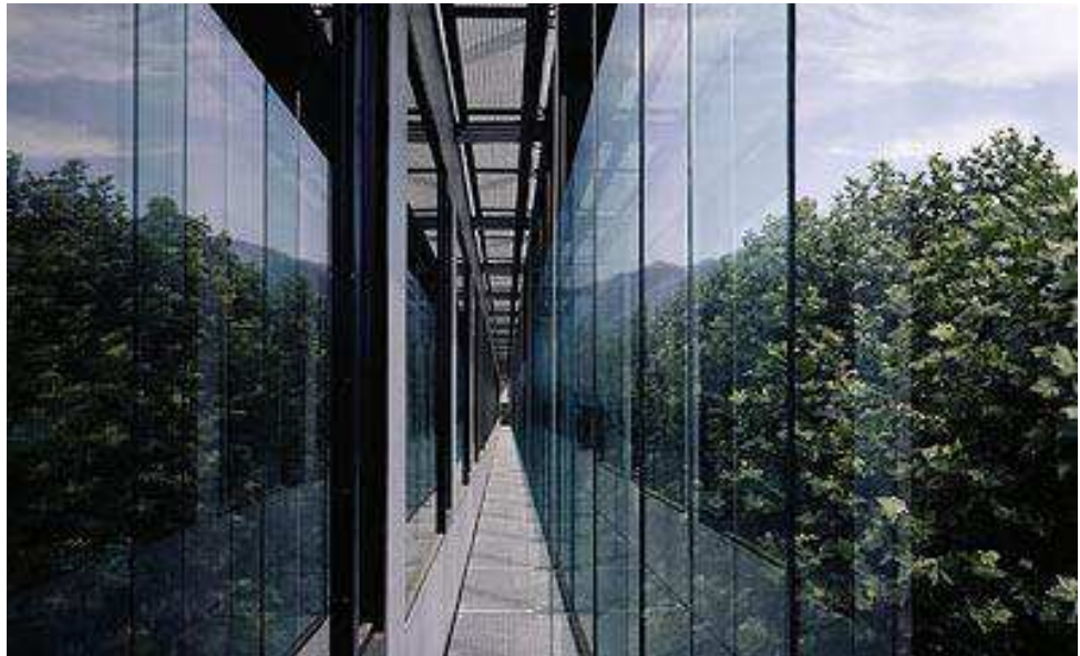
Fig. 241: foto dell'intercapedine (con gli schermi solari retrattili) data dalla doppia pelle
