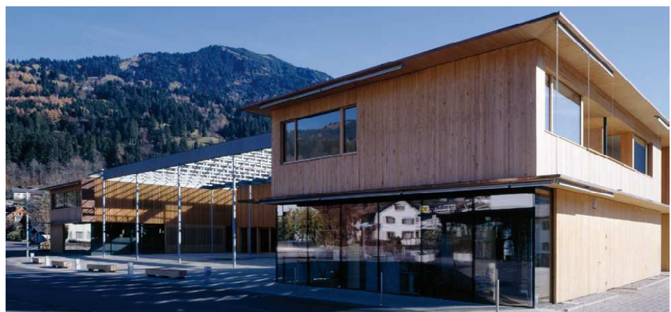
Fig. 271: fotografia esterna dalla strada principale
