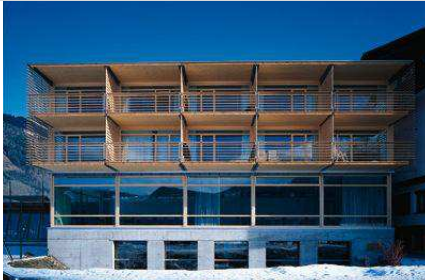
Fig. 198: fotografia della facciata principale a fine lavori
