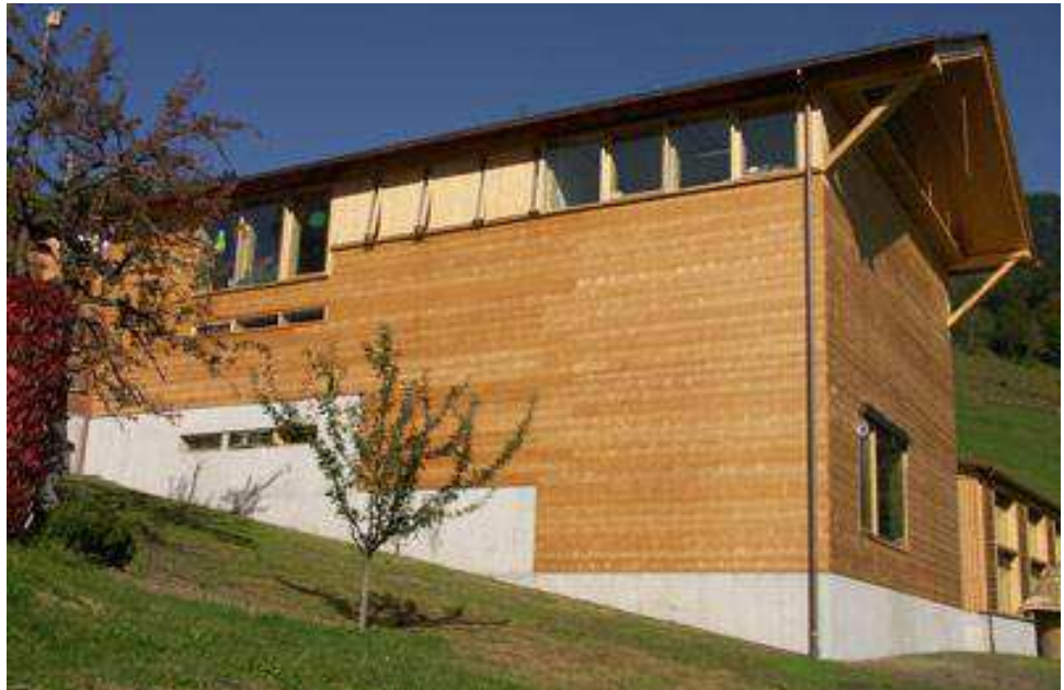
Fig. 42: foto dell'edificio con la scuola ed il negozio, in abete locale su seminterrato in c.a.
