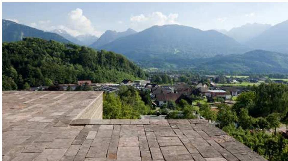
Fig. 283: spettacolare vista panoramica alpina dalla copertura
