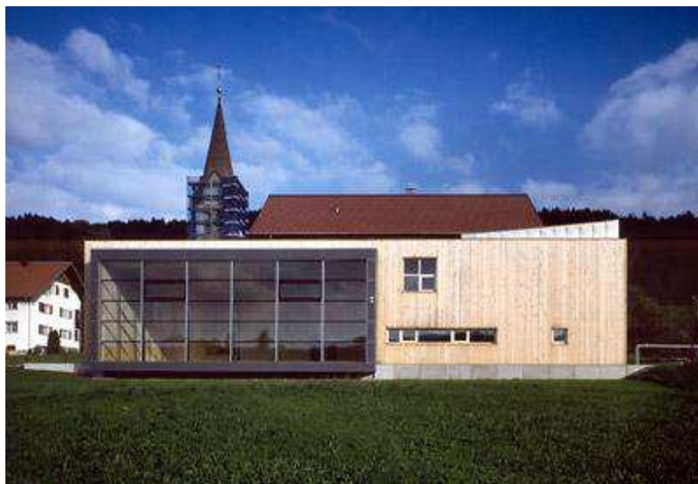
Fig. 206: fotografia dell'ampliamento, si noti la vetrata della palestra
