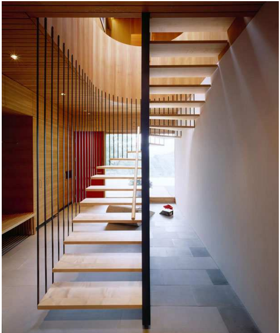
Fig. 190: la scala interna con pedate in legno sorrette da montante e tiranti d'acciaio
