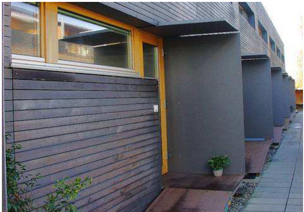
Fig. 233: gli ingressi a nord con le rampe per l'accesso al piano terra leggermente rialzato
