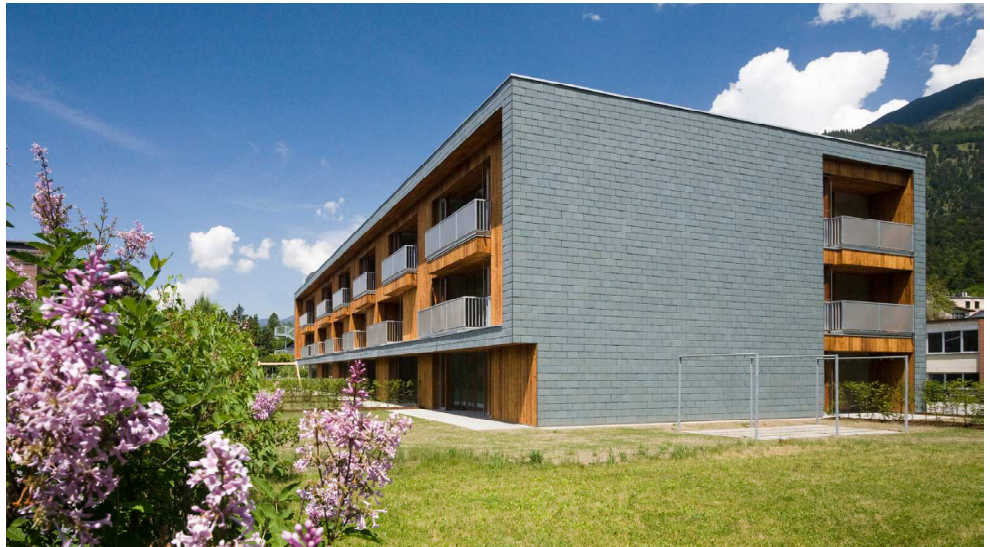
Fig. 344: fotografia angolare da sud-est
