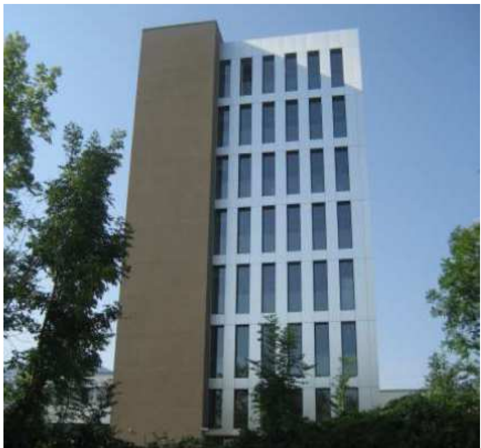
Fig. 379: fotografia esterna dal lato del vano scale-ascensore in c.a.
