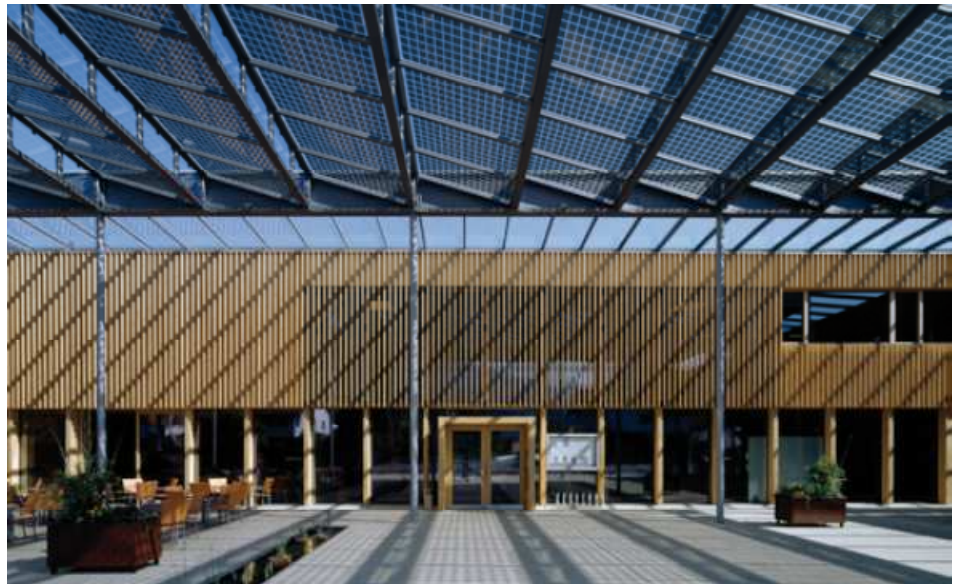
Fig. 273: vista della piazza coperta i cui si vedono anche i moduli fotovoltaici
