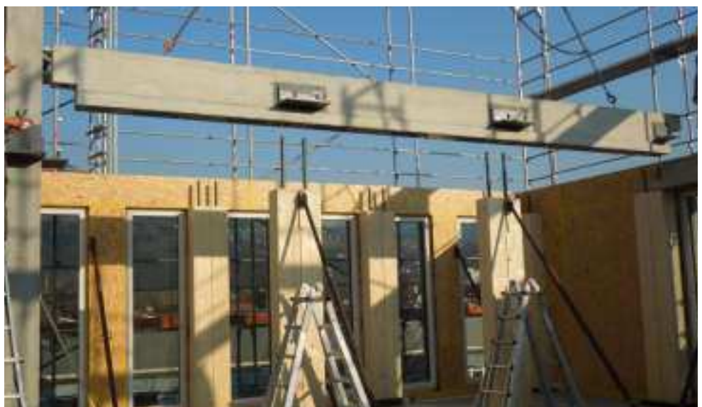
Fig. 377: la trave in calcestruzzo armato con gli angolari posta a lato del vano scale
