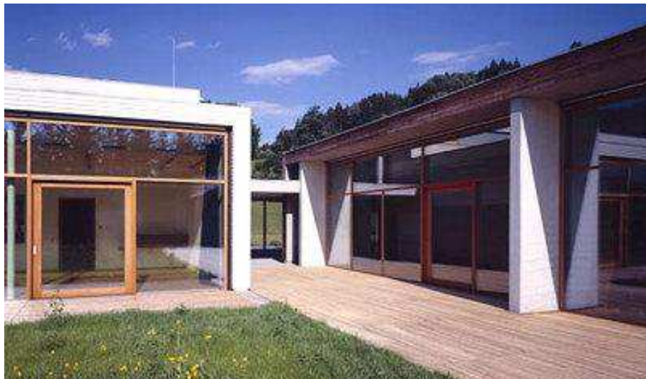
Fig. 212: fotografia della connessione tra i due principali corpi di fabbrica
