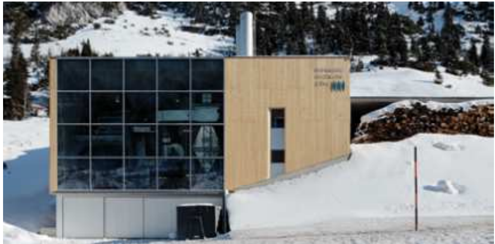
Fig. 350: fotografia esterna della centrale
