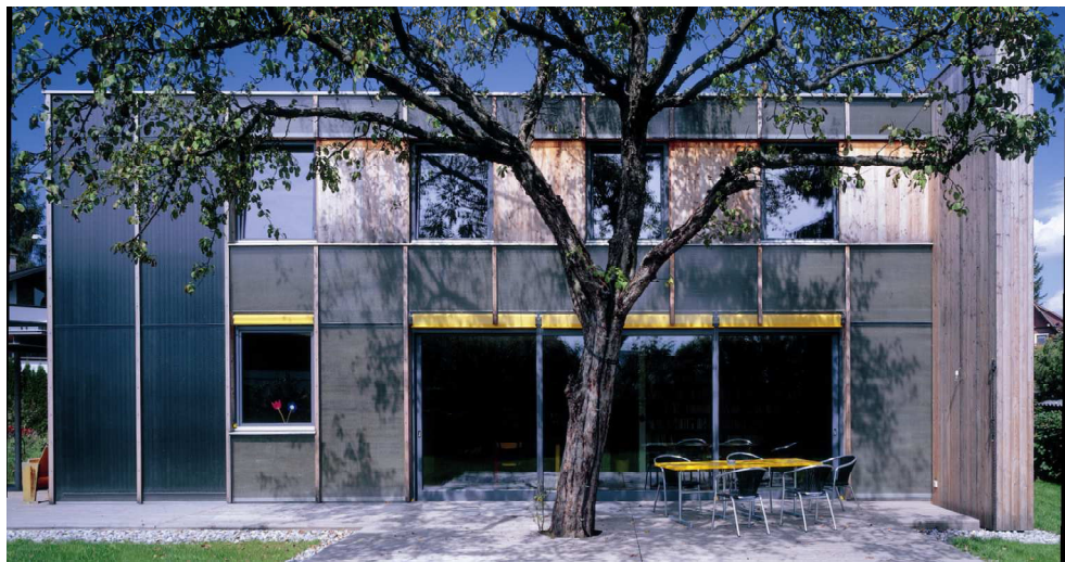
Fig. 178: fotografia della facciata sud (si noti l'isolante a nido d'ape)
