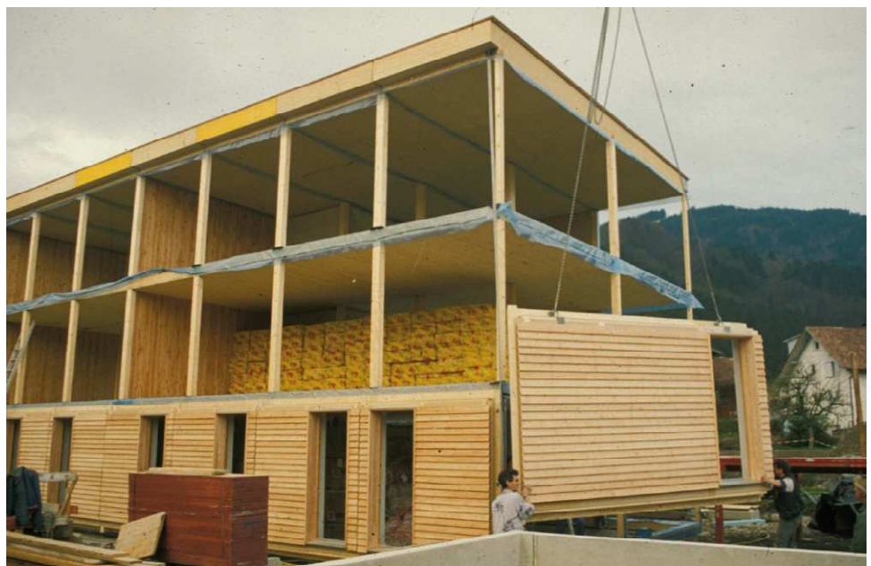
Fig. 152: fotografia durante i lavori, si notino i setti di controventatura interni
