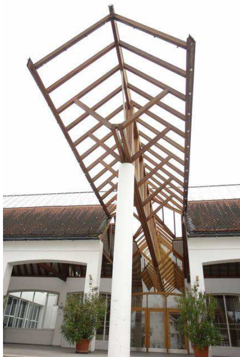
Fig. 99: trave che parte esternamente
