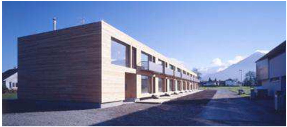
Fig. 231: fotografia esterna da ovest dell'intera stecca poco dopo la fine lavori
