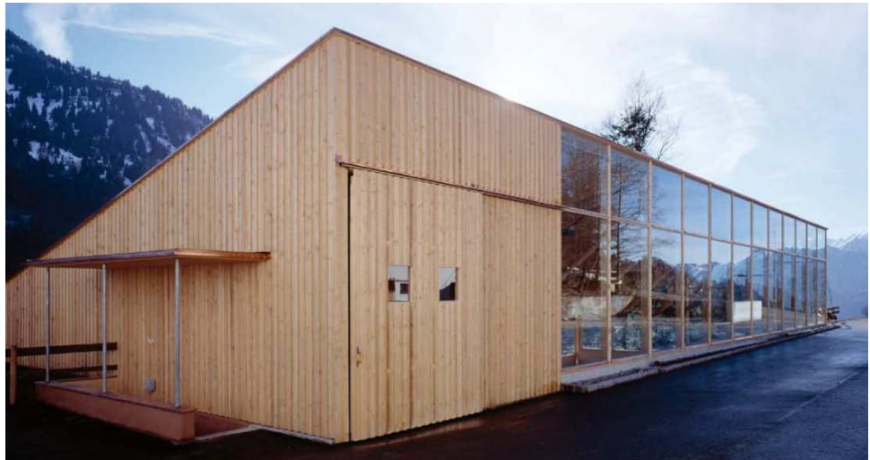
Fig. 156: fotografia degli esterni visti da nord-est
