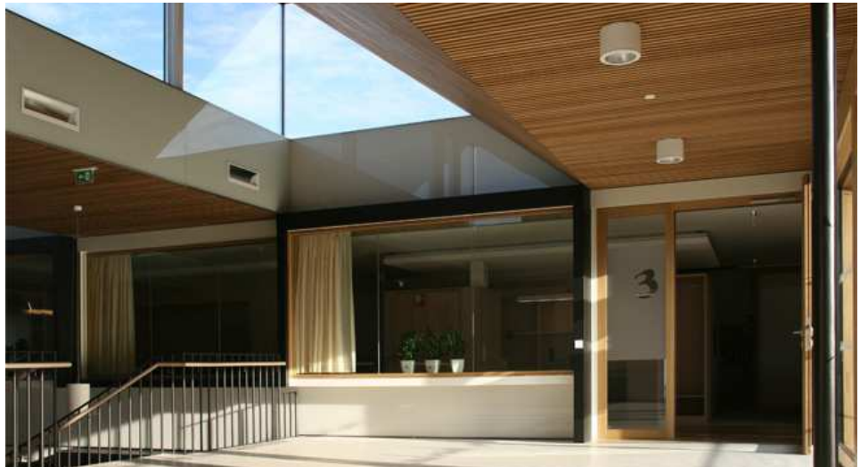
Fig. 367: lo spazio distributivo soppalcato al piano primo illuminato zenitalmente
