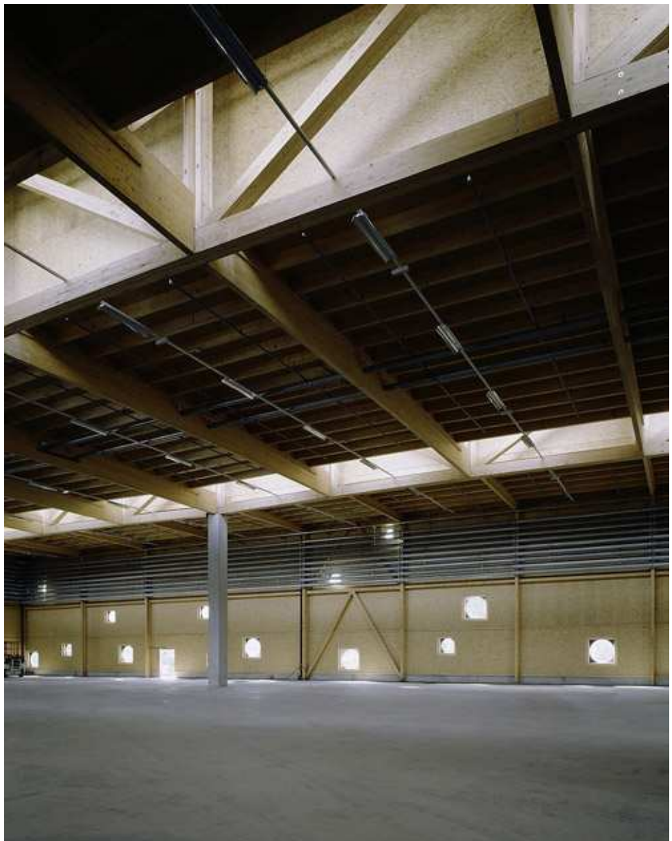
Fig. 293: fotografia interna in cui sono visibili le orditure lignee della copertura
