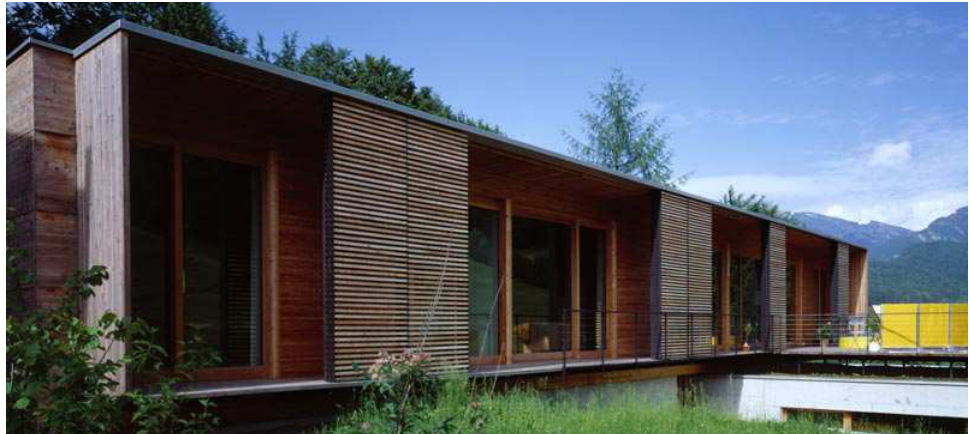
Fig. 186: fotografia della facciata sud con i frangisole scorrevoli e l'ampia finestratura
