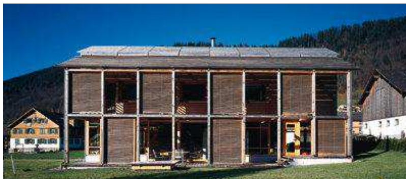
Fig. 126: fotografia della facciata sud
