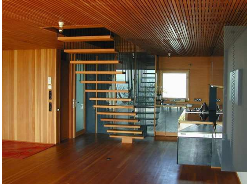
Fig. 168: scala interna di un alloggio con le pedate in legno e i tiranti d'acciaio
