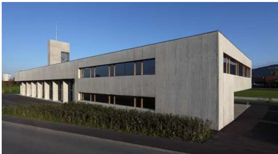
Fig. 327: fotografia esterna del lato con il deposito automezzi
