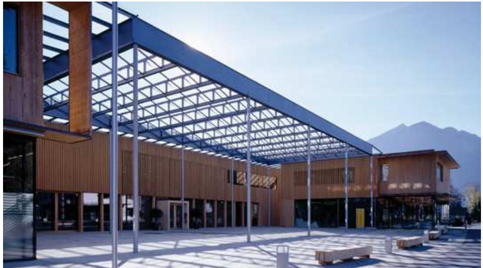
Fig. 272: fotografia della piazza coperta
