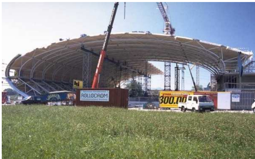
Fig. 174: fotografia durante il montaggio degli elementi prefabbricati
