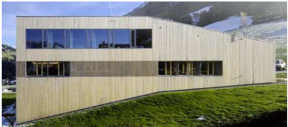
Figura 49: fotografia della facciata nord-ovest
