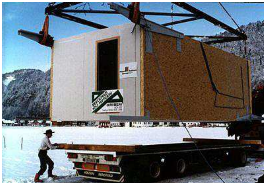
Fig. 200: fotografia dello scarico dai tir dei moduli prefabbricati
