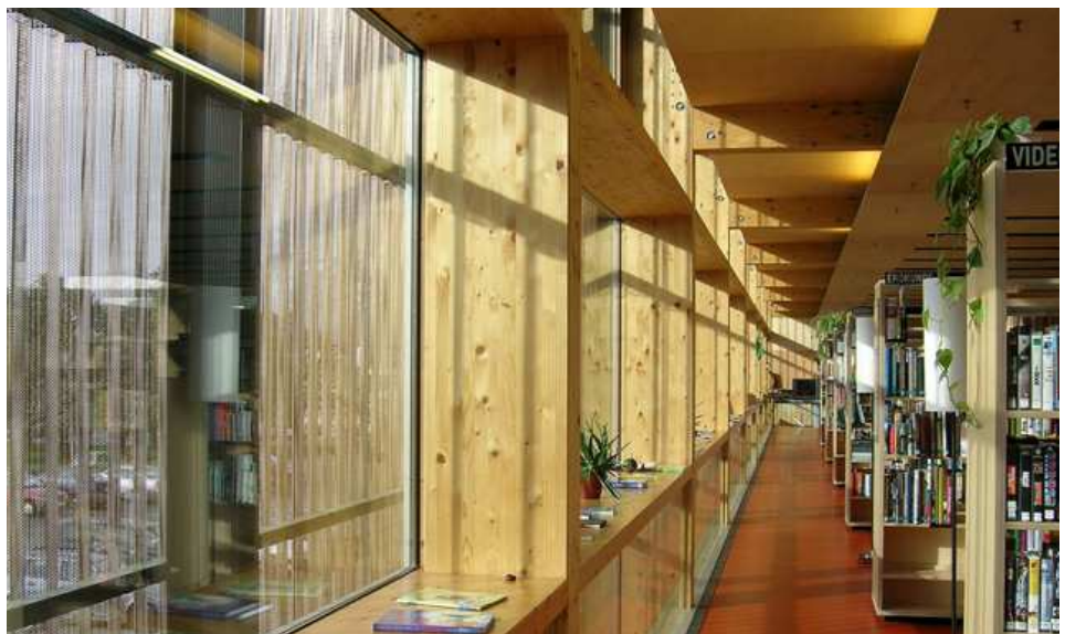
Fig. 261: foto delle finestre della biblioteca schermate dalla lamiera di rame forata
