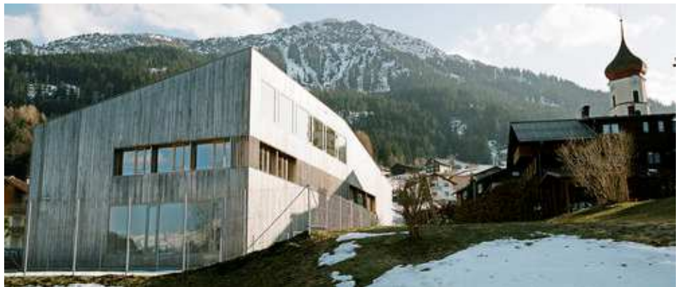
Figura 48: fotografia vista da nord-ovest
