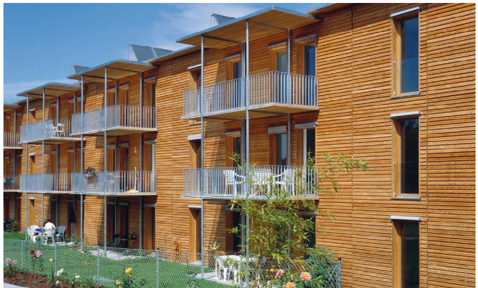
Fig. 151: la facciata sud-ovest con i collettori solari termici in copertura orientati a sud-est
