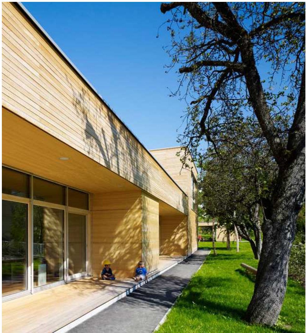
Fig. 358: la facciata sud con i porticati delle aule che fungono anche da schermature solari
