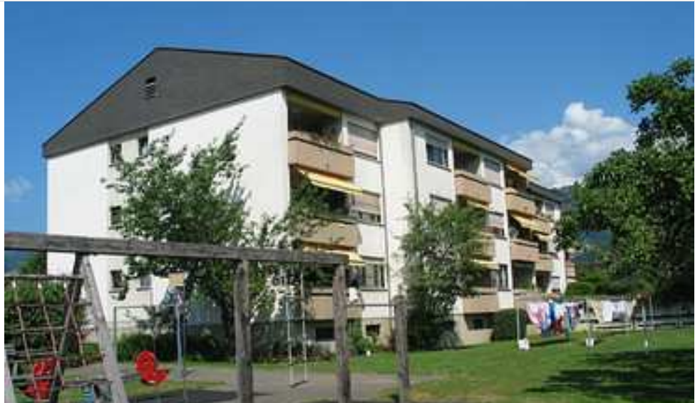
Fig. 68: fotografia dell'edificio da sud-ovest prima dell'intervento di PHR
