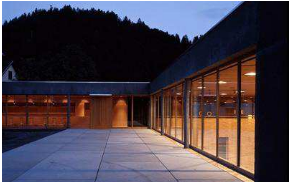
Fig. 266: le finestre (a destra) della palestra/sala polifunzionale prospicienti la piazza
