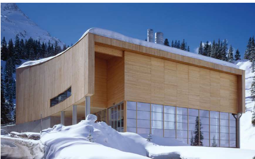
Fig. 63: la centrale a biomassa di Lech, 1999, arch. Hermann Kaufmann
