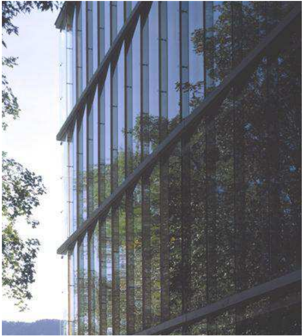
Fig. 142: fotografia della seconda pelle in elementi di vetro non giuntati
