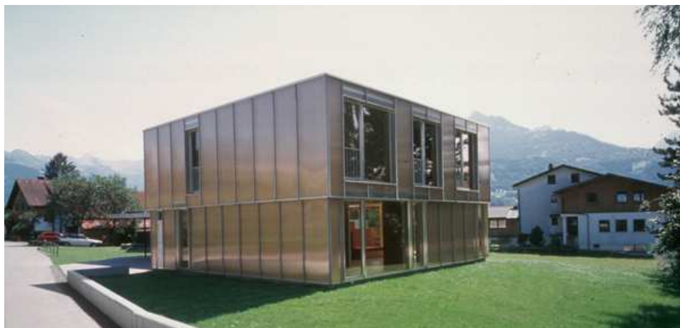
Fig. 225: altra fotografia esterna in cui si vede l'involucro in pannelli in policarbonato
