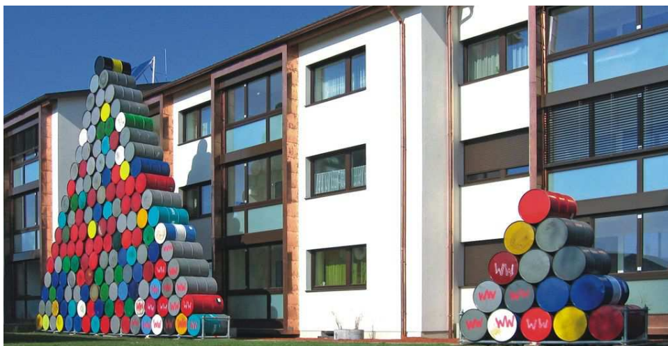
Figura 60: Passiv House Retrofit di edificio anni '70 a Rankweil con abbattimento del 91% dei consumi
