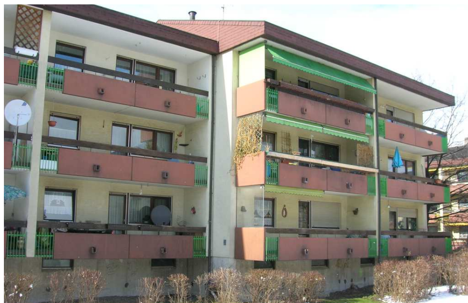
Fig. 72: fotografia di uno degli edifici prima dell'intervento
