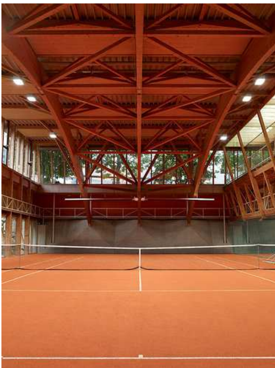
Fig. 107: foto di uno dei campi in cui si vede la struttura di copertura e la passerella lignea
