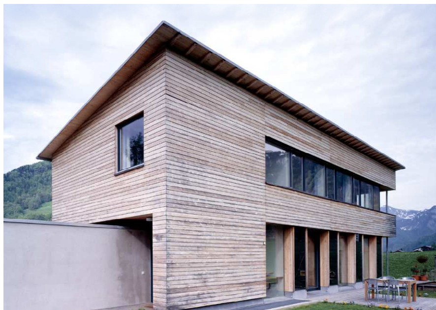
Fig. 130: foto da sud-ovest con il box che si innesta nel volume dell'abitazione
