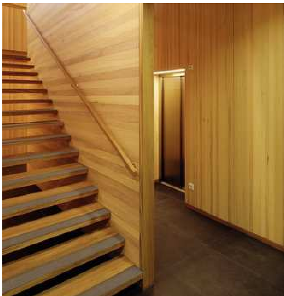
Figura 52: fotografia degli interni con le scale e i pannelli prefabbricati in abete locale
