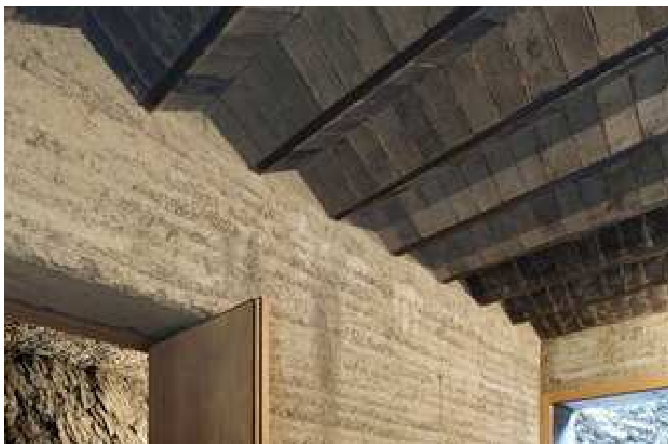
Fig. 284: solaio costituito da profili in acciaio sulle cui ali appoggiano mattonelle d'argilla
