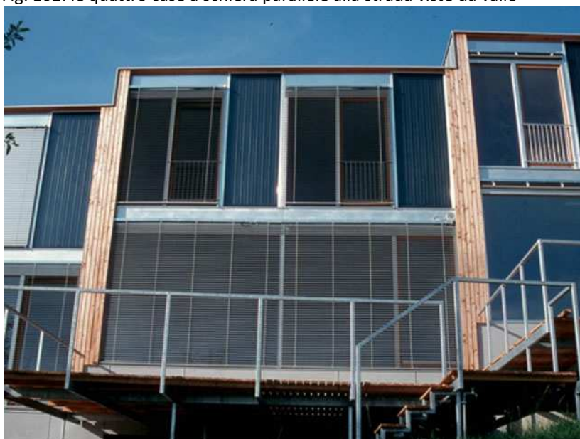
Fig. 163: la facciata a sud di una casa, si noti l'ampia vetratura e i collettori
