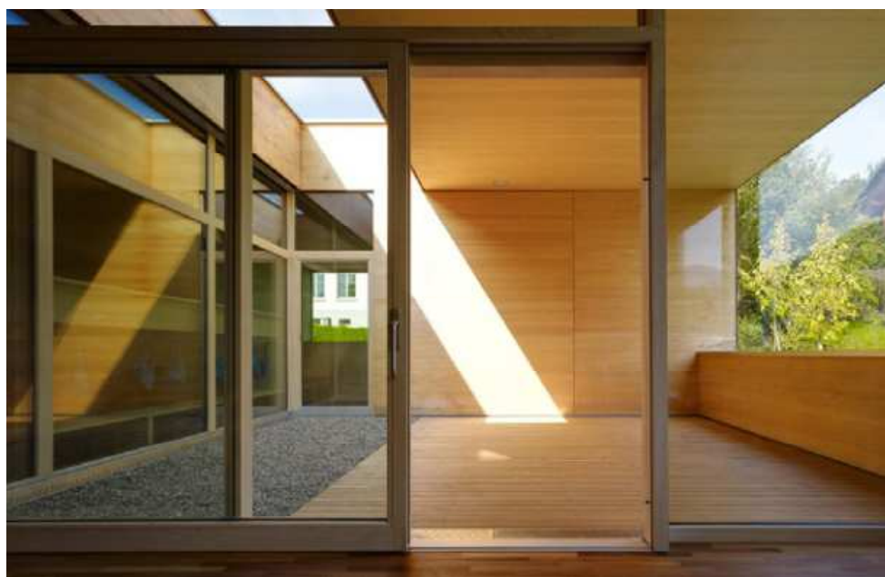
Fig. 360: loggia al piano primo con il taglio in copertura per migliorarne l'illuminazione
