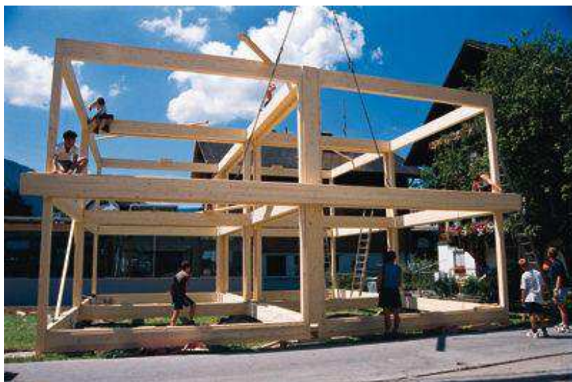
Fig. 148: la struttura principale a telaio in legno durante il montaggio
