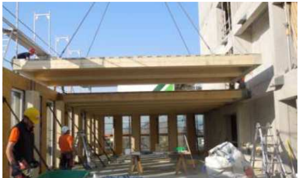
Fig. 374: il montaggio delle lastre ibride in legno e calcestruzzo armato dei solai
