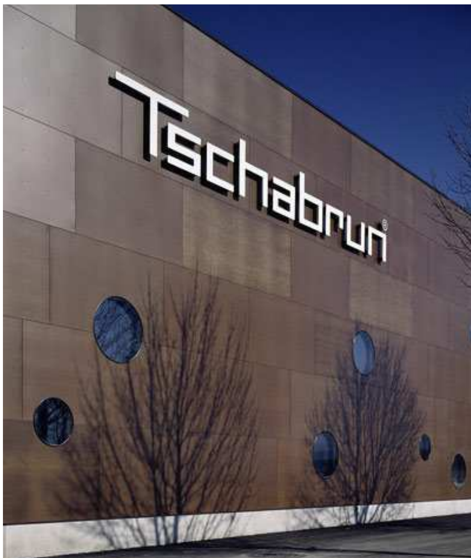
Fig. 291: foto ravvicinata della facciata con i pannelli in resina fenolica e le finestre tonde
