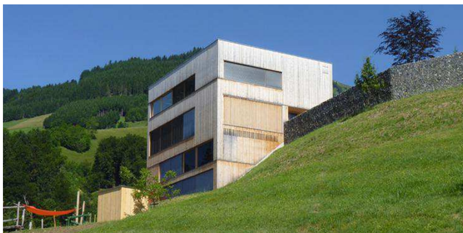
Fig. 322: fotografia esterna da valle in cui si vede come il volume si inserisce nel pendio
