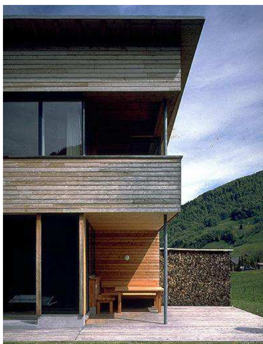
Fig. 132: foto dell'estremità con il portico sud-est
