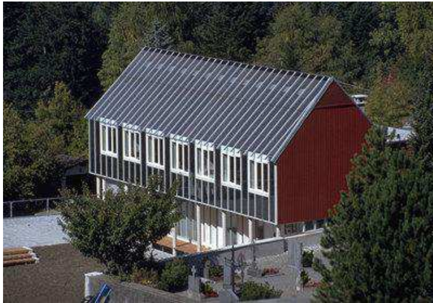
Fig. 109: fotografia della facciata sud coperta di collettori solari
