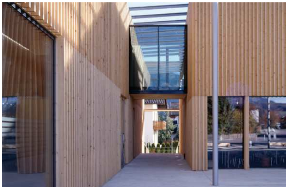
Fig. 274: connessione tra i corpi di fabbrica e passaggio pedonale che porta sul retro
