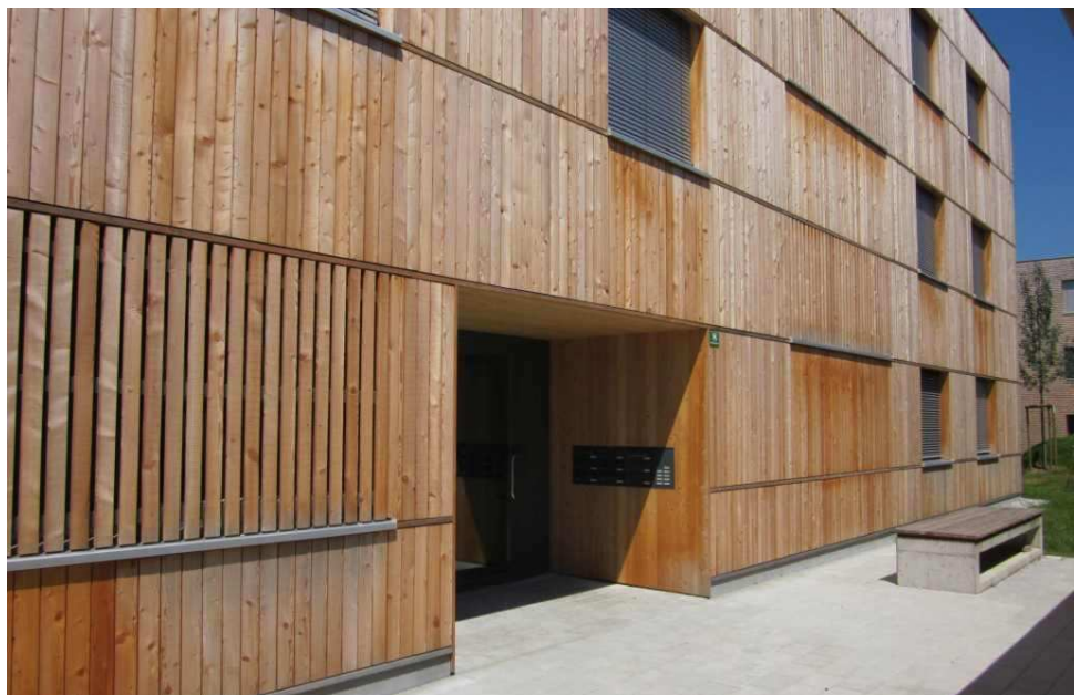
Fig. 337: fotografia dell'ingresso ad uno dei cinque edifici
