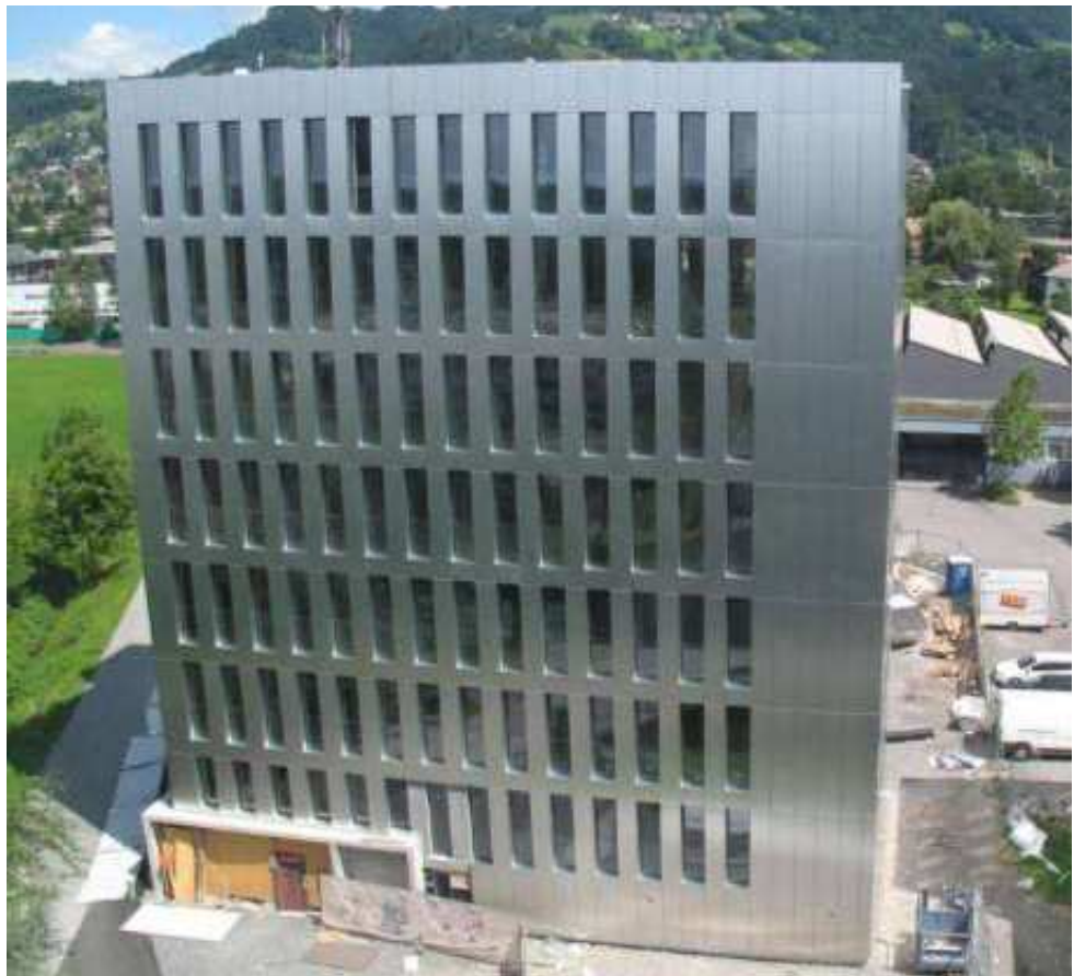
Fig. 378: fotografia esterna della torre rivestita in alluminio a fine lavori
