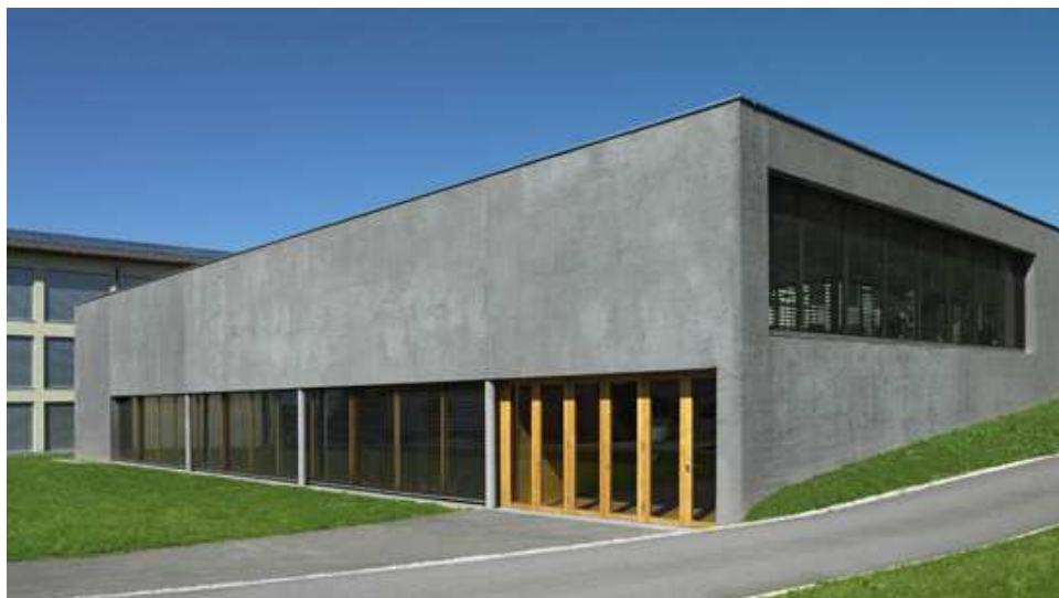
Fig. 263: foto esterna del nuovo spazio polifunzionale/palestra parzialmente interrato
