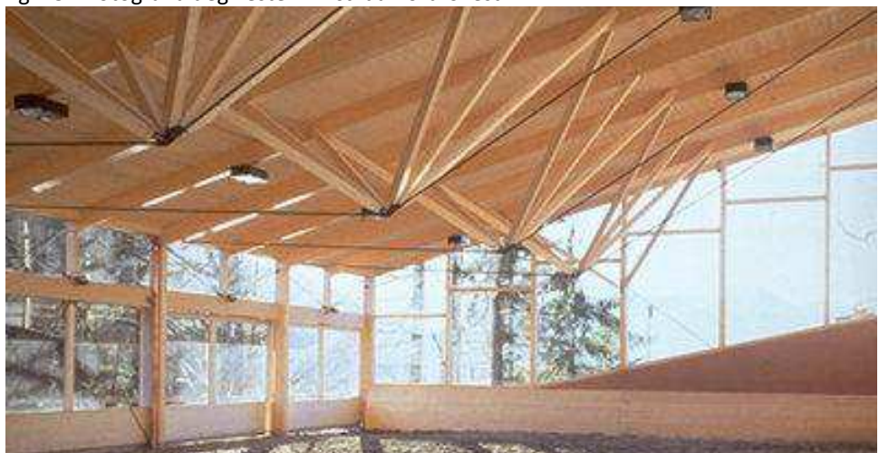
Fig. 158: fotografia interna in cui si nota la particolare struttura di copertura in legno
