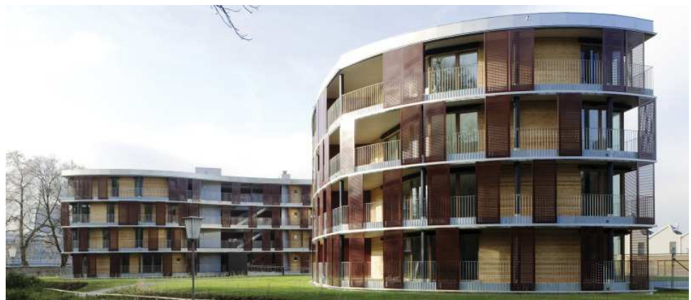
Fig. 296: fotografia esterna, da est, dei due blocchi a nord-est
