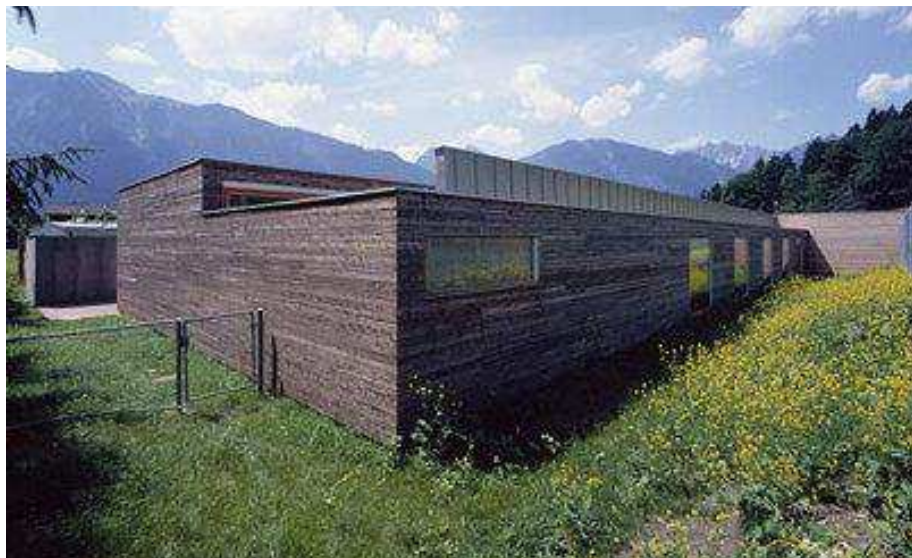
Fig. 213: fotografia dal retro in cui si possono vedere la facciata nord e quella est
