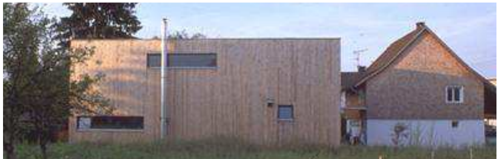
Fig. 179: la facciata nord (poco aperta e rivestita in legno)
