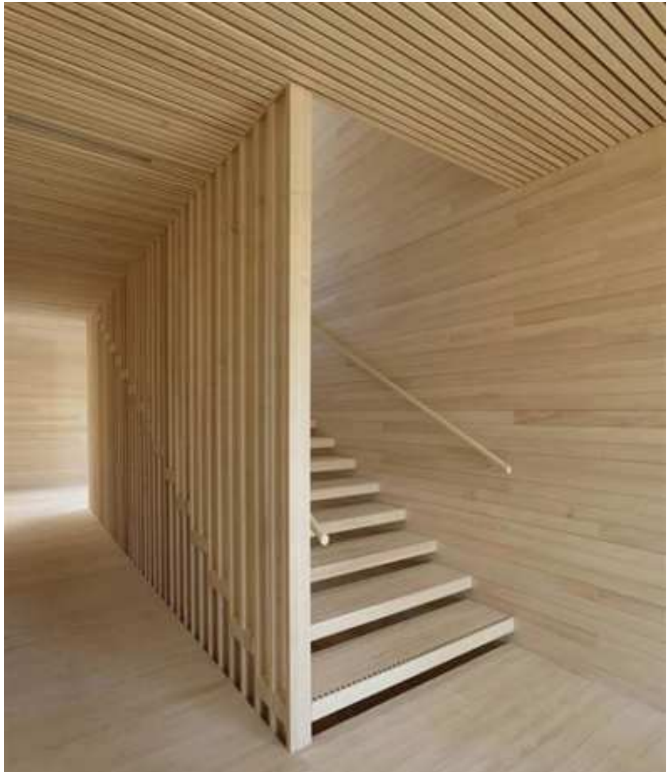
Fig. 325: foto della scala interna anch'essa interamente in legno massello di abete
