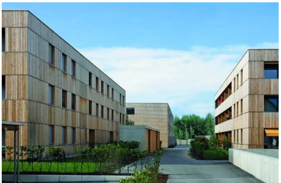
Fig. 340: fotografia dall'interno del complesso
