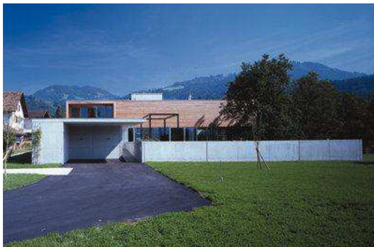
Fig. 137: fotografia dell'abitazione presa dal lotto adiacente
