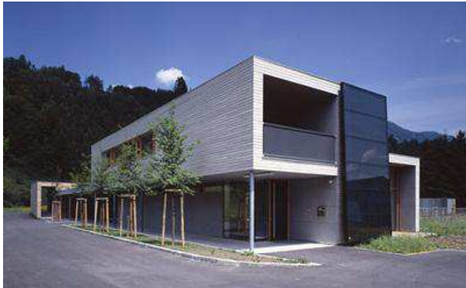
Fig. 211: il corpo di fabbrica su due livelli con i pannelli termosolari addossati a sud
