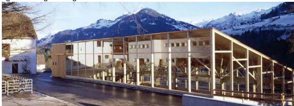
Fig. 157: fotografia degli esterni visti da nord-ovest
