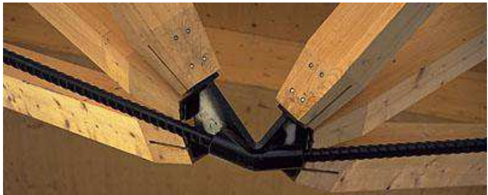
Fig. 159: particolare di un nodo con i tiranti e i puntoni di legno che sorreggono le travi
