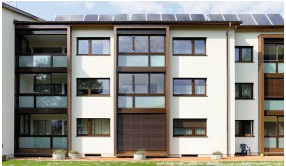
Fig. 70: parte della facciata sud dopo il PHR, notare la cornice isolata attorno ai balconi
