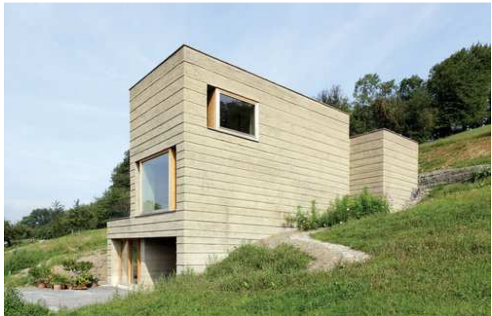
Fig. 281: fotografia esterna da valle dell'abitazione in terra cruda sperimentale
