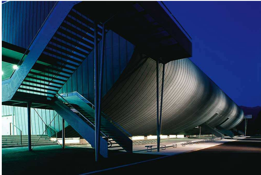
Fig. 172: fotografia notturna suggestiva dell'esterno dell'edificio
