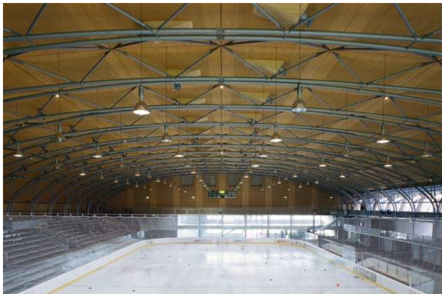
Fig. 173: l'interno del palazzetto con le grandi travi reticolari in tubolari d'acciaio
