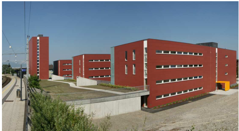
Fig. 332: fotografia del complesso residenziale e della vicina linea ferroviaria
