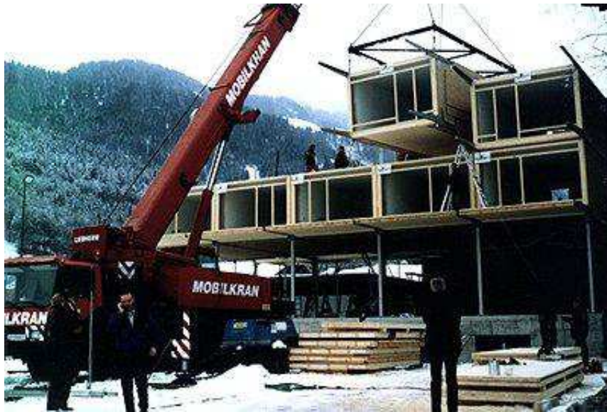
Fig. 199: foto del montaggio dei moduli prefabbricati autoportanti delle camere
