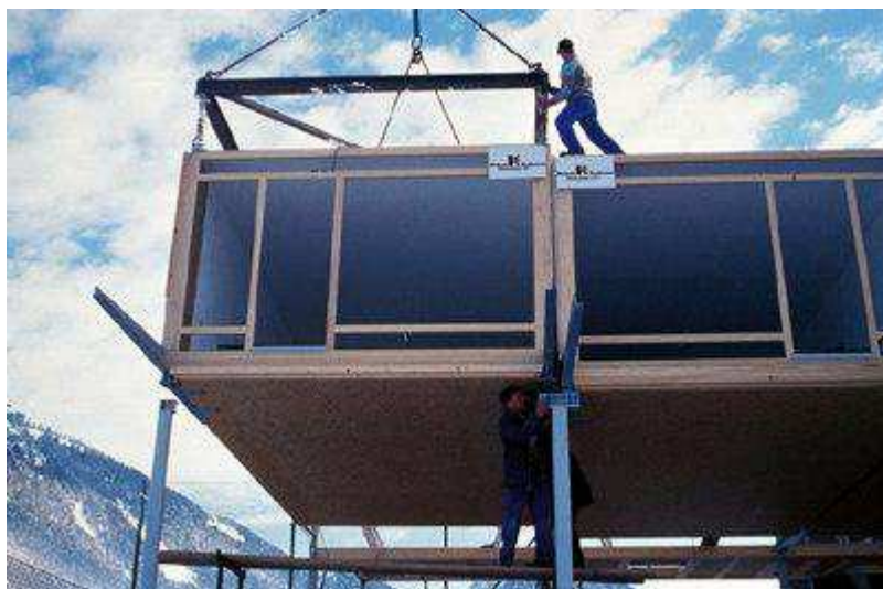
Fig. 195: il montaggio dei moduli prefabbricati autoportanti delle camere
