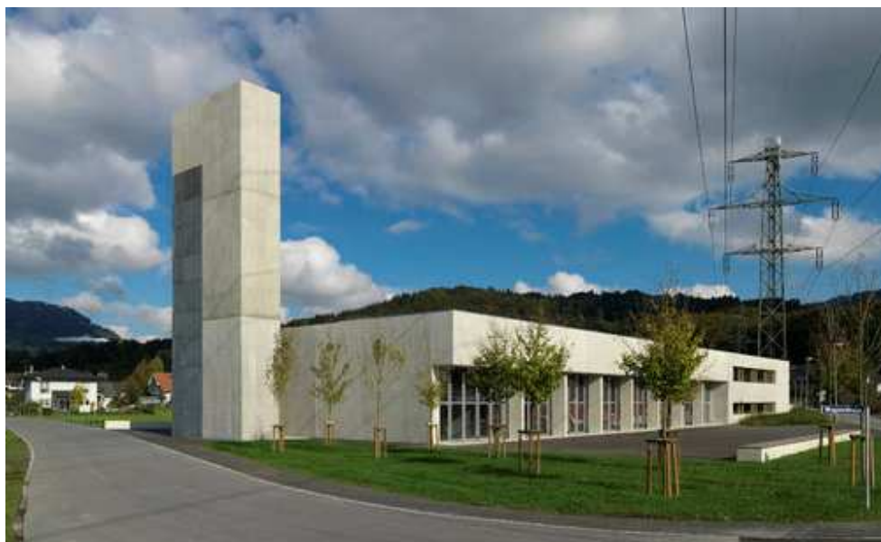
Fig. 328: altra foto esterna in cui si vede la linea ad alta tensione e la torre esercitazioni
