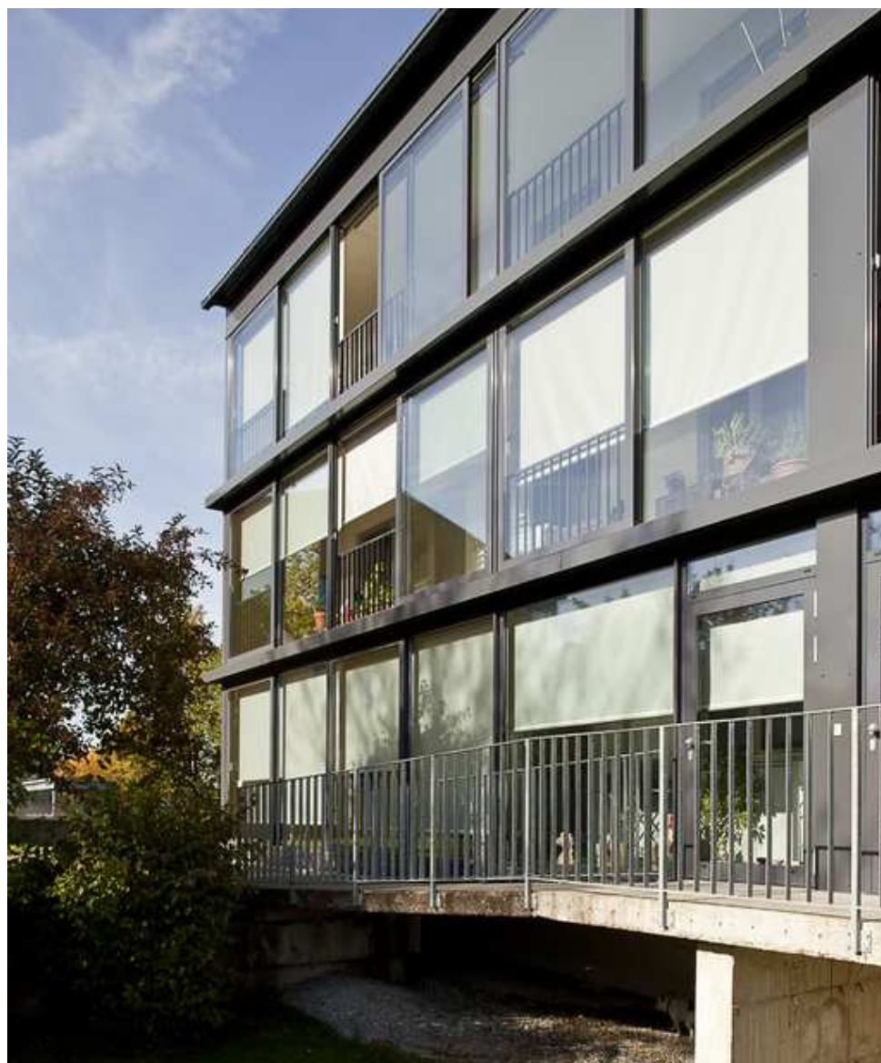
Fig. 73: la facciata vetrata con cui sono stati integrati i balconi ed eliminati i ponti termici
