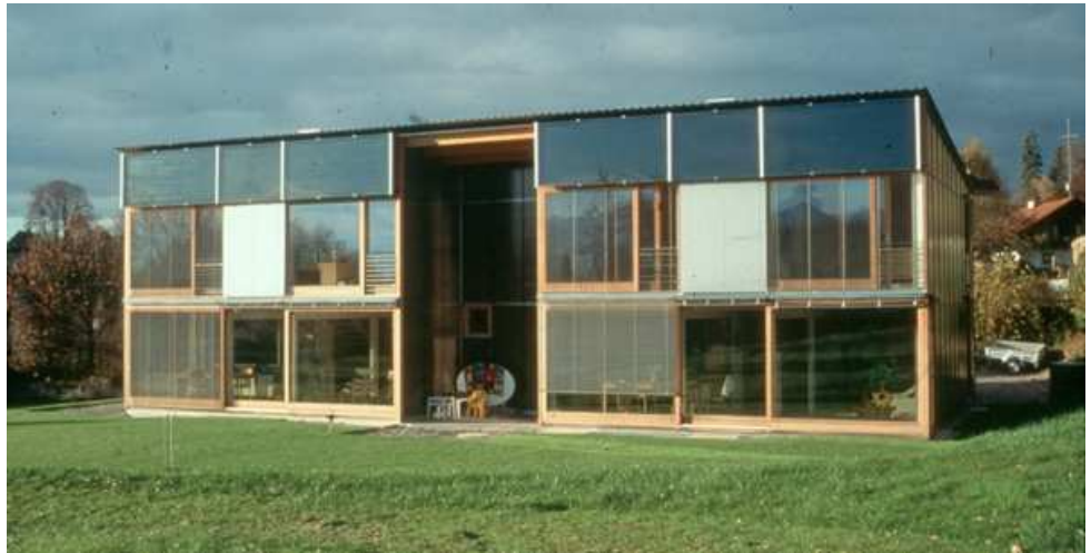
Fig. 122: facciata sud, vetrata (ma schermata con veneziane) e munita di collettori solari
