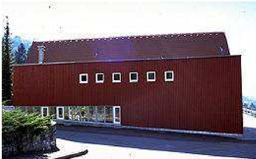
Fig. 110: nord scarsamente finestrato (le finestre basse sono della palestra seminterrata)
