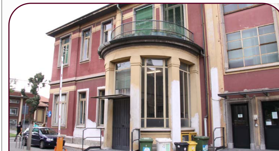
Foto 3. Prospetto Est ingresso laterale
