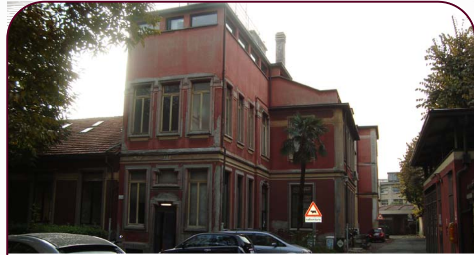
Foto 1. Prospetto nord con corpo alto a torre
