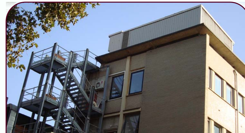
Foto 3. Prospetto Nord scala esterna di collegamento in facciata
