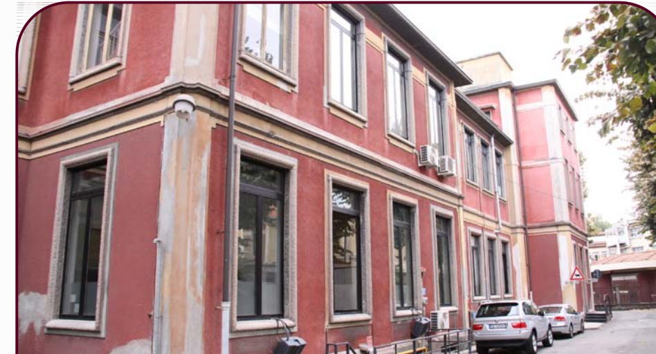
Foto 2. Prospetto Ovest corpo trasversale
