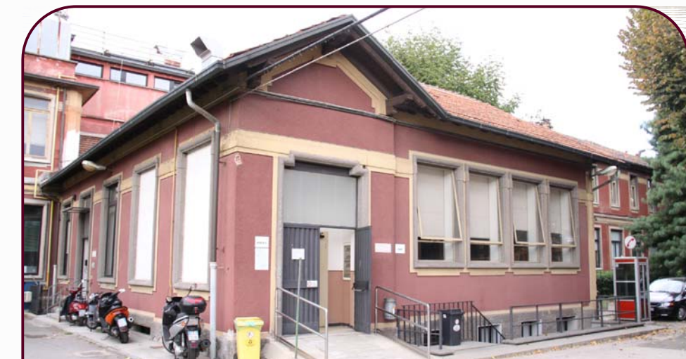
Foto 6. Prospetto Est corpo longitudinale
