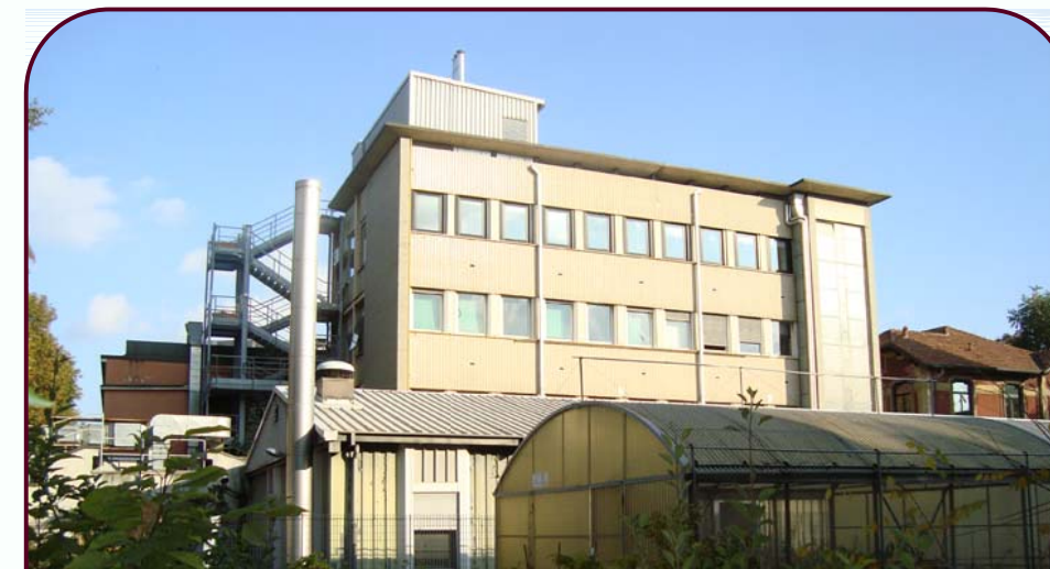
Foto 2. Prospetto Ovest Dipartimento di Scienze e Tecnologie Veterinarie
