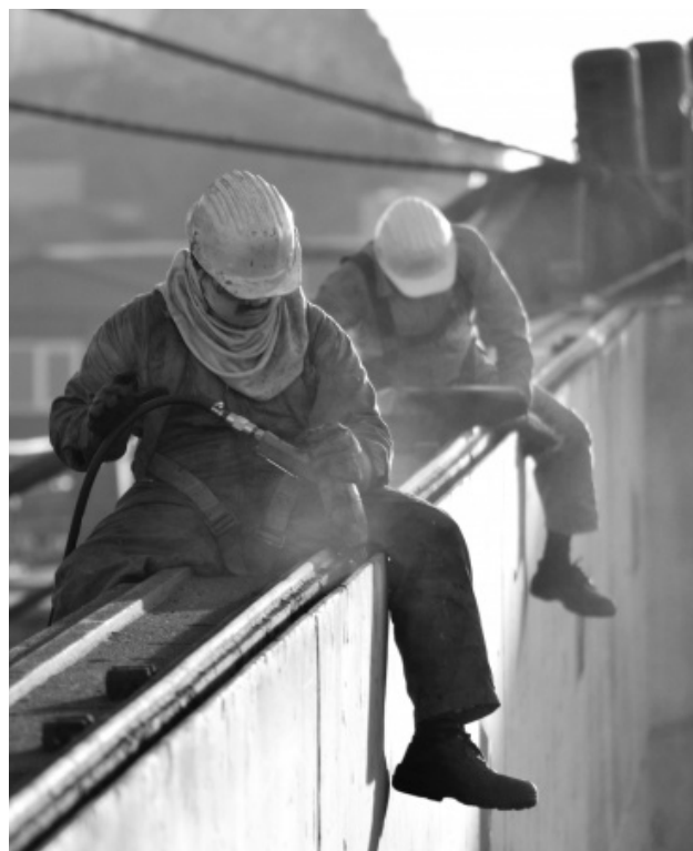
1.6 Operai al lavoro
