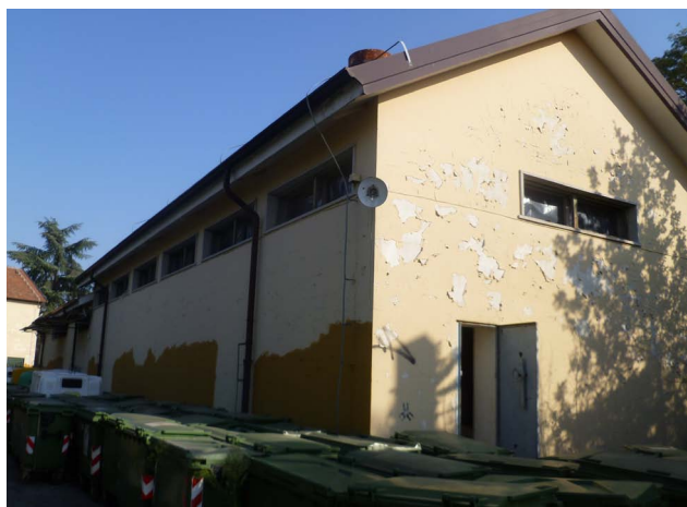
5.12 L'ex edificio elettrico.
