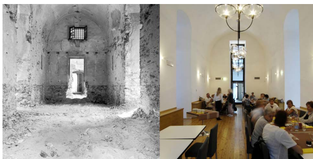
2.52 Raffronto prima e dopo l'intervento.
