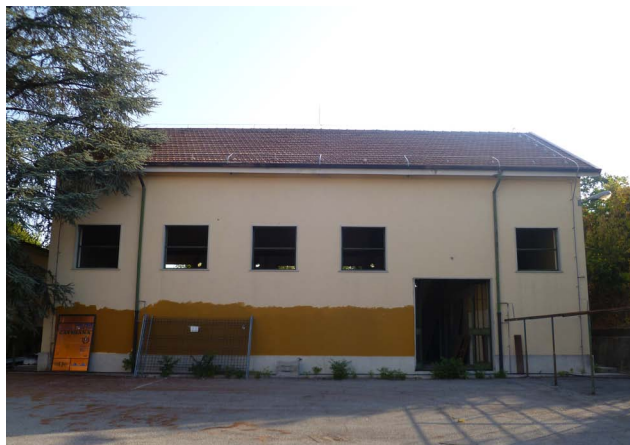
5.11 L'ex edificio energia e magazzino.
