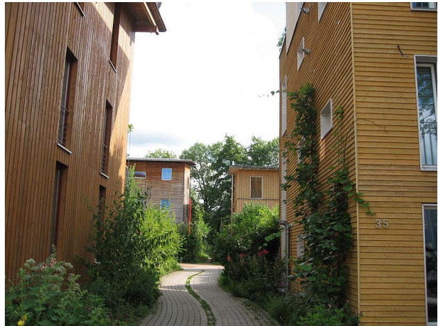
2.40 Dettaglio di alcuni degli edifici con rivestimento in legno.
