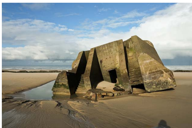
2.6 N.Sowers, bunker a Wissant, Francia
