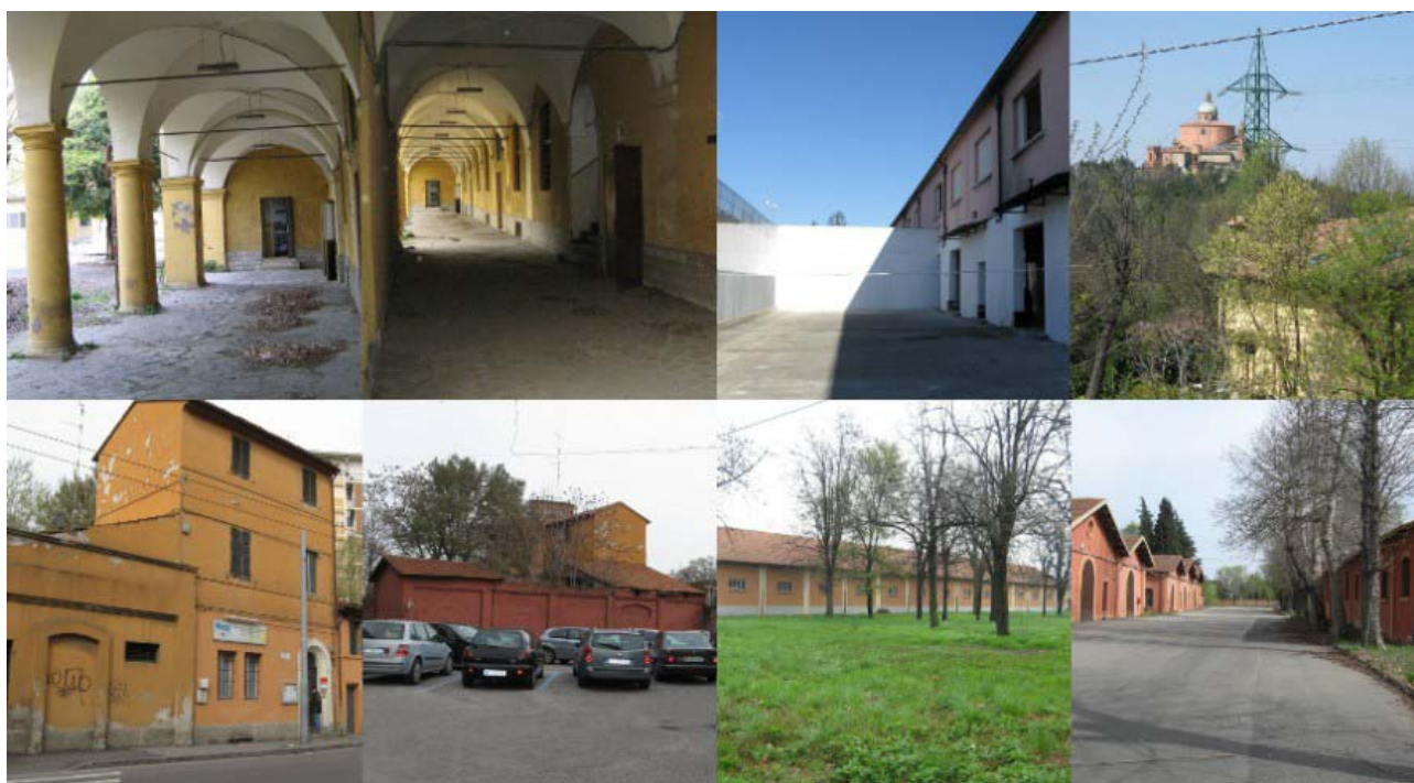
2.43 Immagini dello stato di fatto di alcune delle caserme.
