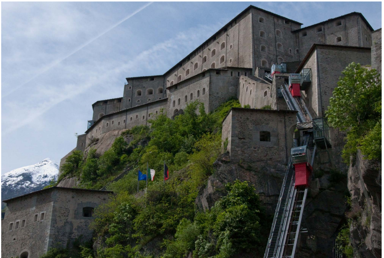
2.50 Vista dell'inserimento degli impianti di risalita.
