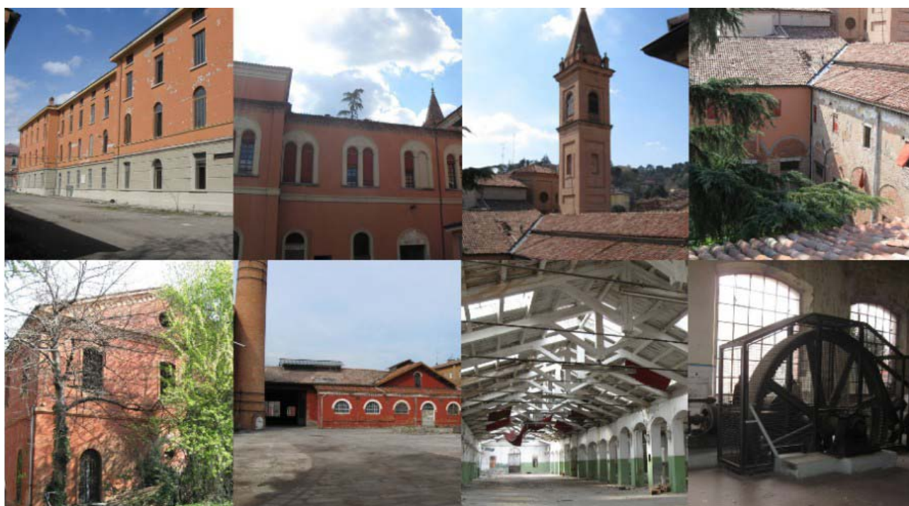
2.44 Immagini dello stato di fatto di alcune delle caserme.
