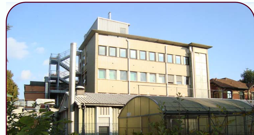
Foto 2. Prospetto Ovest Dipartimento di Scienze e Tecnologie Veterinarie
