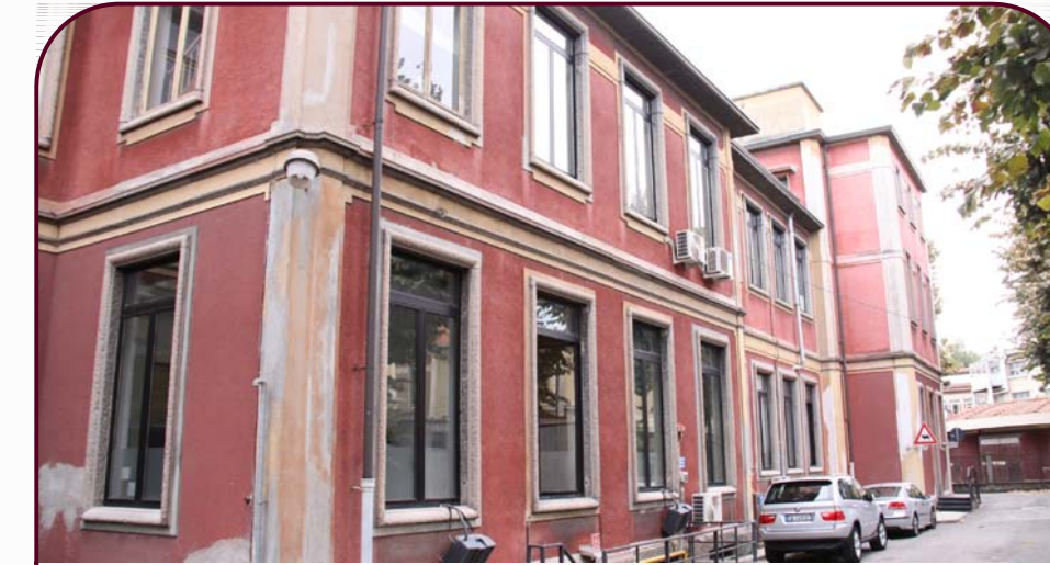
Foto 2. Prospetto Ovest corpo trasversale
