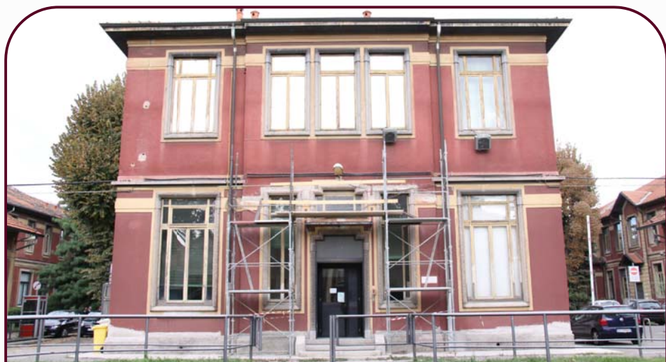
Foto 1. Prospetto Sud ingresso principale
