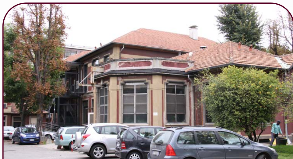
Foto 1. Prospetto Nord-Est con vano scale esterno in acciaio
