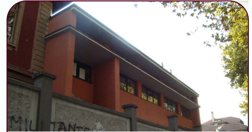
Foto 4. Corpo Ovest del Dipartimento di Scienze Animali
