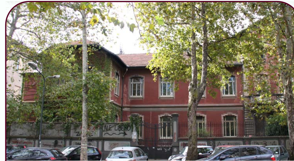
Foto 2. Prospetto ala Est lungo Via Celoria
