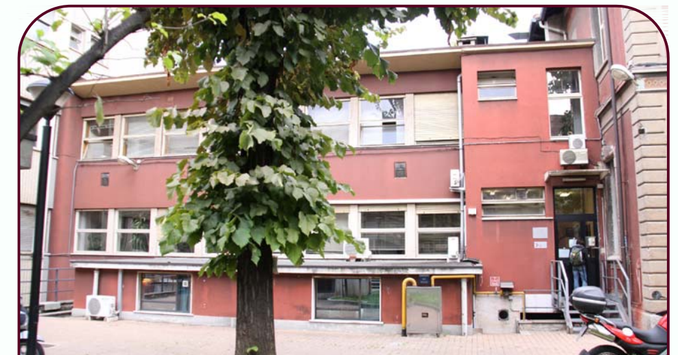
Foto 6. Prospetto Sud del Dipartimento di Scienze Animali
