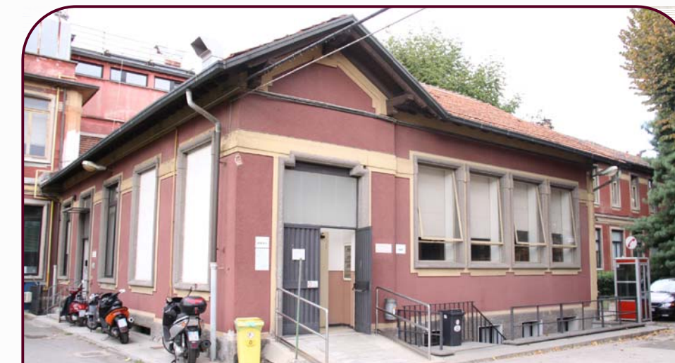
Foto 6. Prospetto Est corpo longitudinale
