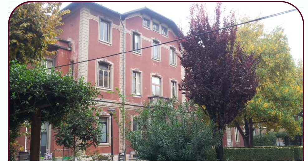
Foto 5. Prospetto Sud corpo centrale
