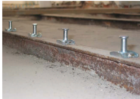
Fig. 15.4. - A sinistra: Intradosso solaio putrelle metalliche e pignatte sagomate.
