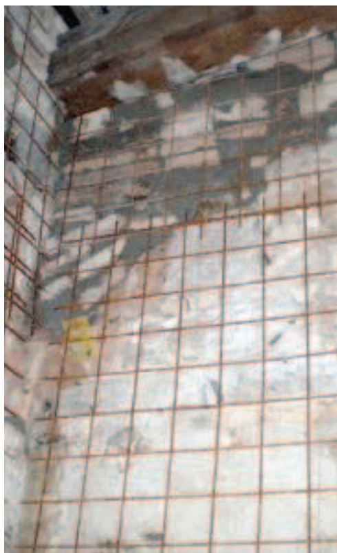
Fig. 15.2. e fig. 15.3. - Immagini esplicative della tecnica dell'intonaco armato.
