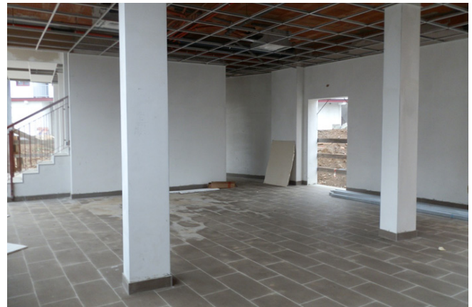
fig. 30 Interno piano terra edificio E
