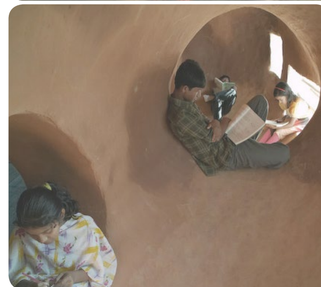
in alto sinistra: prospetto sud in basso sinistra: nicchie ricavate nella parete in terra cruda al piano terra
