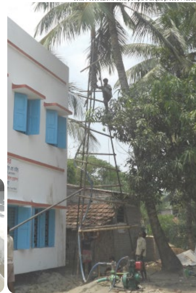
sotto : costruzione della pompa d'acqua presso Prasadpur
