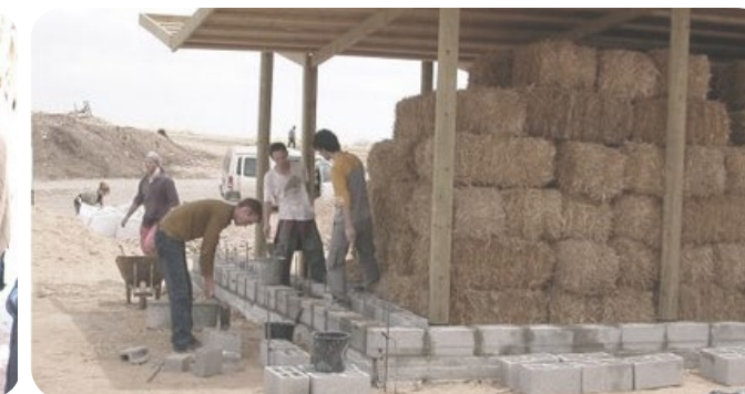
in alto destra: vista frontale al centro destra: sistemazione balle di paglia in basso destra: costruzione basamento pareti
