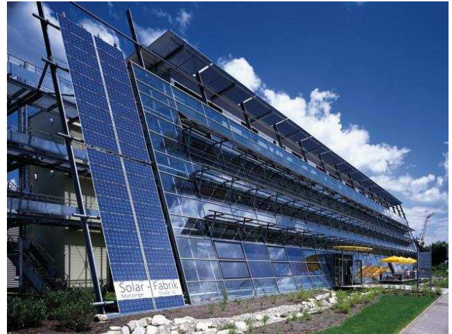
FIG. 30 SOLAR FABRIK, FRIBURGO, GERMANIA
