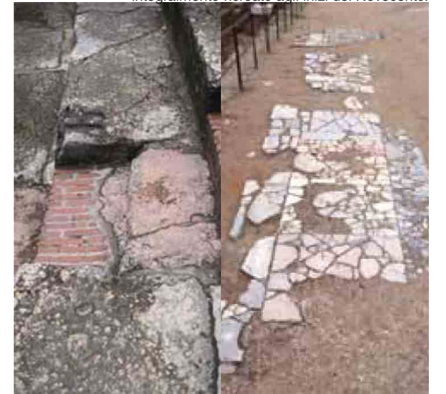
42. Pavimento in opus sectile dell'orchestra, ricostruito o integralmente ricreato agli inizi del Novecento.
