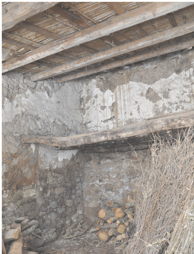
Casa ardaulese con sistema costruttivo tradizionale Presenza fotografica personale
