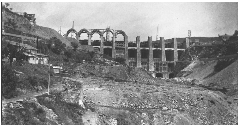
Fotografia storica della diga Santa Chiara
