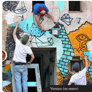
Vernice (su muro)
