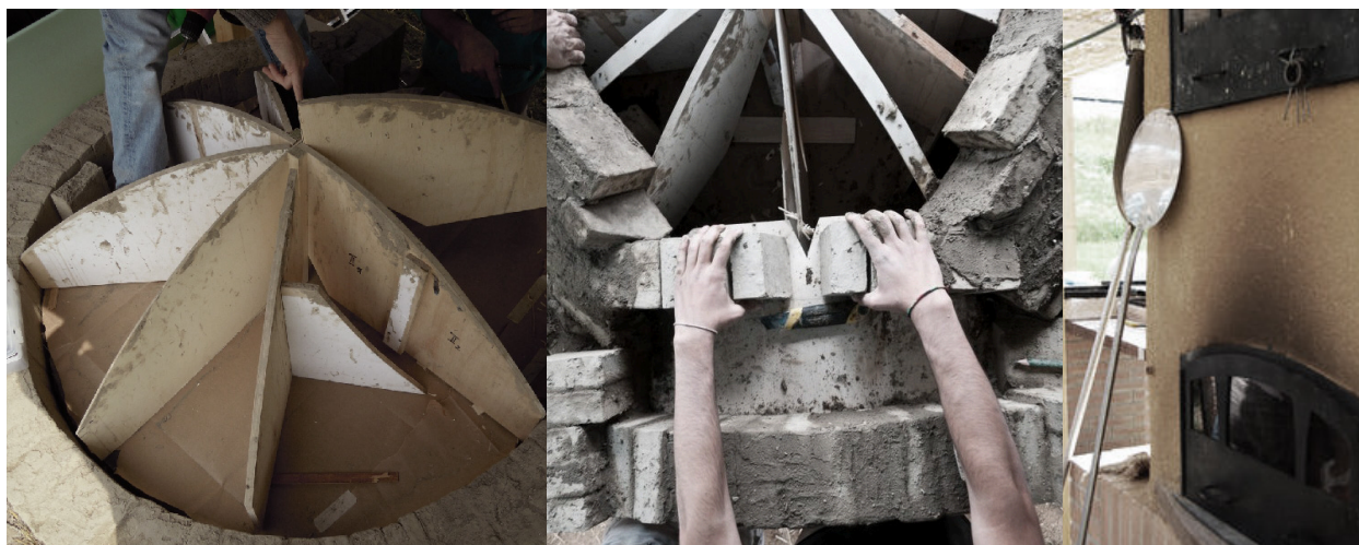
Progetto "Focolare", del collettivo Terra Terra, forno in terra cruda, PAV (Padiglione Arte Vivente), Torino
