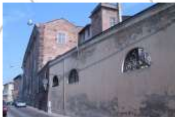
42. Piacenza, area militare dismessa, PUVAT
