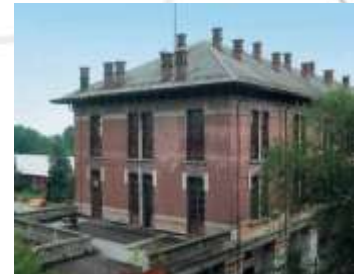
57. Casele Monferrato, Caserma Bixio in disuso, 1911-23. Casermetta ovest in muratura laterizia
