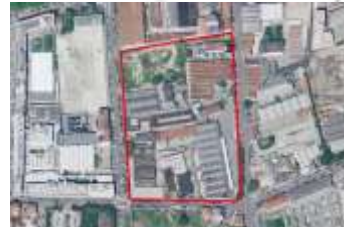
83. Milano, via Adamello (zona Porta Romana). Vista aerea di un'area dismessa
