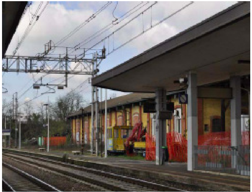
Fig. 2.10 Viasta lato ferrovia, stazione di Cassano d'Adda (MI)
