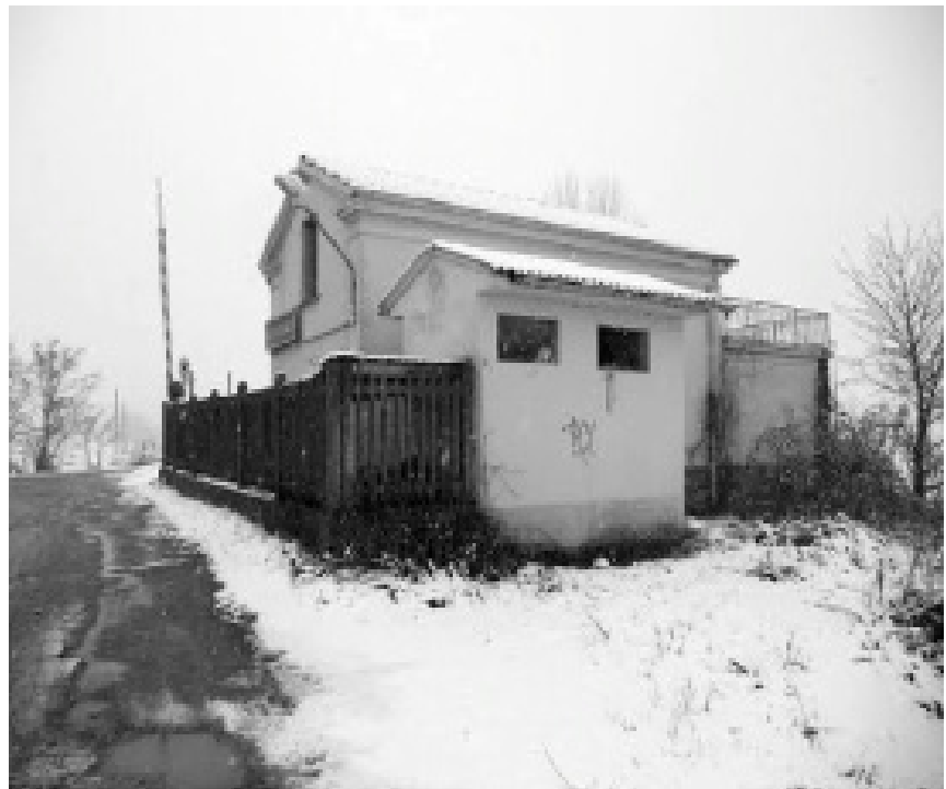
Fig. 1.1 Stazione di Albuzzano, (PV)
