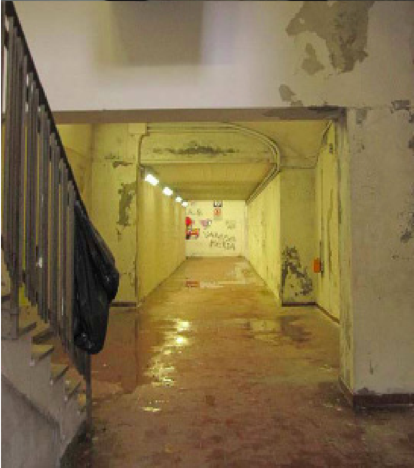
Fig. 2.9 Sottopasso, stazione di Olmenta (CR)
