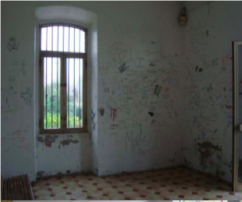
Fig. 2.2 Sala d'attesa, stazione di Remedello (BS)
