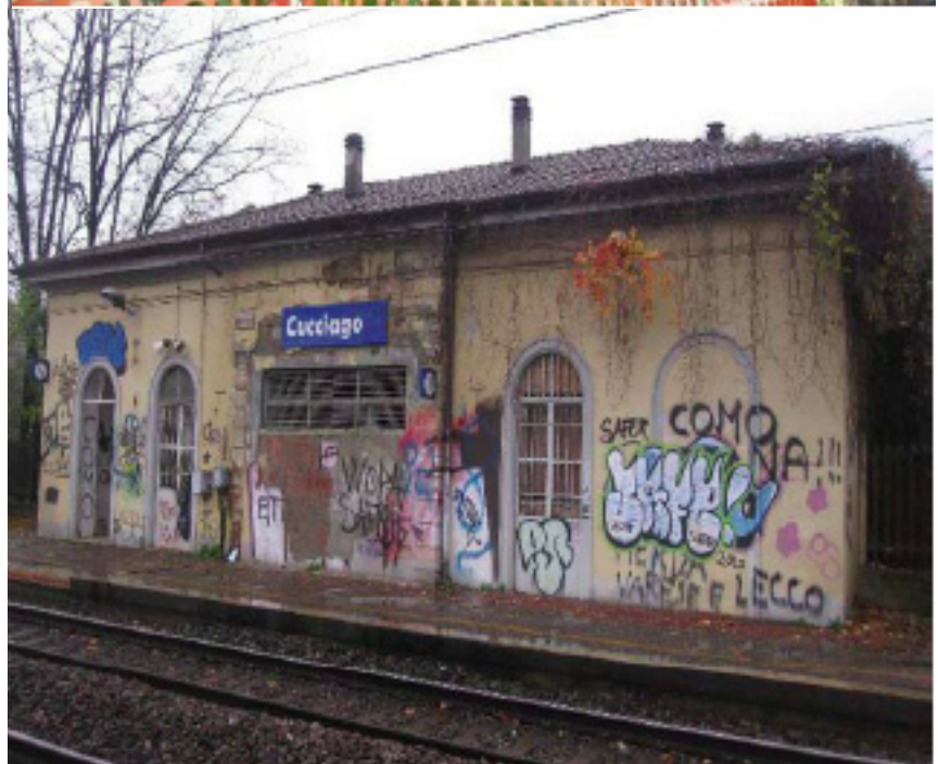
Fig. 2.7 Viasta lato ferrovia, stazione di Cucciago (CO)
