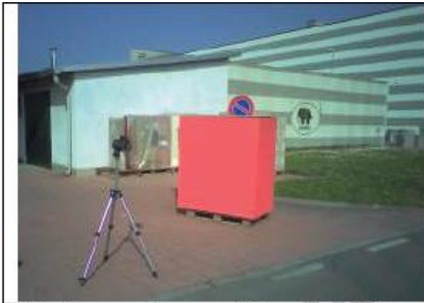
Indagini su manufatto con coefficiente di assorbimento solare medio con termocamera fissa 28/03/2012
