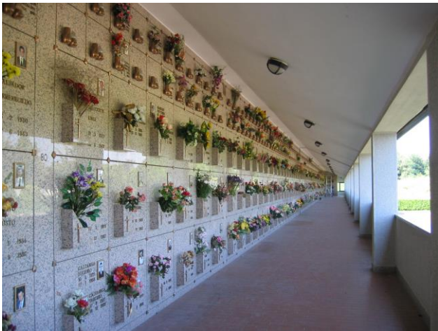
FIGURA 96 – Ampliamento cimitero realizzato
