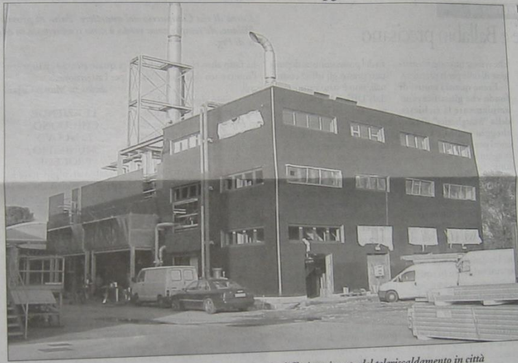
Il fabbricato che ospita l'impianto di cogenerazione per la diffusione in rete del teleriscaldamento in città
