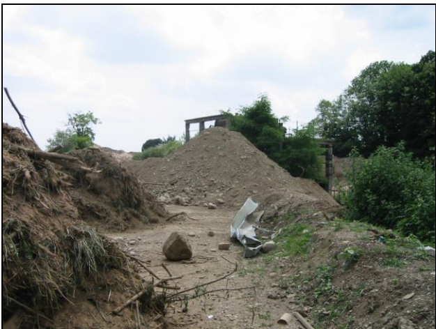
FIGURA 13 – Deposito materiali inerti
