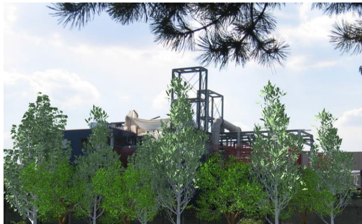
FIGURA 103 - Mimetizzazione del cogeneratore
