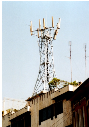
Figura 2.6: Impianto a traliccio trisetoriale
