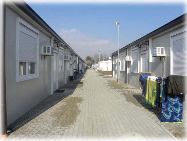
Figura 50_ Vialetto di accesso ai Moduli abitativi. Fonte: Sopralluogo del 14/02/2013
