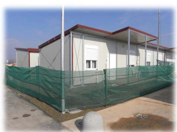
Figura 61_Recinzione creata dal fruitore del Modulo. Fonte: Sopralluogo del 14/02/2013
