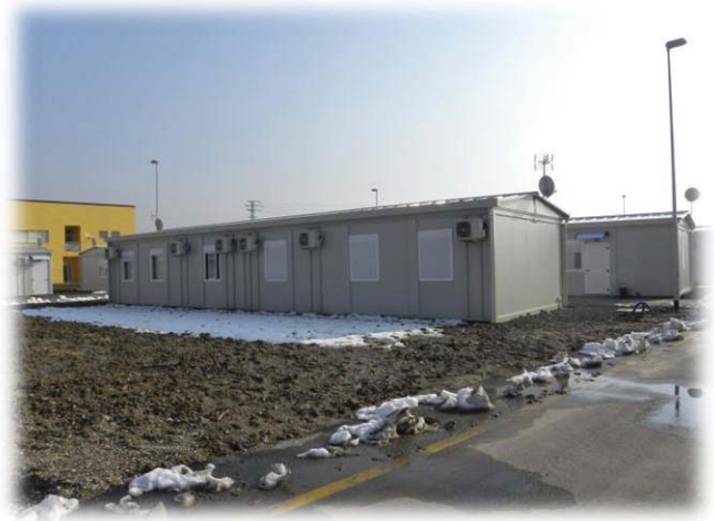
Figura 51_Vista Moduli Abitativi Provvisori Campo di Mirandola.Fonte: Sopralluogo del 14/02/2013
