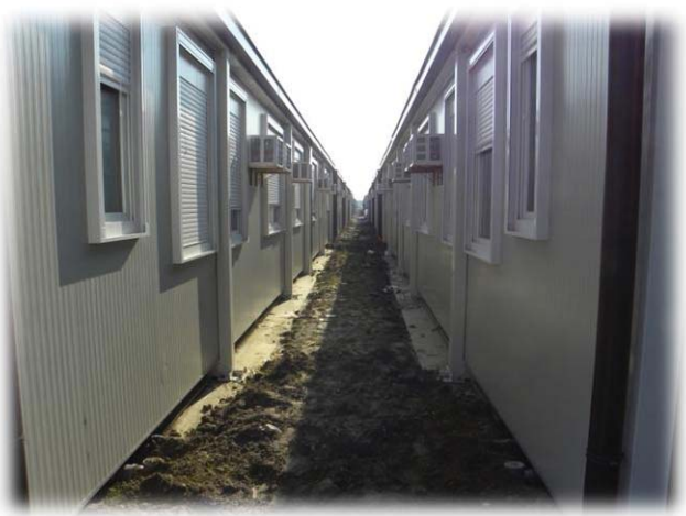
Figura 54_Spazio retrostante i moduli abitativi. Fonte: Sopralluogo del 14/02/2013
