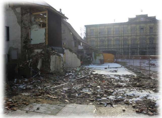
Figura 57_Visita nella zona Rossa. Fonte: Sopralluogo del 14/02/2013
