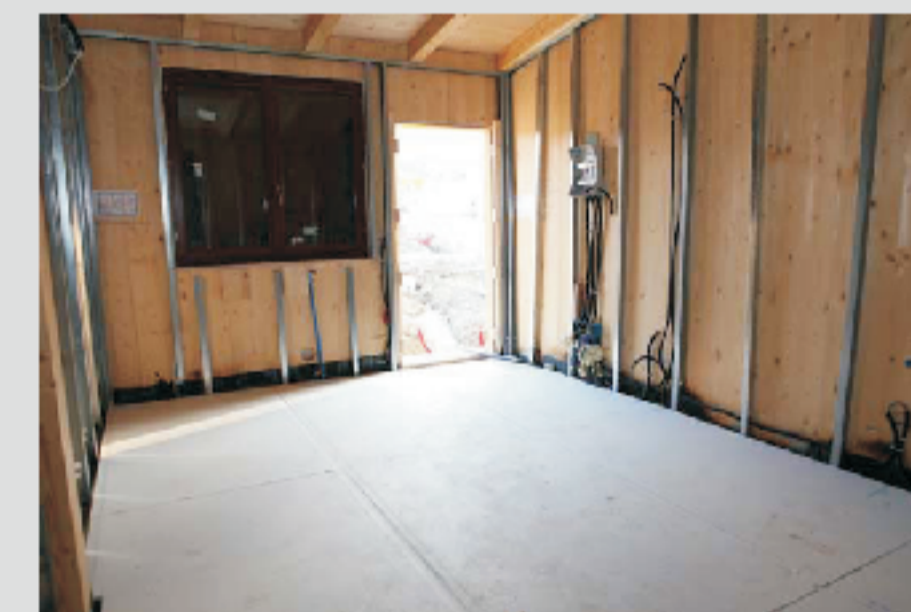
(vista interna modulo abitativo provvisorio in legno_strutture)
