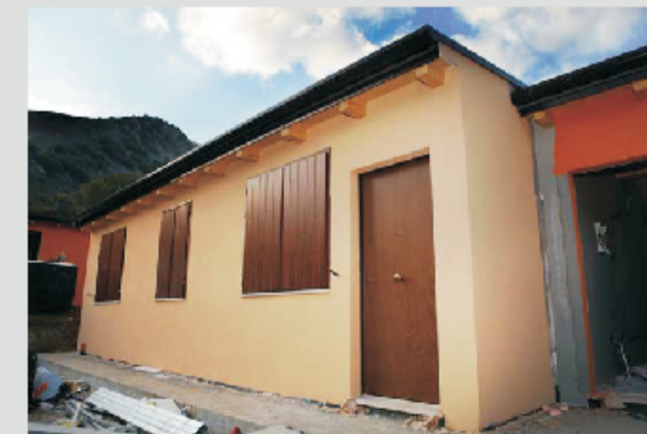
(vista esterna modulo abitativo provvisorio in legno)
