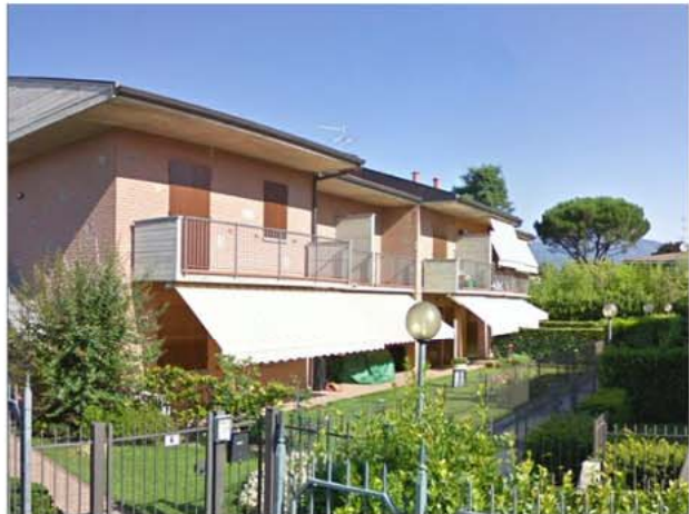
3_Vista di un'abitazione "tipo" in via Volta
