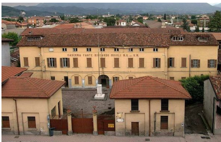
Figura 46 : Ingresso e edificio principale a corte
