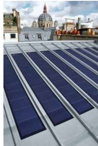
Figura 149 : Applicazione dei pannelli fotovoltaici
