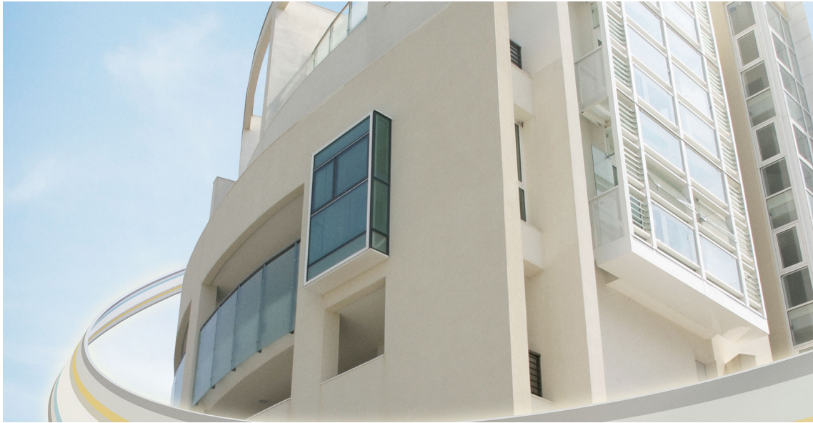
Figura 61 : Casa residenziale rivestita in Aquapanel
