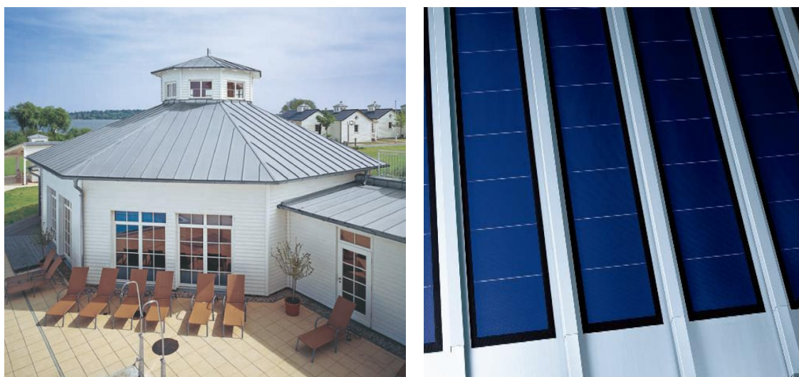
Figure 59 e 60 : Pannelli di Rhein zinc ed esempio applicativo
