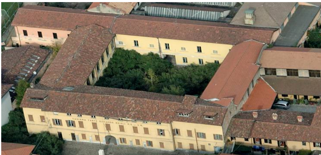
Figura 54 : Vista dall'alto dell'edificio a corte esistente
