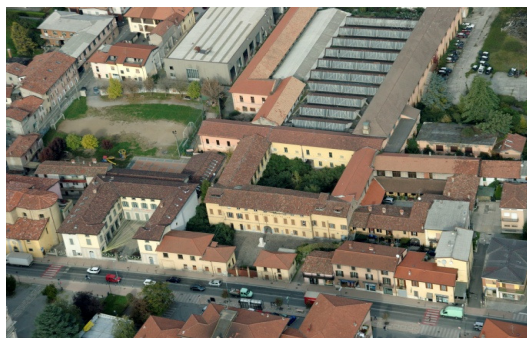
Figure 2- 3 : Fotografie del fronte e dall'alto
