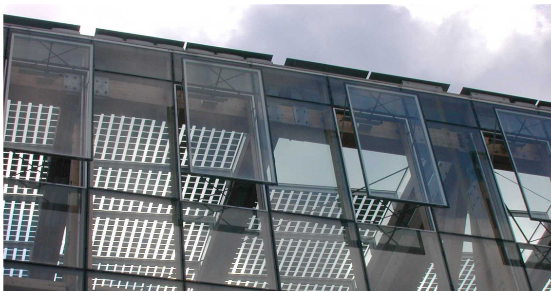
Figura 66 : Serramenti apribili del rivestimento esterno
