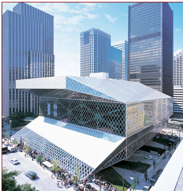
Figura 3.2 - Vista esterna della Seattle central library, OMA, Seattle, Stati Uniti, 2004.
