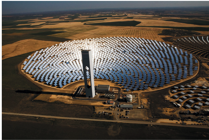
Figura 1.8: Vista aerea della torre solare PS10 e del relativo campo specchi (ABENGOA)
