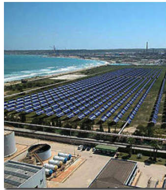
Figura 1.3: Impianto Archimede situato a Siracusa
