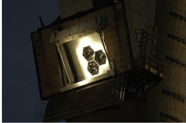
Figura 1.10: Immagine dell'impianto di test SOLGATE a CESA 1 [17]
