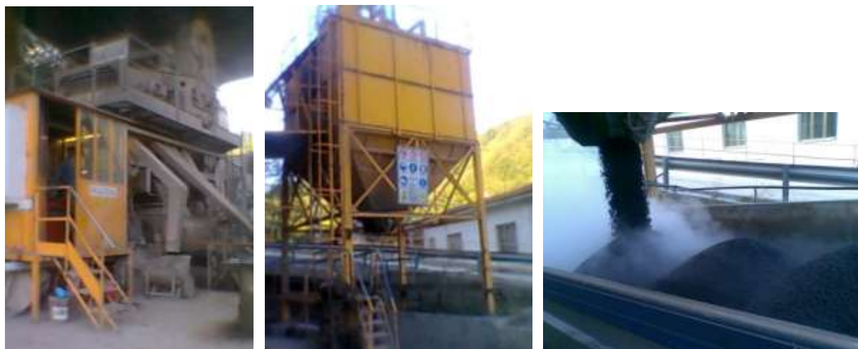
Figura 6.1-8: Fase di produzione in impianto e carico del materiale su Autocarro
