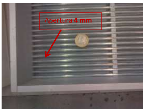
Figura 3.1-16: Dettaglio dell'apertura di un setaccio a barre
