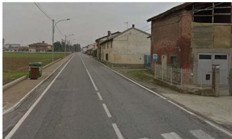
Figura 6.1-7: Veduta della tratta dalla strada, direzione Località Sale
