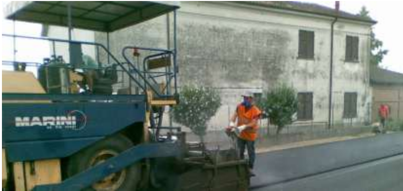
Figura 6.1-9: Finitrice in opera durante la stesa del conglomerato contenente il Compound
