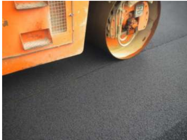
Figura 6.1-11: Rullo vibrante durante la compattazione del conglomerato contenente il Compound studiato
