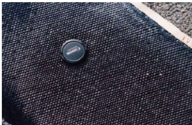
Figura 2.5-7: Dettaglio della superficie di una pavimentazione stampata
