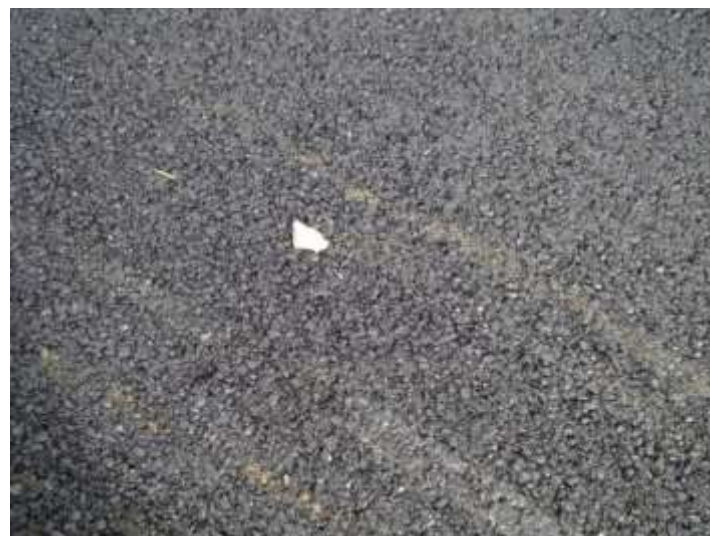
Figura 6.1-12: Dettaglio della tessitura del conglomerato appena compattato
