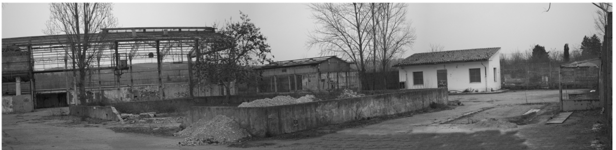
Fig. 66 Ex Edifici industriali Lungadige Attiraglio, area campeggio - Verona Stato di Fatto
