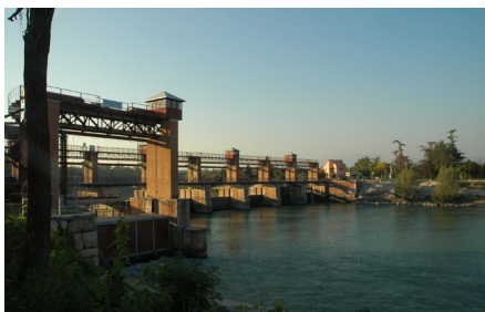
Fig. 46 Diga del Chievo Lungadige Attiraglio - Verona
