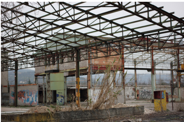
Fig. 44 edifici abbandonati Lungadige Attiraglio - Verona
