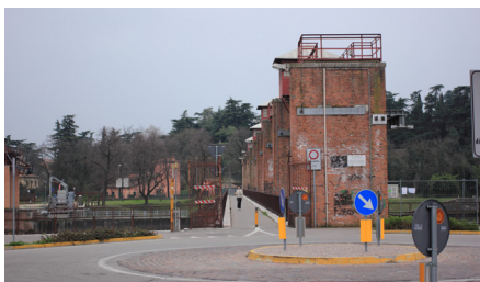
Fig. 45 Diga del Chievo Lungadige Attiraglio - Verona
