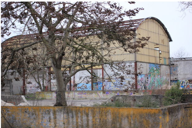
Fig. 43 edifici abbandonati Lungadige Attiraglio - Verona
