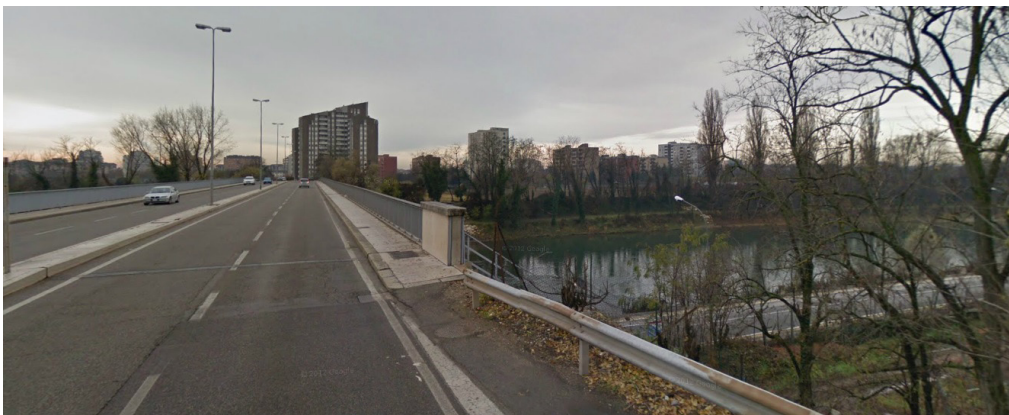
Fig. 36 Ponte Unità d'Italia - Verona
