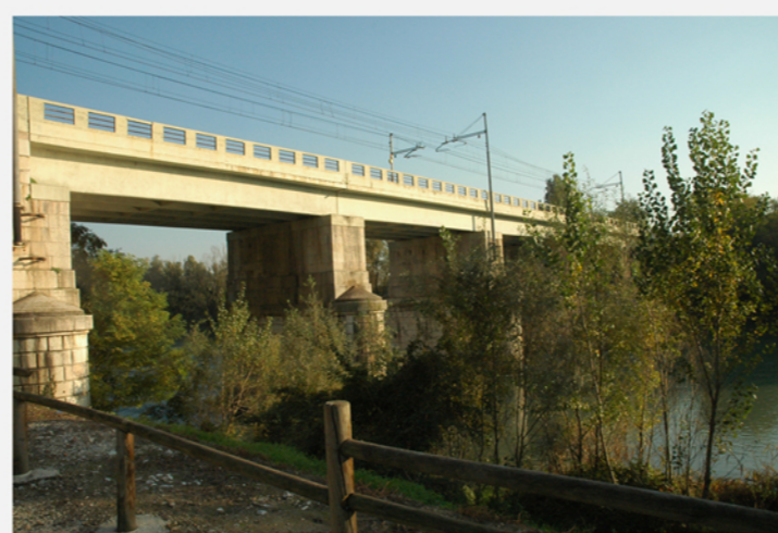
PONTE FERROVIA PARONA
