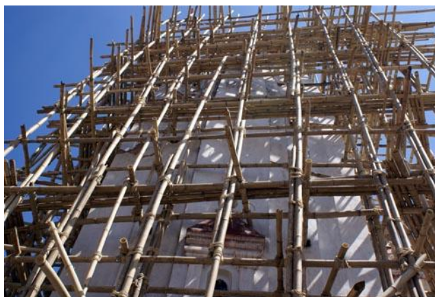
Figura 23. Uso di ponteggi in bambù per i moderni edifici.
