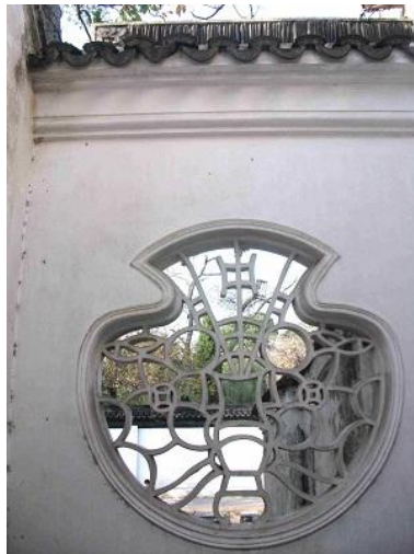
Figura 116. Finestra a grata.
