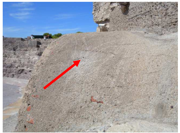
Figura B.20: Indicazione del punto di prelievo del campione 2-VE-6(4) sul muro, lato ovest.
