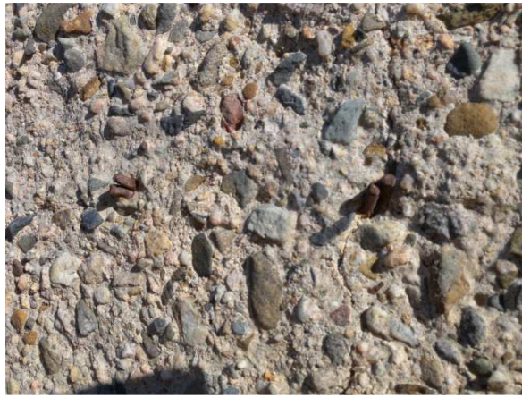
Figura B.26: Particolare degli inserti metallici che fuoriescono dalla superficie del calcestruzzo.
