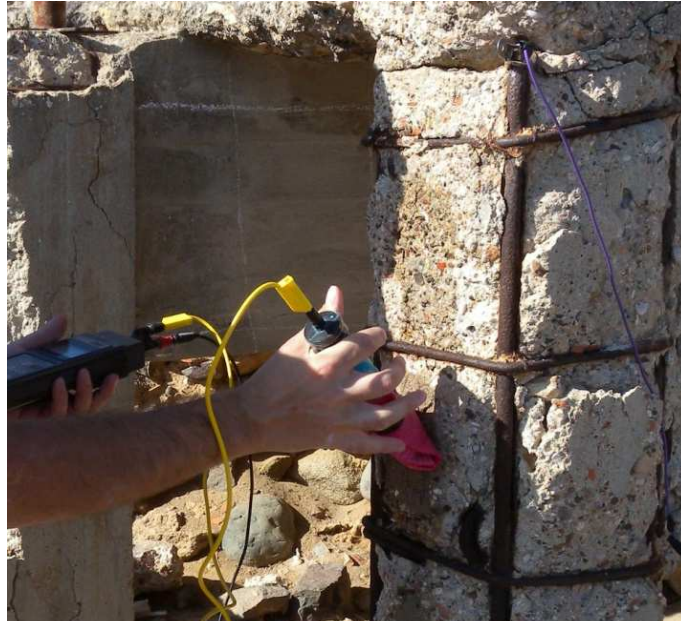
Figura 3.1: Misura del potenziale in situ sulla faccia nord-ovest del pilastro A della zona 1.
