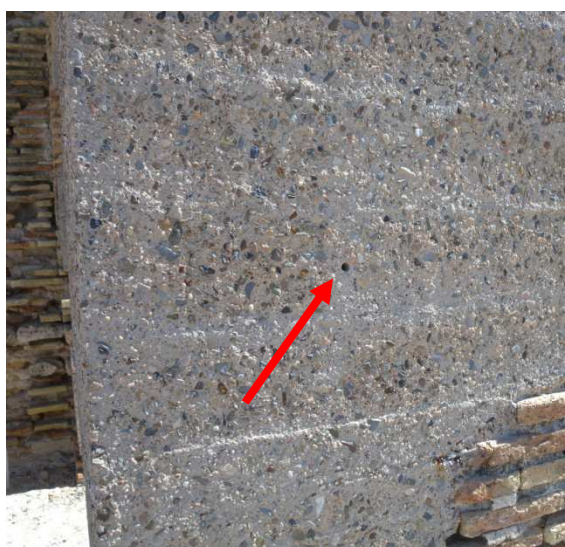
Figura B.30: Indicazione del punto di prelievo del campione 3-V-3(4) sul muro, lato ovest.
