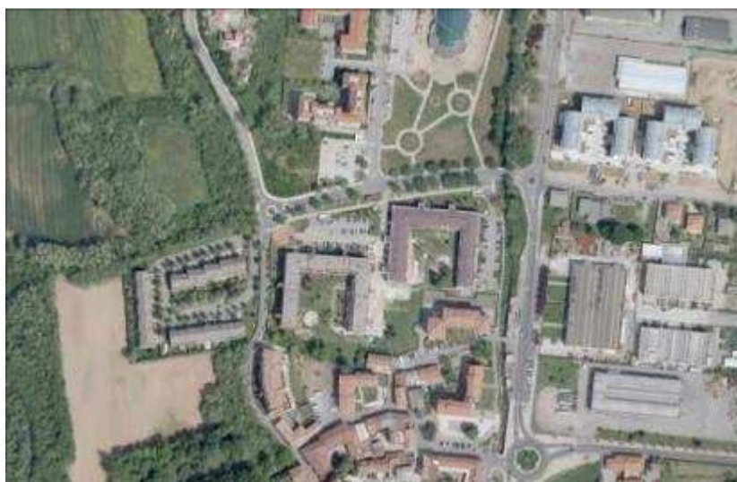
Fig. 54 - Il tipo a corte aperta utilizzato nel progetto di Rosselli del 1975 (ortofoto, 2008 - Limbiate)
