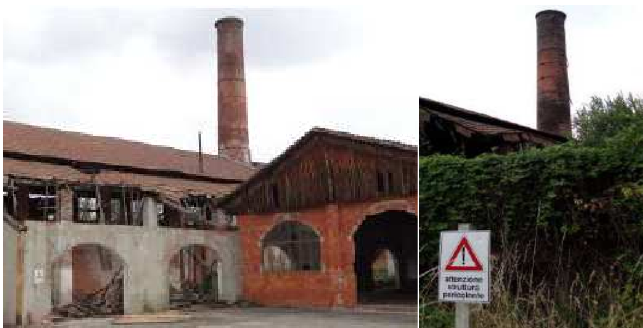
Fig. 102 - Fornace Aliberti: il cortile e, a destra, dalla recinzione esterna
