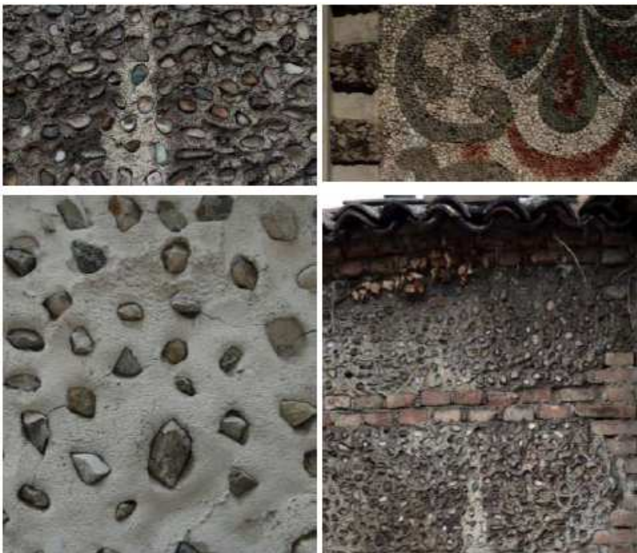
Fig. 106 - Esempi di parete tratti dai muri di cinta di villa Mella e della fornace Antonini
