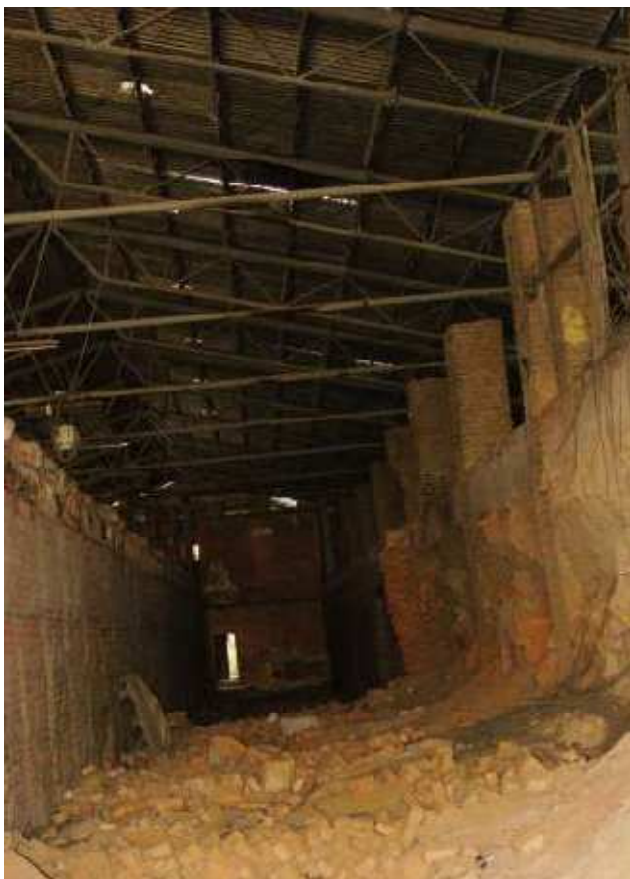
Fig. 103 - Fornace Faccioli (interno)
