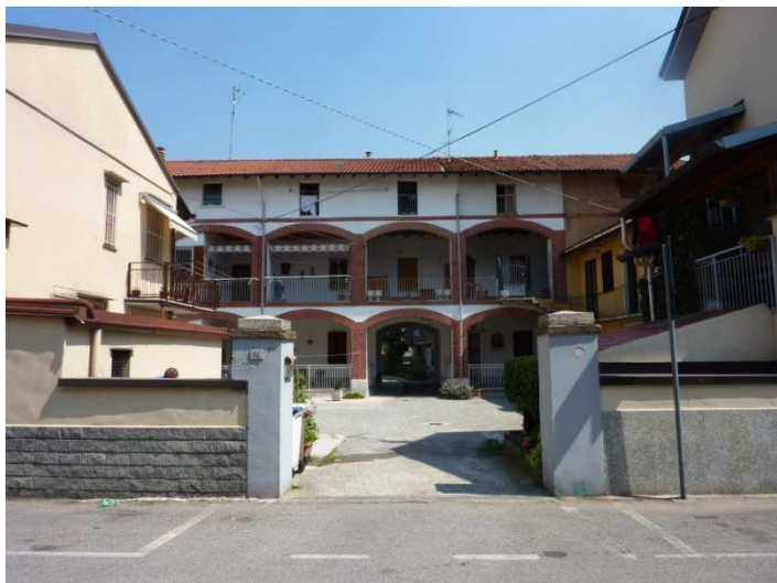
Fig. 145 - Il manufatto di via Trento, civico 14. Intervento di recupero unitario
