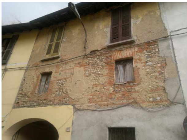
Fig. 162 - Via Bolzano, edificio residenziale
