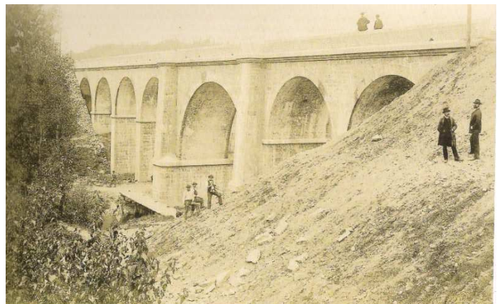
Figura 9 - Linea ferroviaria Como-Cantù-Lecco, Costruzione del ponte sul Lambro, 1887
