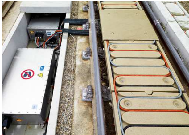
Figura 25 – Sistema di alimentazione lato terra
