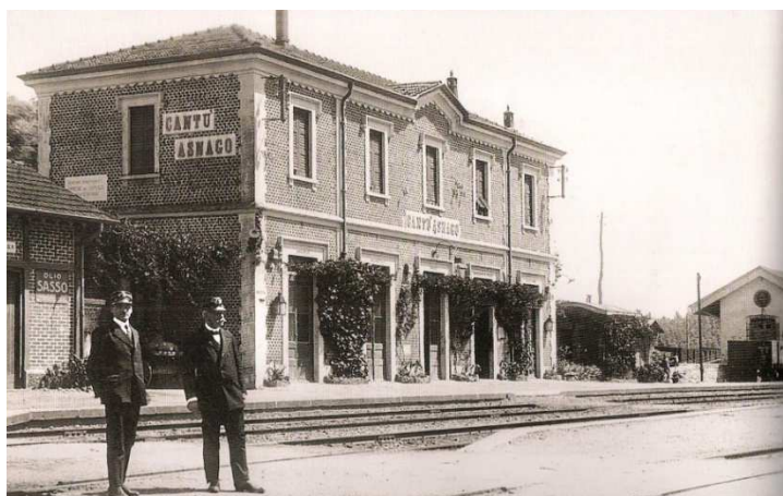
Figura 7 – La stazione ferroviaria di Cantù – Asnago in una foto scattata nel 1920
