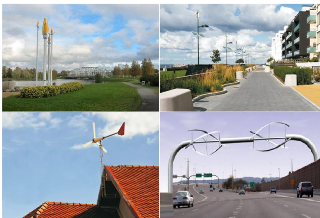
Figura A.2.46 Alcuni esempi di turbine micro-eoliche integrate in ambito urbano
