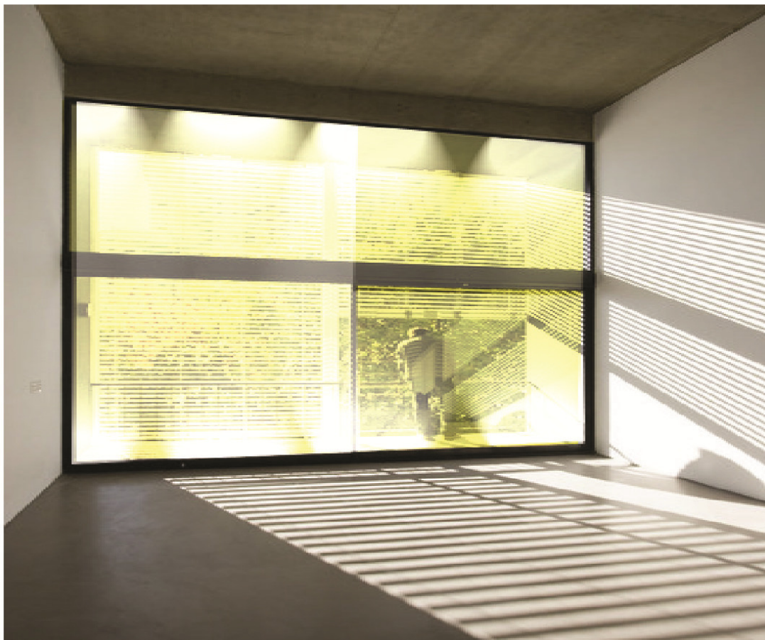
Riferimento 45 - Sistema di illuminazione multidirezionale (sul perimetro del serramento). (Adamo-Faiden, Edificio Arribeños, Buenos Aires).
